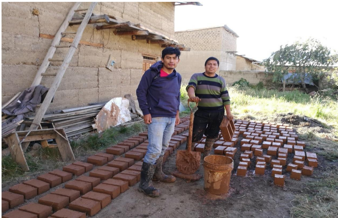
Fotografía N° 11. Tesistas en proceso de fabricación de los adobes reforzados.
