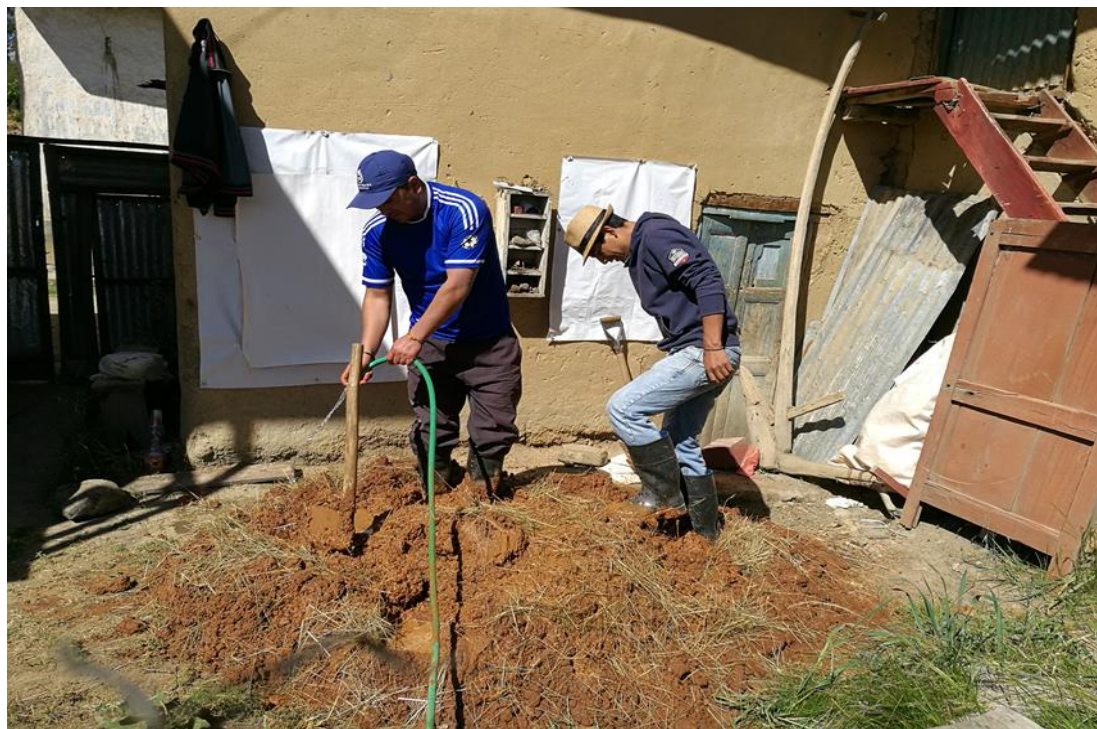
Fotografía N° 10. Preparación del barro para la fabricación del adobe reforzado.
