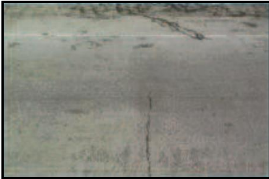
FIGURA 36: fisuras medias
