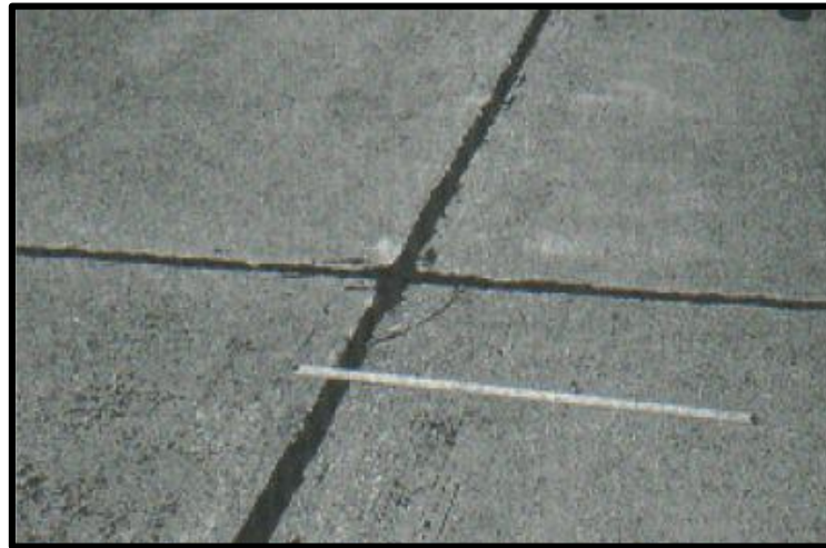
FIGURA 22: Descascaramiento de baja severidad
