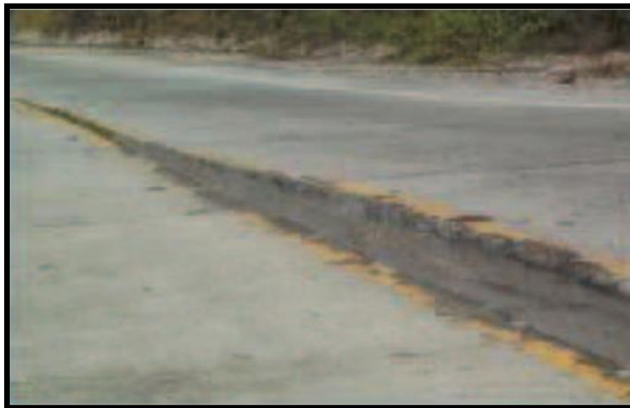
FIGURA 31: gravedad 3; reducción drástica de la velocidad
