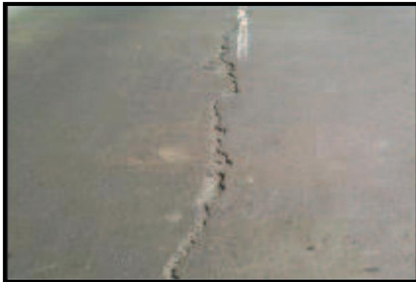
FIGURA 34: Fisuras gruesas
