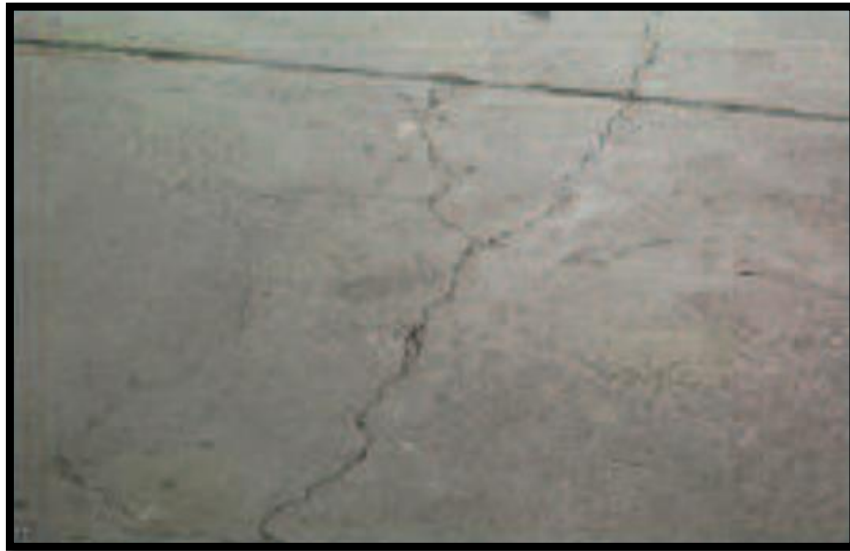
FIGURA 33: Fisuras medias
