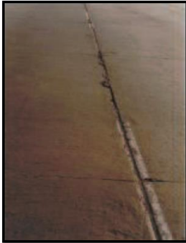
FIGURA 29: gravedad 1; sensible al usuario sin reducción de la velocidad
