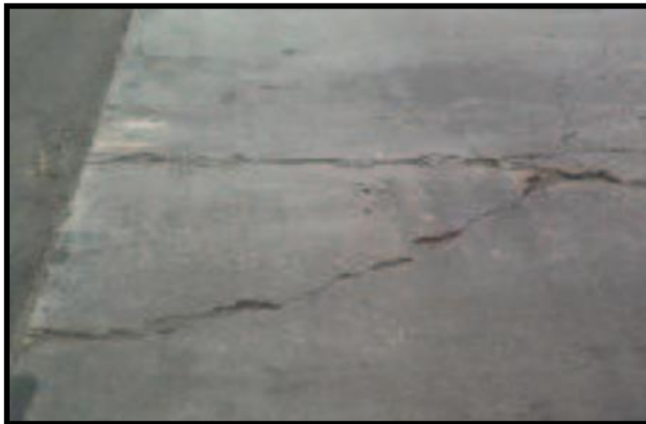
FIGURA 37: fisuras gruesas
