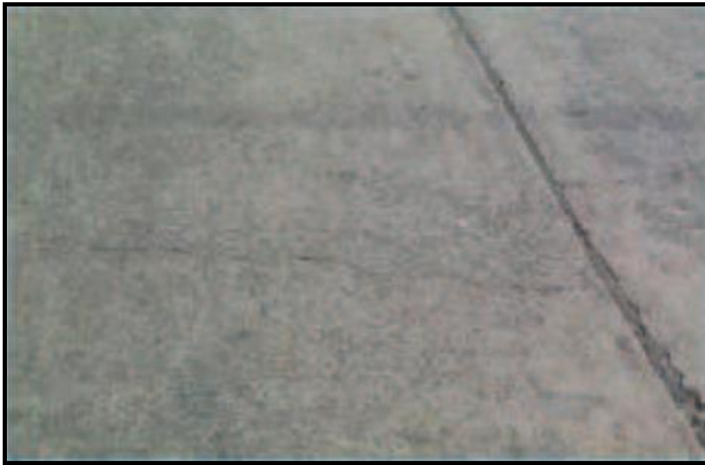
FIGURA 35: fisuras finas
