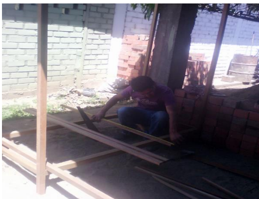
Foto 1. Construcción de los módulos
