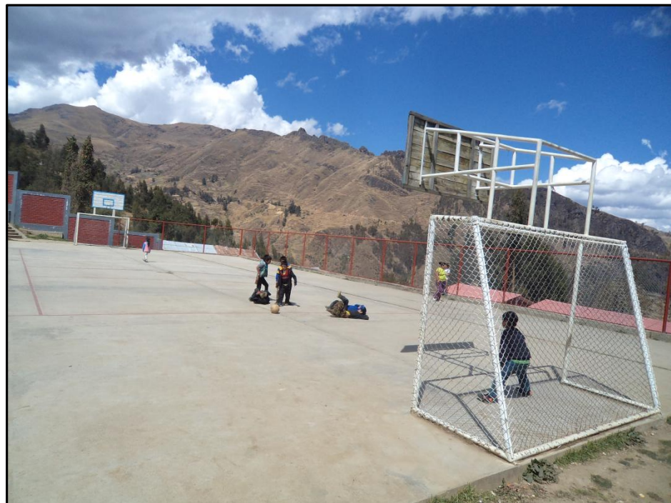
Fotografía N° 07: Vista de la losa deportiva de la I.E. Primaria N° 32230 – Localidad de Marías
