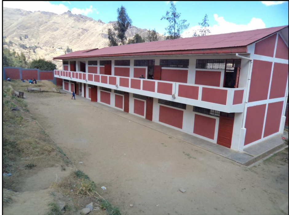
Fotografía N° 06: Vista de las aulas de la I.E. Primaria N° 32230– Localidad de Marías
