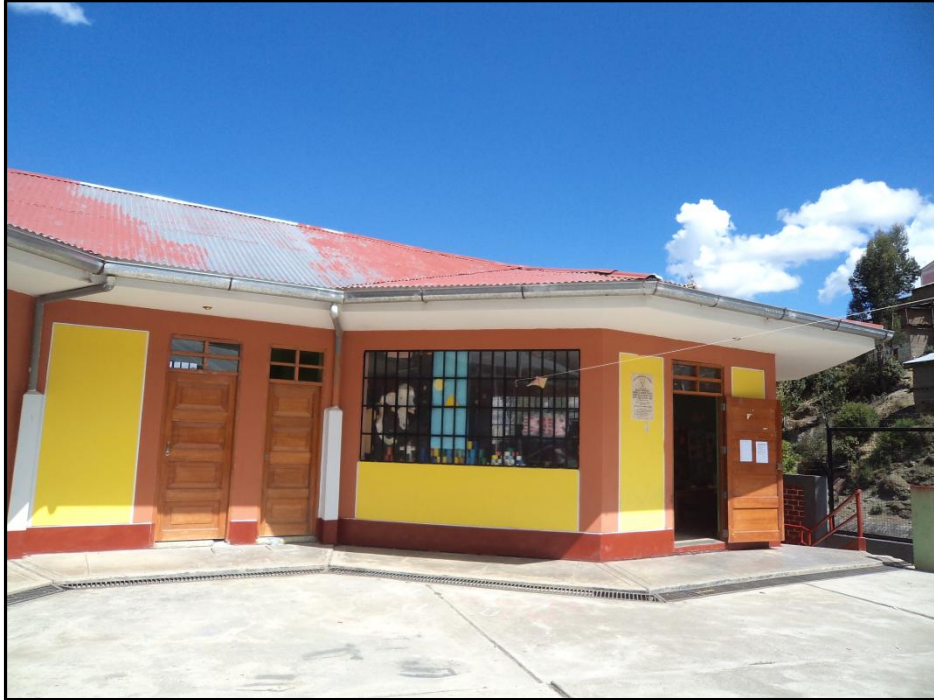
Fotografía N° 03: Vista ingreso de la infraestructura del nivel inicial – Localidad de Marías
