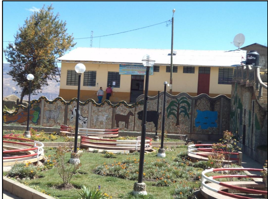
Fotografía N° 11: Vista de la Infraestructura de material rústico del centro de salud de la Localidad de Marías
