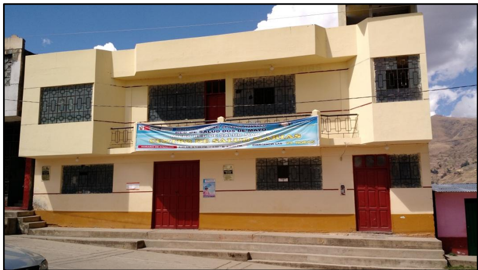
Fotografía N° 10: Vista de la Infraestructura del centro de salud de la Localidad de Marías
