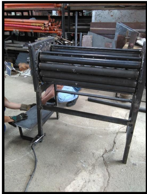
Figura 21.- Union de la estructura superior con la estructura inferior. Figura 22.- Colocando la base para el motor.
