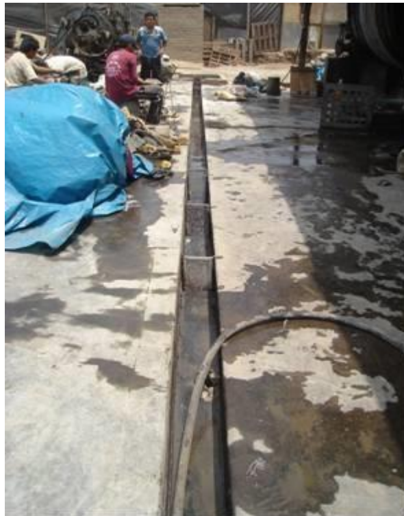
Foto 2.- Canaleta de desagüe con trampas Cueros Tauro – Huachipa Set. 17
