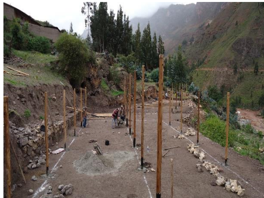
Fig. N° 19. Puesta de postes laterales y centrales.
