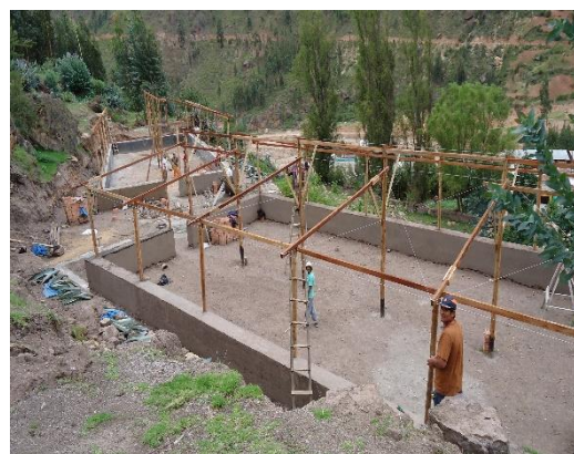
Fig. N° 21. Construcción del techo.
