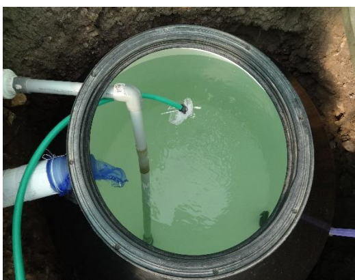
Fig. N° 69. Depósito de agua.
