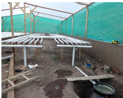
Fig. N° 29. Construcción final del Sistema NFT.
