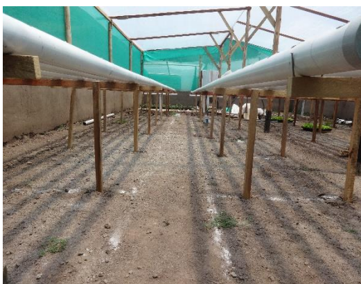
Fig. N° 28. Enfilado de tubos de PVC.
