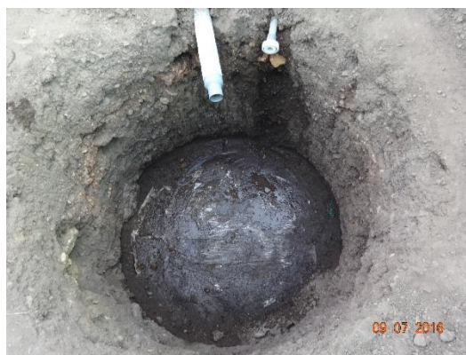
Fig. N° 39. Hoyo para el establecimiento del tanque.
