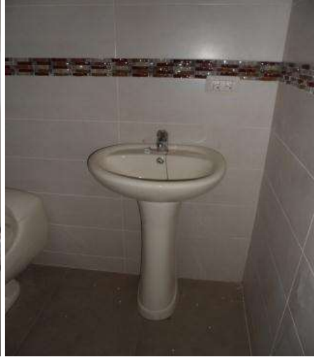
ACABADOS EN BAÑO 3ER PISO DUPLEX
