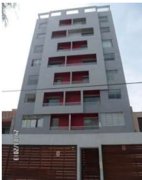
EDIFICIO terminado. "RESIDENCIAL SUCRE – LA MAR"
