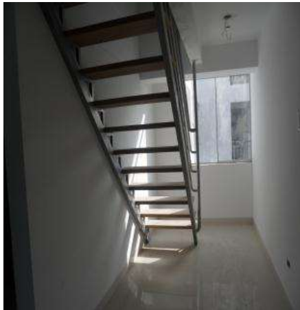
VISTA ESCALERA A LOS DORMITORIOS DUPLEX PROCESO CONSTRUCTIVO
