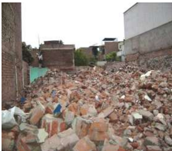
Construcción antigua demolida Vista interior Enero – 2008.
