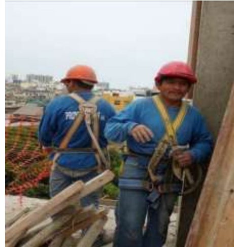
Trabajadores en el piso 7º
