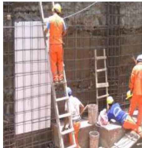
Colocar acero primer nivel enero-2012
