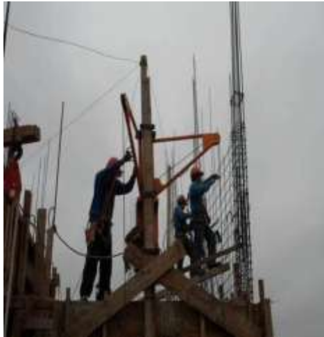
Construcción de Placas piso 7º Av. Manuel Cipriano Dulanto (Ex. Av. La Mar) N° 1036-1042 – Pueblo Libre
