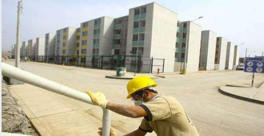
Vivienda de tipo social, vivienda de construcción masiva, departamentos de 65 m 2
