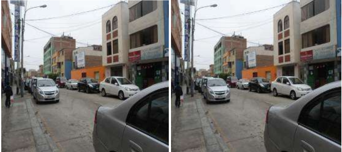
Calle: Jr. San Martín cuadra 7 – Residencial “Brisas de Magdalena” Lugar donde se construirá un edificio multifamiliar de 10 niveles
