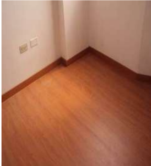
ACABADOS DE PISOS
