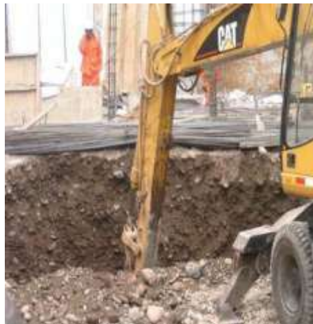
Excavación masiva – Diciembre 2011
