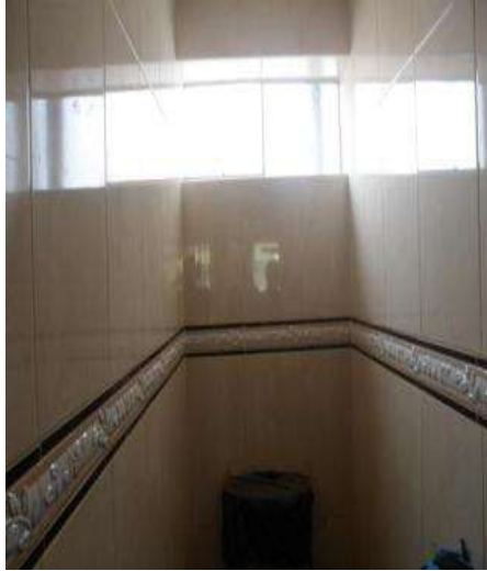
ENCHAPADO PARED Y PISO DE SSHH
