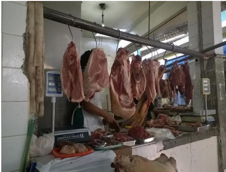
FOTO N° 10: La infraestructura es deficiente por el estado deteriorado de las mayólicas.
