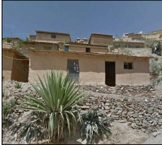
Imagen N° 108: Fachada de Vivienda Actual. Fuente: Elaboración Propia.
