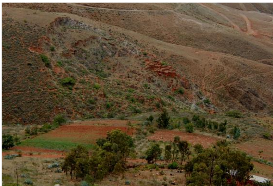
Imagen N° 42: Vista hacia el norte que muestra una zona de deslizamiento activo en la margen izquierda de la quebrada Jactay. Nótese el tipo de suelo residual aprovechado por áreas de pastos y cultivos.
