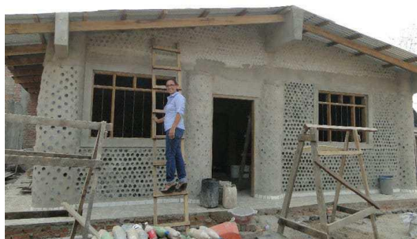
Figura 5. Proceso constructivo y vivienda terminada con botellas PET en Bolivia
