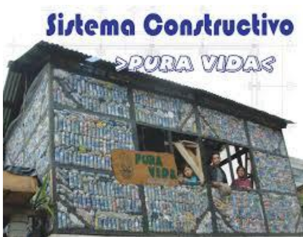
Figura 8. Vivienda terminada mediante el sistema constructivo Pura Vida
