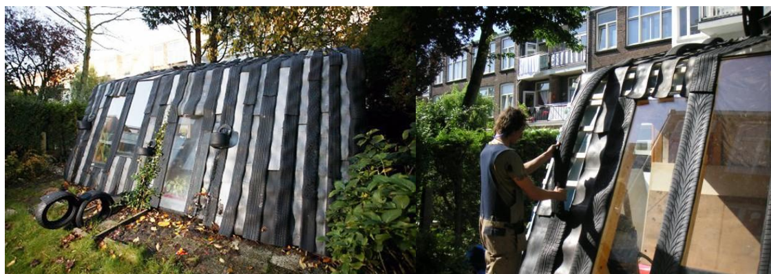
Figura 12. Maison Gomme, vivienda a base de franjas de neumáticos
