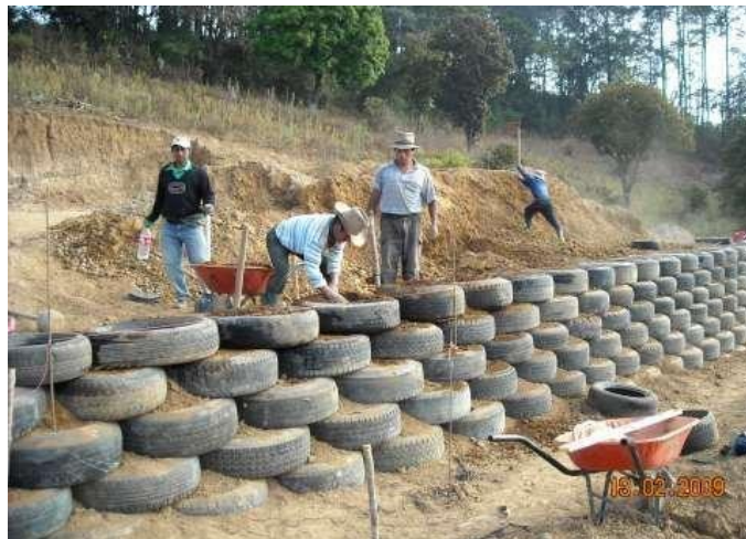
Figura 11. Muro de contención con neumáticos y tierra
