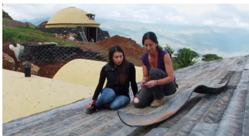
Figura 14. Techo de neumáticos en la vivienda de Choachí - Colombia
