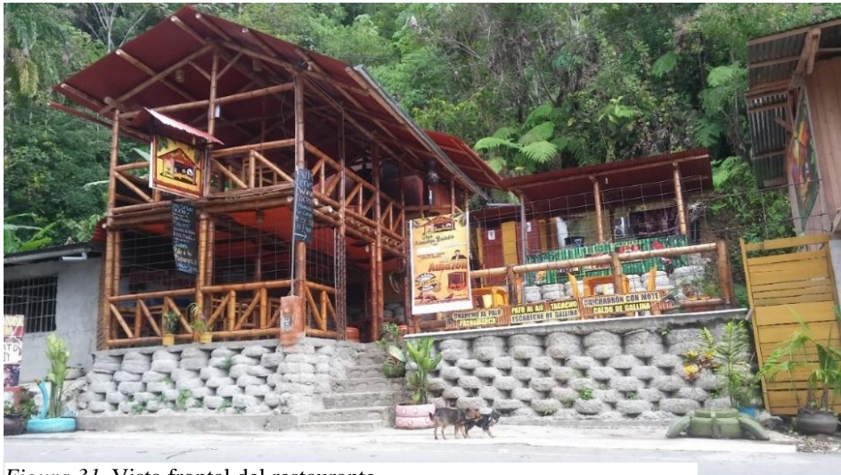
Figura 31. Vista frontal del restaurante Fuente: archivo personal
