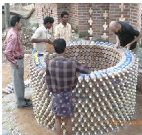
Figura 3. Construcción del primera tanque reservorio de agua en la India
