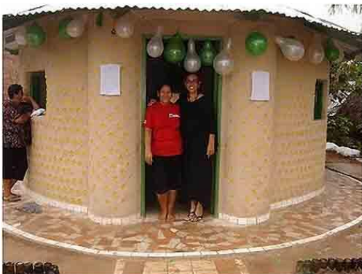
Figura 6. Primera vivienda construida con botellas PET en Bolivia
