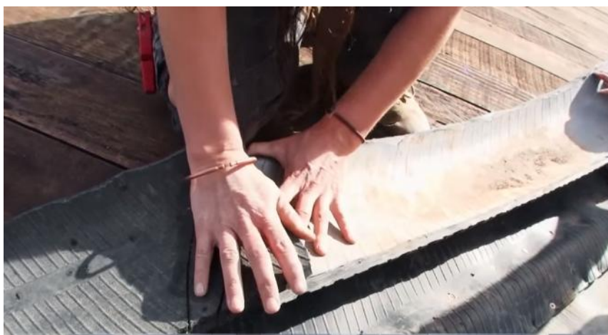
Figura 13. Instalacion de neumático en techo de la vivienda de Choachí - Colombia
