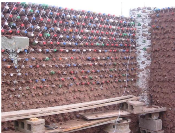
Figura 4. Muro de la primera vivienda en Honduras (2001)
