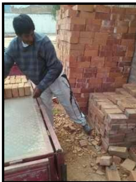
Figura 51. Transporte de las unidades de albañilería.
