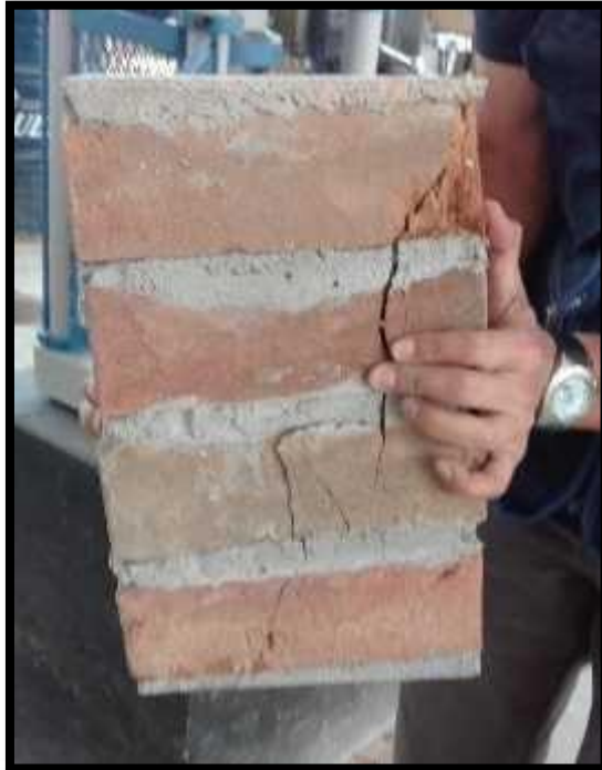
Figura 32. Grieta vertical vista lateral – Artesanal.
