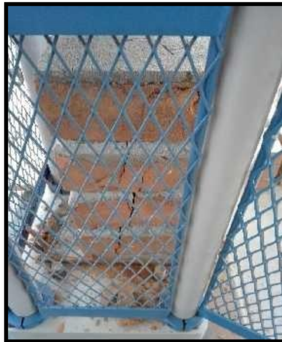
Figura 76. Ensayo a compresión axial para 2 hiladas en prismas de Albañilería.
