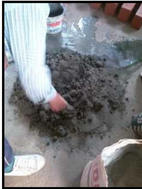
Figura 66. Preparación de la Mezcla
