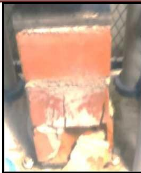
Figura 44. Falla por trituración vista frontal – Semi industrial.
