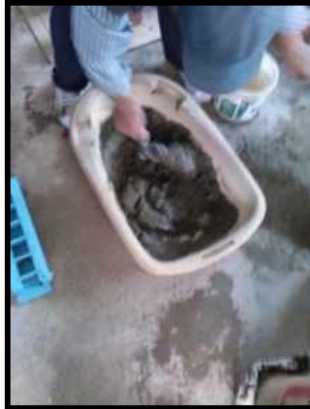
Figura 16. Mortero en proporción 1:0:4 (cemento: cal: arena)
