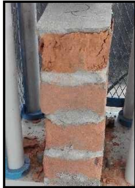
Figura 41. Falla por trituración vista frontal – artesanal.
