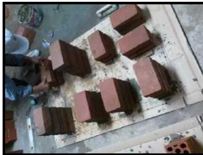
Figura 72. Construcción de los prismas de albañilerías.
