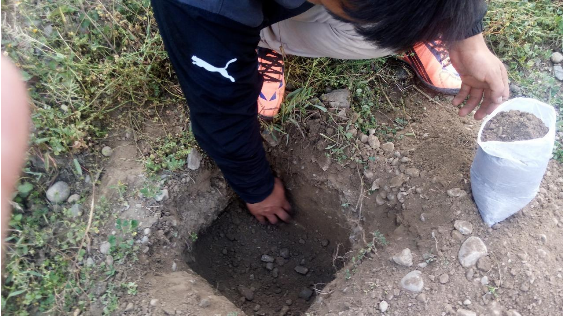
FOTO N° 04. Apertura de calicatas de chequeo
