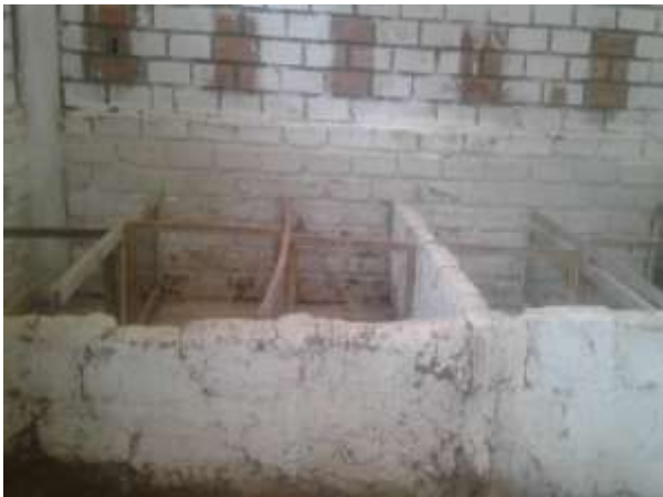
Figura 3. Refacción del galpón
