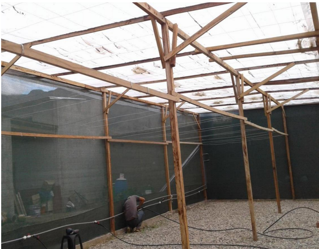
Figura 72. Se aprecia la instalación de red de tuberías del sistema de riego.
