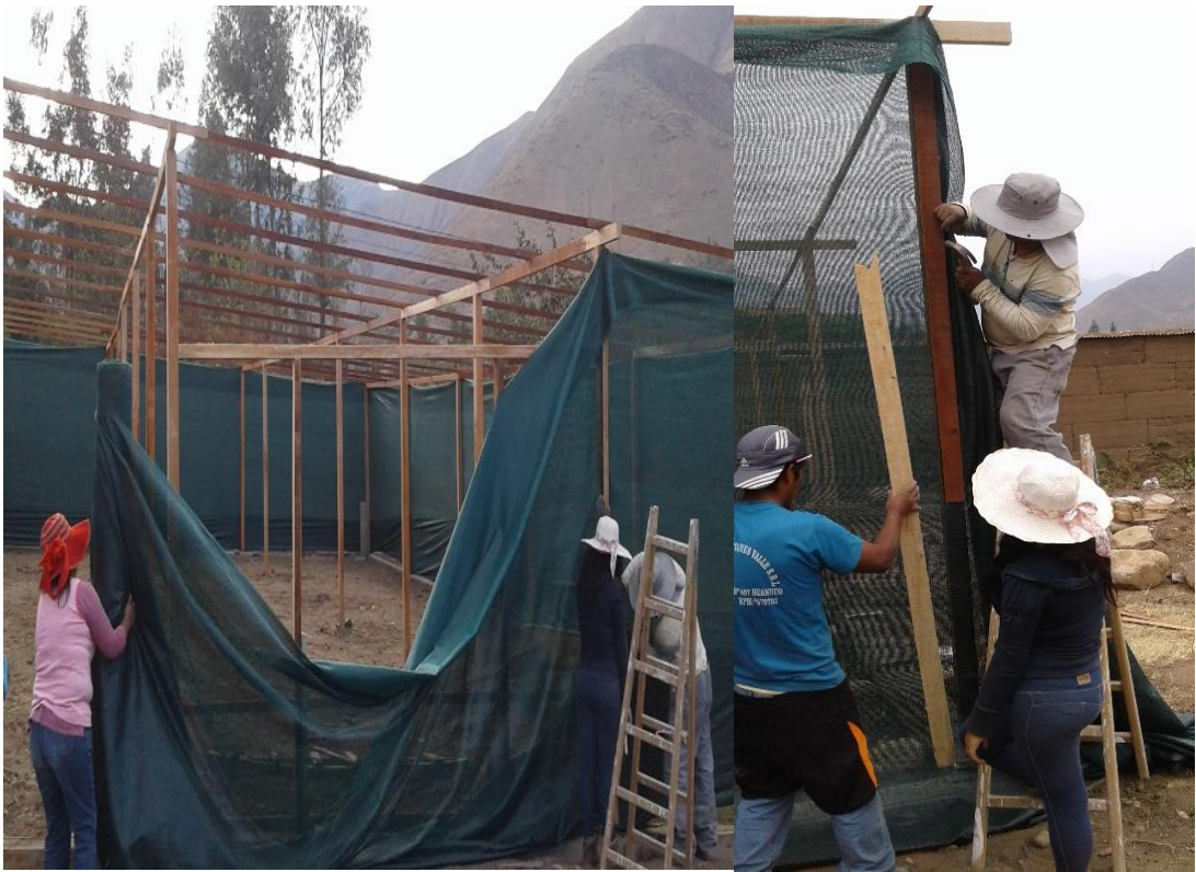
Figura 68. Colocado de la malla rashell rodeando el perímetro del cobertor.
