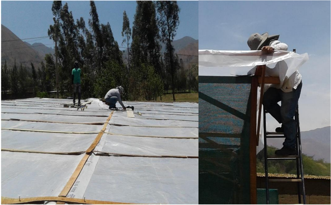
Figura 69. Techado del cobertor con el material de agrofilm, con listoncillo de madera.
