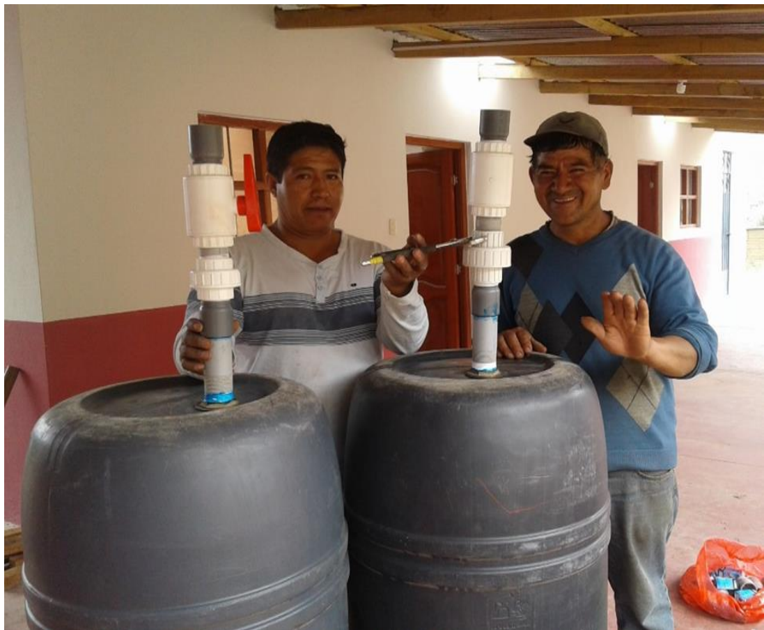
Figura 70. Instalación de los tanques de agua.
