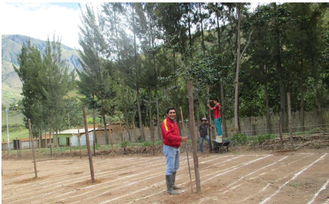
Figura 06. Plantado de postes
