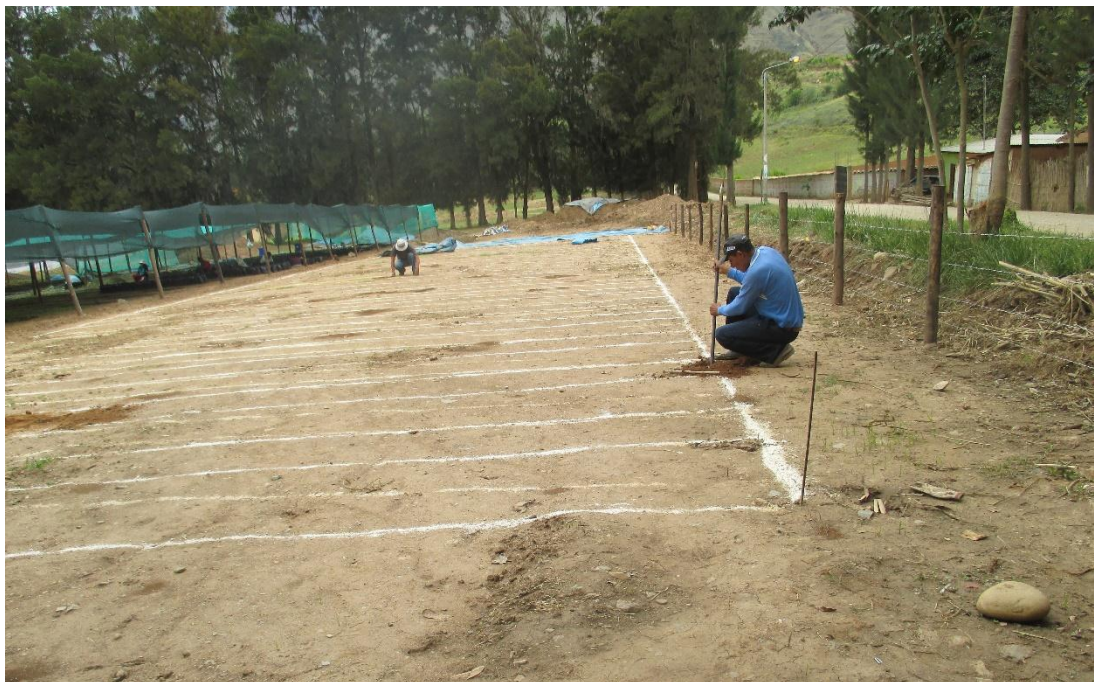
Figura 05. Hoyación para el plantado de postes
