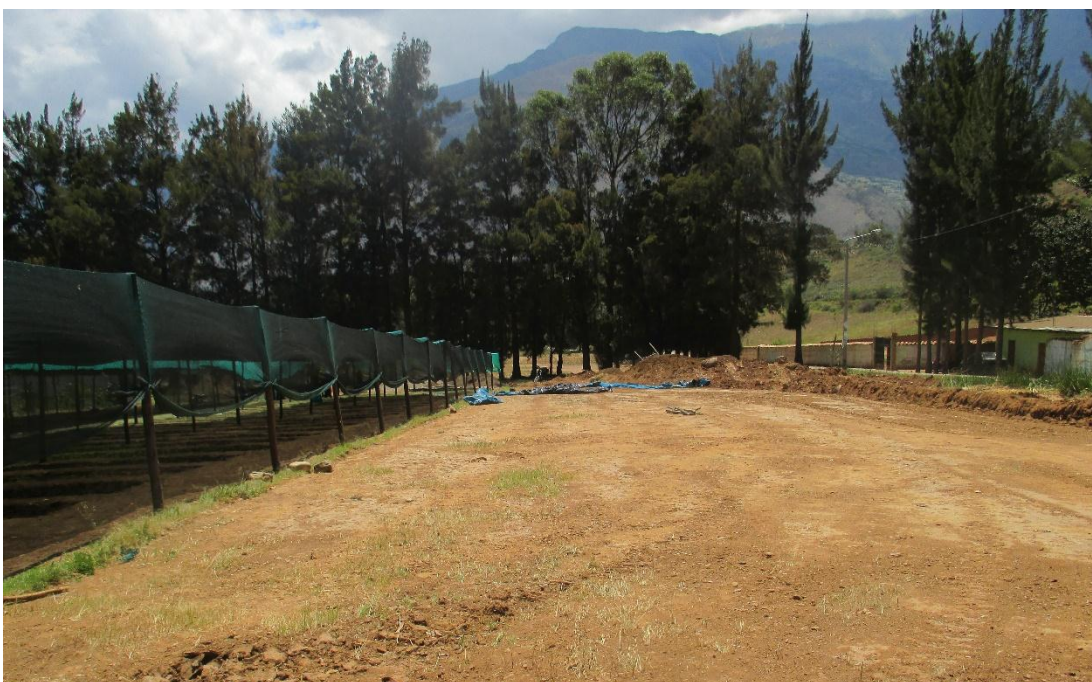
Figura 02. Nivelación del terreno
