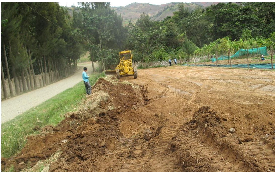
Figura 01. Selección y nivelación del terreno
