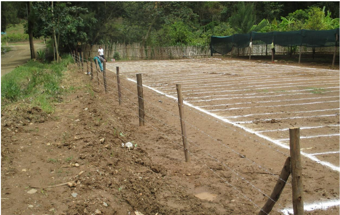
Figura 04. Nivelación y trazo del terreno
