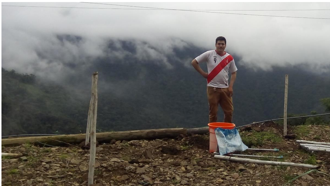
Figura A5. 2. Construcción del atrapanieblas y su respectivo cerco Nota. Se observa el contenedor del atrapanieblas envuelto con plástico, esto para proteger el equipo de medición arduino Fuente: Propia
