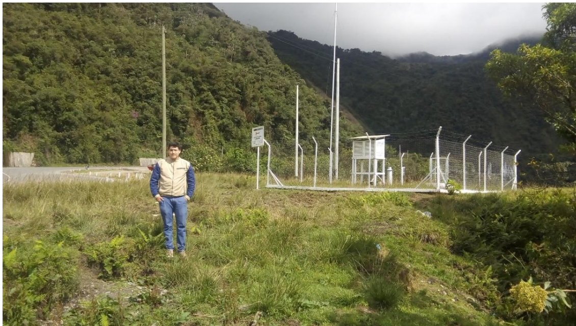
Figura A5. 1. Inspección de campo y ubicación de la estación meteorológica de Carpish Nota: Se observa los equipos de medición de la estación meteorológica, Fuente: Propia
