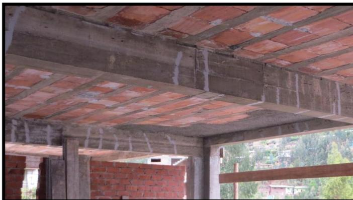
*Fotografía 8. Presencia de grietas en vigas peraltadas en el módulo II.*
