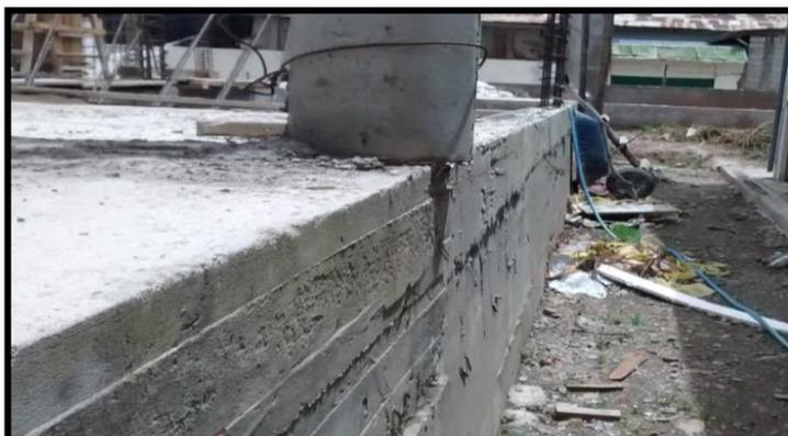
*Fotografía 4. Presencia de cangrejera y falta de recubrimiento.*
