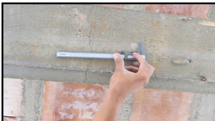
Fotografía 10. Medición de grietas en el techo aligerado de 0.4 mm.
