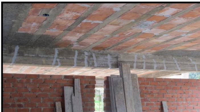
*Fotografía 9. Medición de grietas en vigas peraltadas de 0.04mm.*
