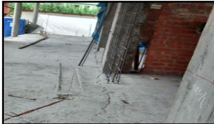
*Fotografía 6. Proceso constructivo columna y placa incorrecto.*
