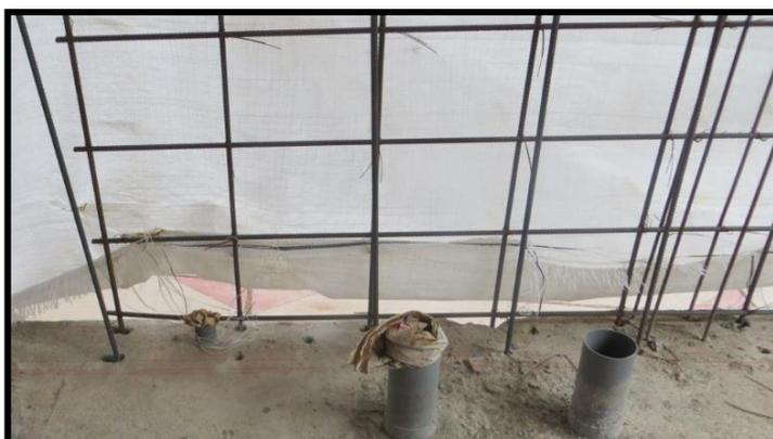
Fotografía 13. Junta mayor a 2 cm en los muros.
