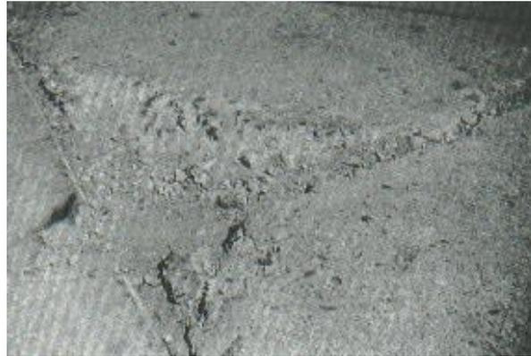
Figura N° 24: Descascaramiento de alta severidad
