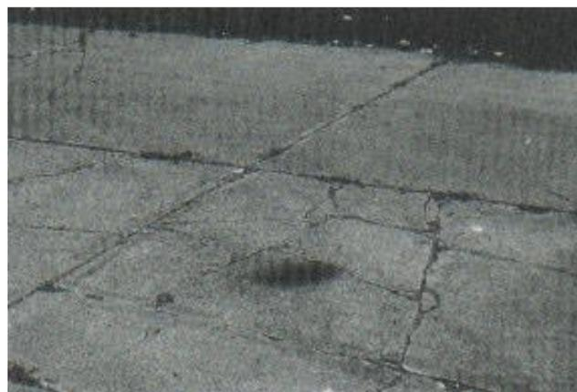
Figura N° 3: Losa dividida de alta severidad
