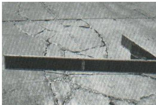
Figura N° 18: Punzonamiento de alta severidad
