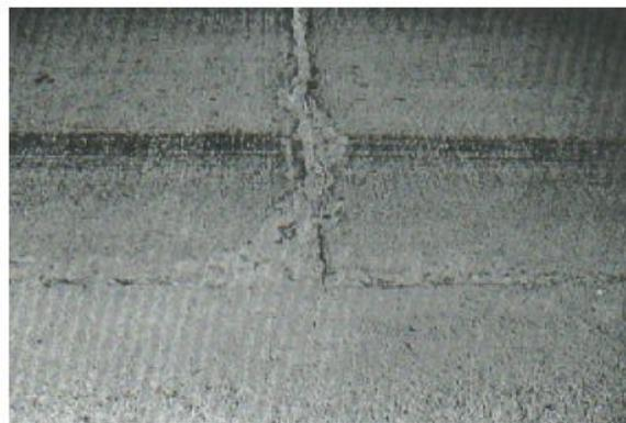
Figura N° 23: Descascaramiento de severidad media
