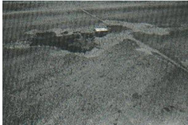
Figura N° 21: Desconchamiento de alta severidad
