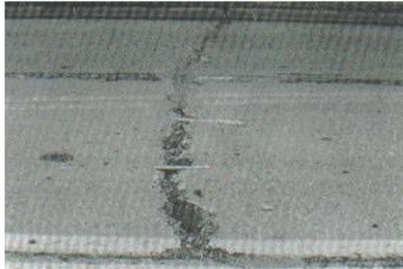
Figura N° 9: Grietas lineales de alta severidad en losa de concreto simple
