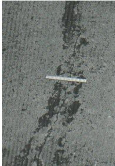
Figura N° 7: Grietas lineales de baja severidad en losa de concreto simple
