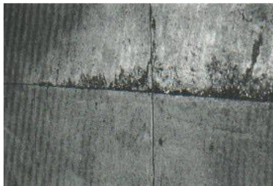
Figura N° 26: Descascaramiento de junta de severidad media
