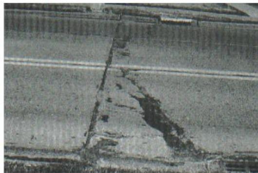
Figura N° 17: Punzonamiento de alta severidad
