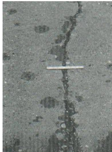
Figura N° 8: Grietas lineales de severidad media en losa de concreto reforzado
