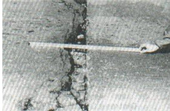
Figura N° 27: Descascaramiento de junta de alta severidad
