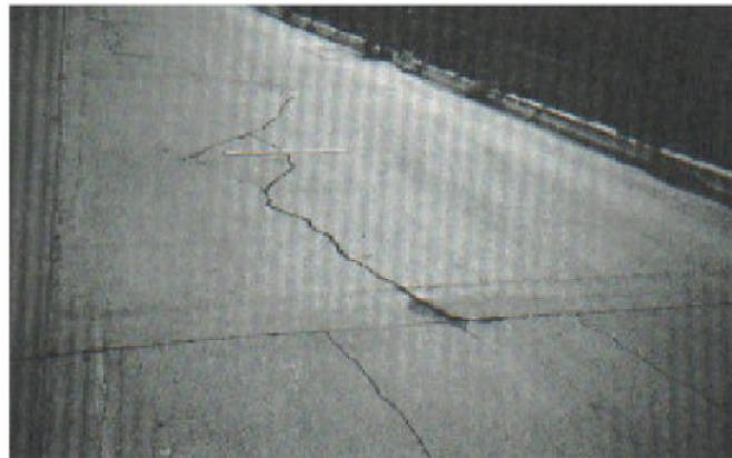
Figura N° 2: Losa dividida de severidad media.
