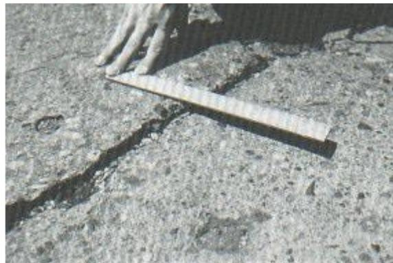
Figura N° 5: Escala de severidad media
