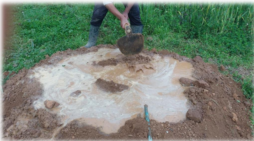
Fotografía N° 04. En la imagen podemos apreciar el inicio del proceso de elaboración del adobe tradicional.
