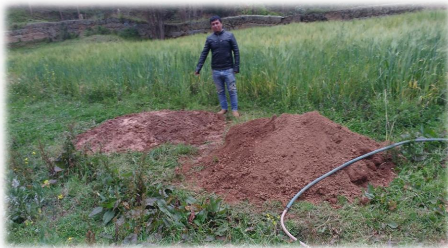
Fotografía N° 05. En la imagen podemos apreciar que ya está listo el barro para la elaboración de los adobes.
