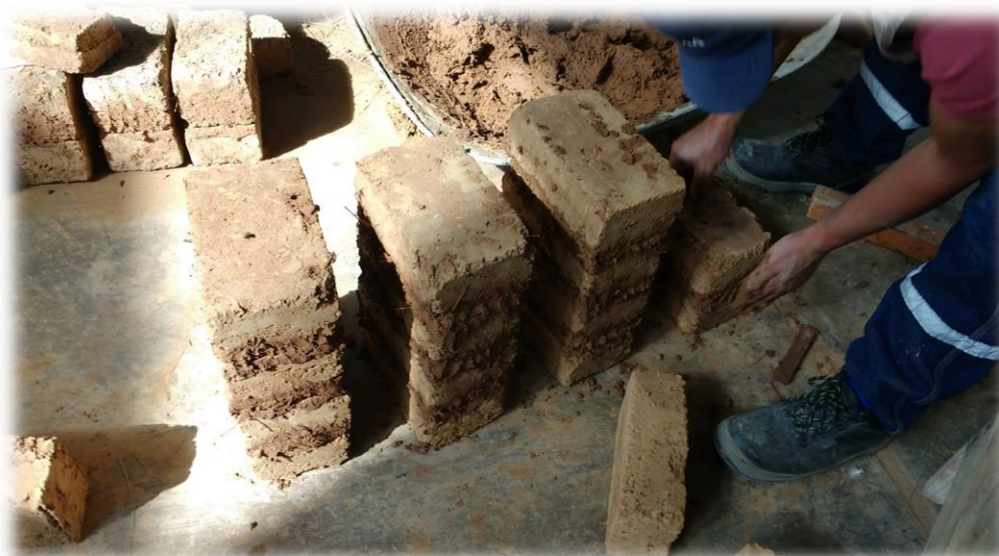
Fotografía N° 16. En la imagen podemos apreciar el asentado de pilas De adobes elaborados con aditivos (Laboratorio de la FIC-UNHEVAL).
