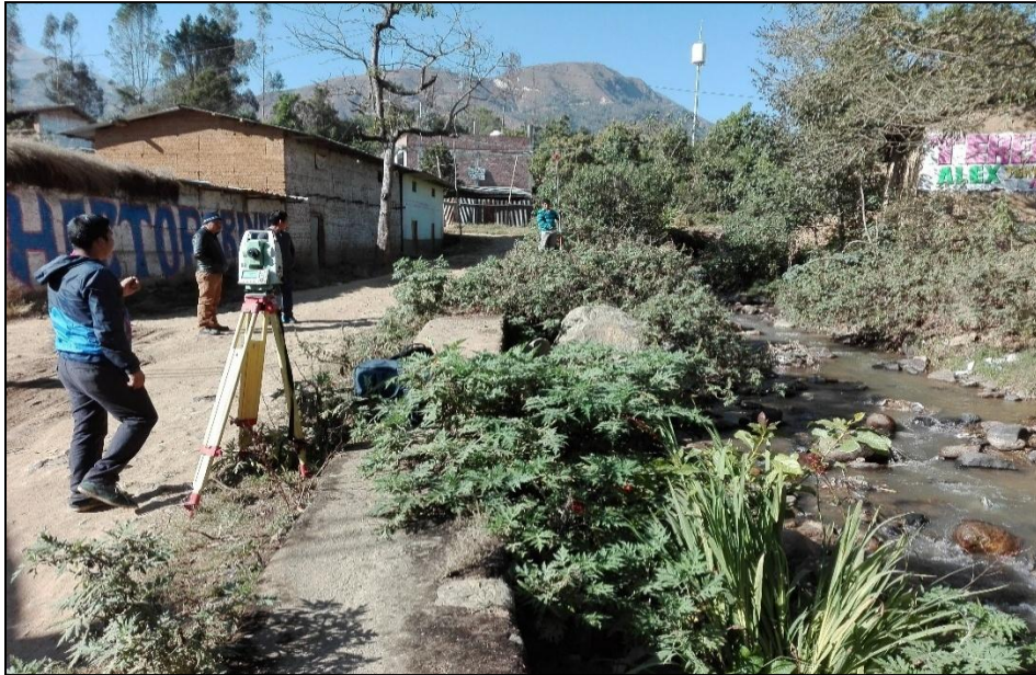
Foto N° 07: Tesista realizando el levantamiento topográfico del río tirishuanca. Prog. Km 0+870
