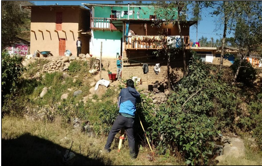
Foto N° 05: Tesista realizando el levantamiento topográfico del rio tirishuanca. Prog. Km 0+040
