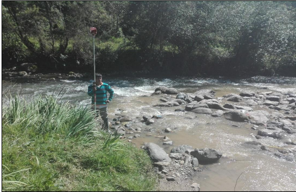
Foto N° 09: Ayudante de Tesista en el levantamiento topográfico del río tirishuanca. Prog. Km 0+980
