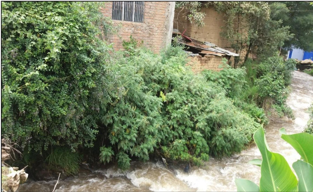
Foto N° 02: Viviendas en peligro de colapso por inundación. prog. Km 0+850
