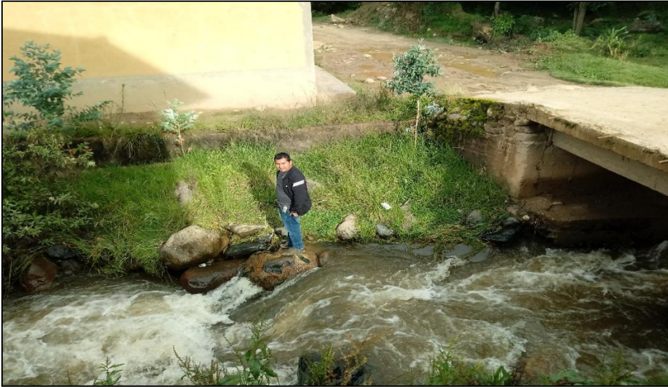
Foto N° 01: Tesista Inspeccionando el Inicio del Tramo en estudio prog. Km 0+000
