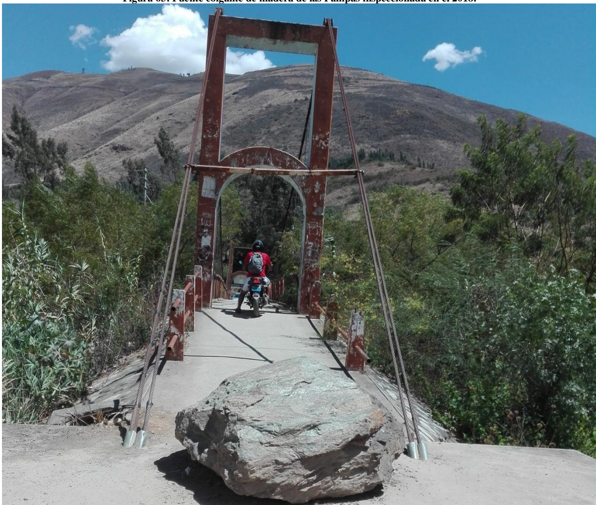
Figura 63: Puente colgante de madera de las Pampas inspeccionada en el 2018.
