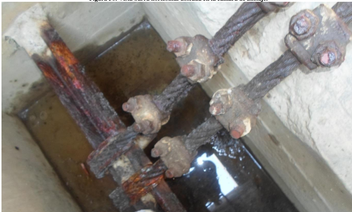
Figura 36: Vista barra horizontal ubicada en la cámara de anclaje.
