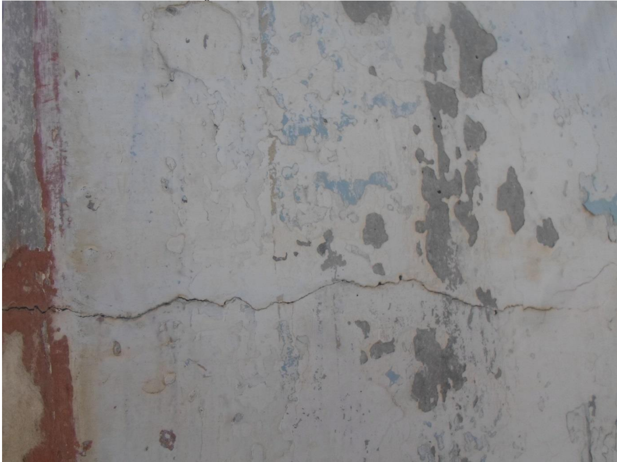
Figura 32: Vista lateral de la columna de la torre.
