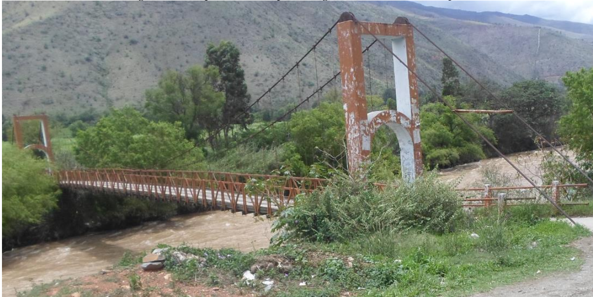
Figura 58: Vista panorámica del puente colgante de madera de las Pampas.
