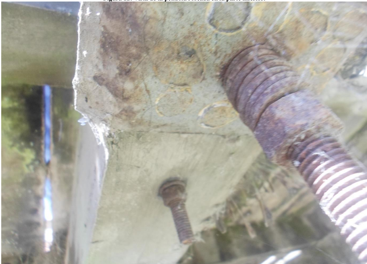
Figura 12: Vista de la péndola roscada en la parte inferior.
