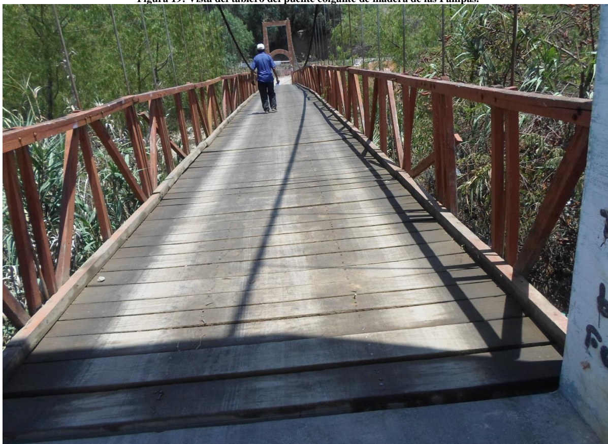
Figura 19: Vista del tablero del puente colgante de madera de las Pampas.
