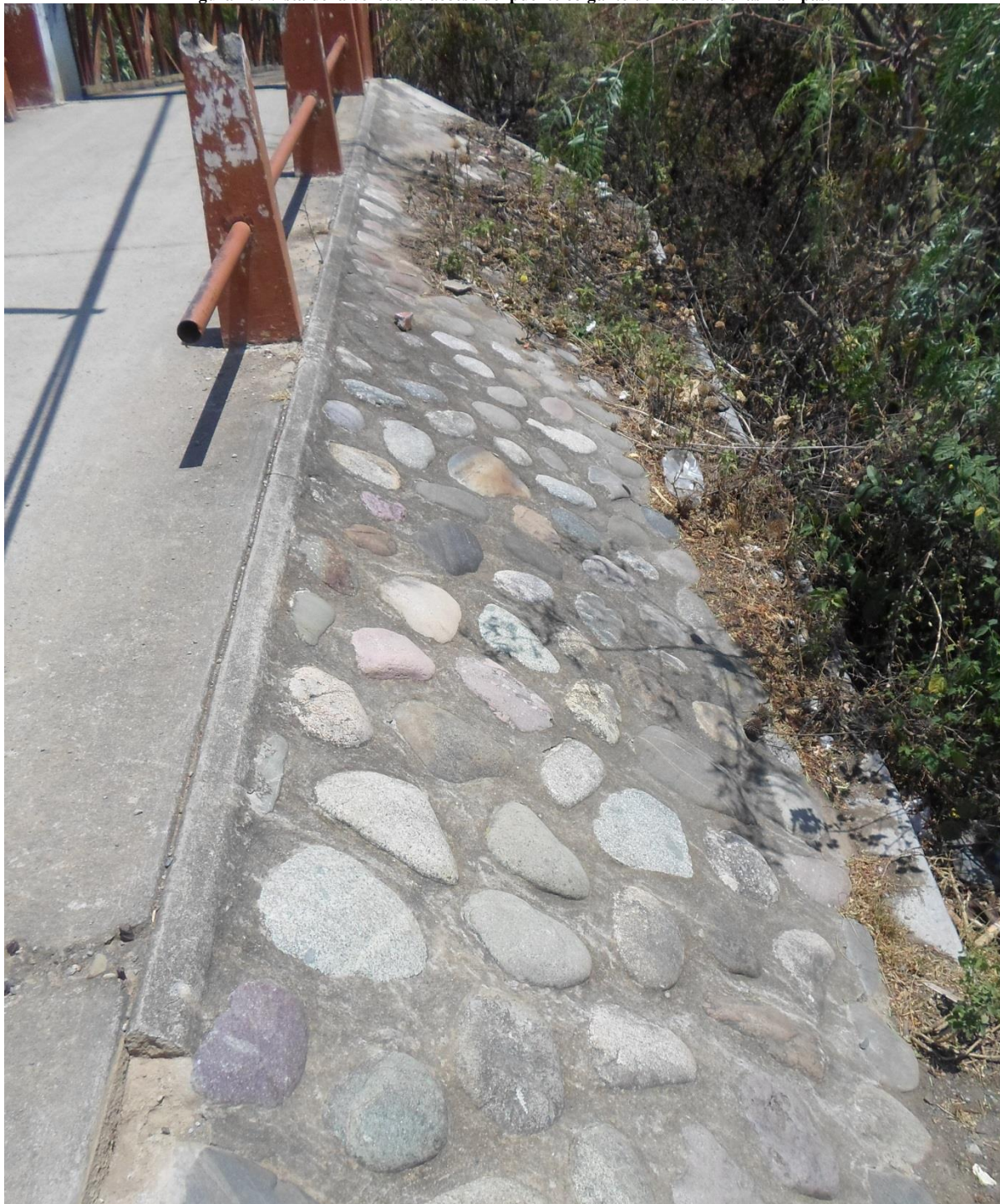
Figura 18: Vista de la vereda de acceso del puente colgante de madera de las Pampas.
