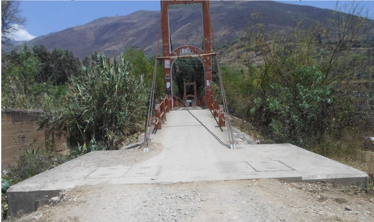
Figura 16: Vista de la cámara de anclaje del puente colgante de madera de las Pampas.
