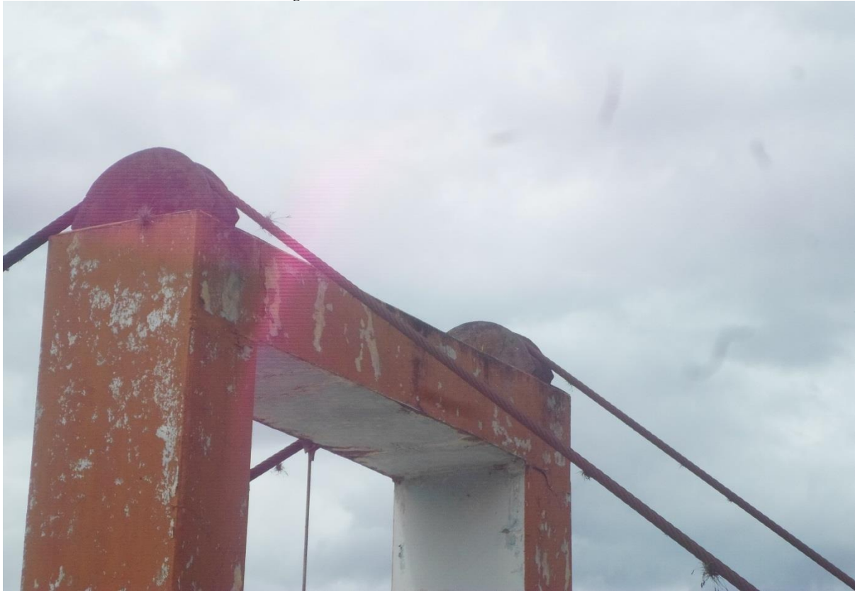
Figura 30: Vista lateral del carro de dilatación
