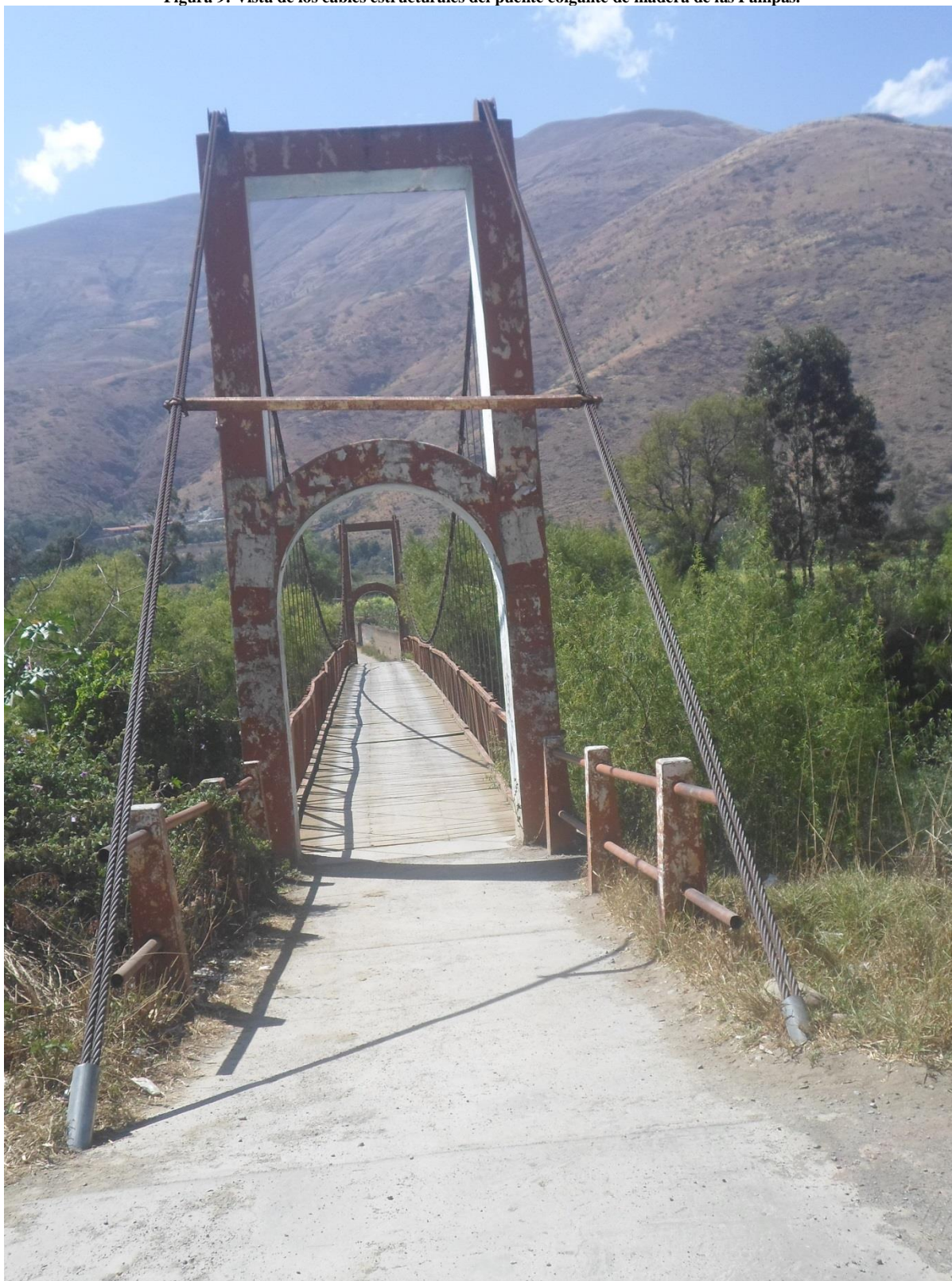
Figura 9: Vista de los cables estructurales del puente colgante de madera de las Pampas.
