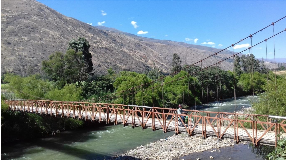
Figura 62: Circulación de motos lineales por el puente colgante de madera de las Pampas.
