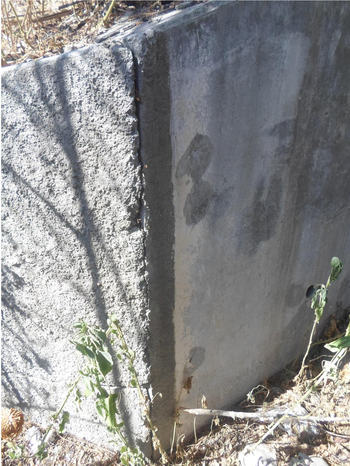
Figura 39: Vista de la vereda de acceso a la torre del puente
