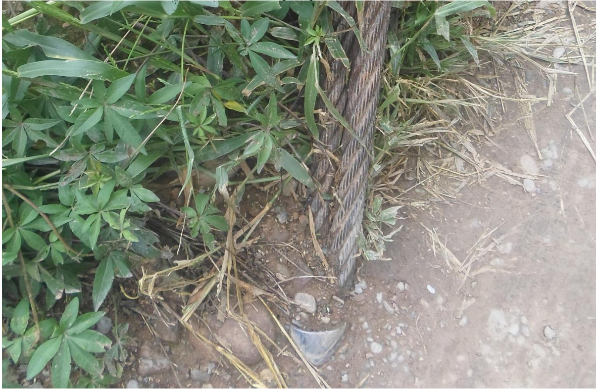
Figura 34: Vista del cable principal en la cámara de anclaje.
