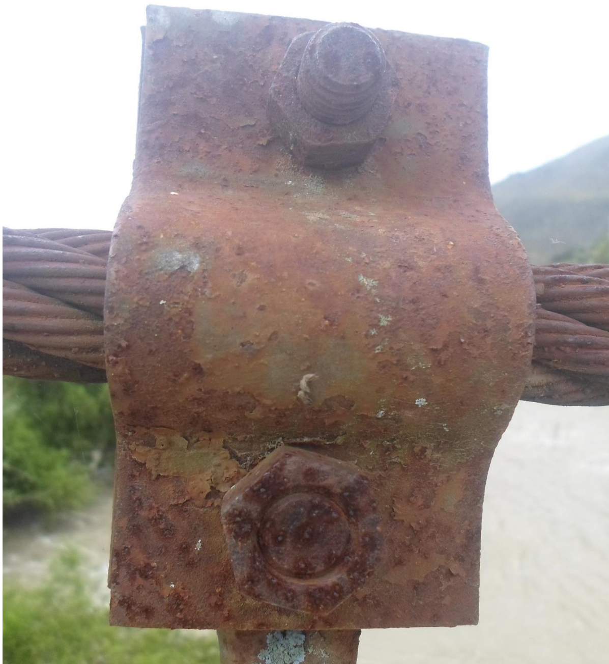
Figura 28: Vista de la abrazadera y los tornillos oxidados
