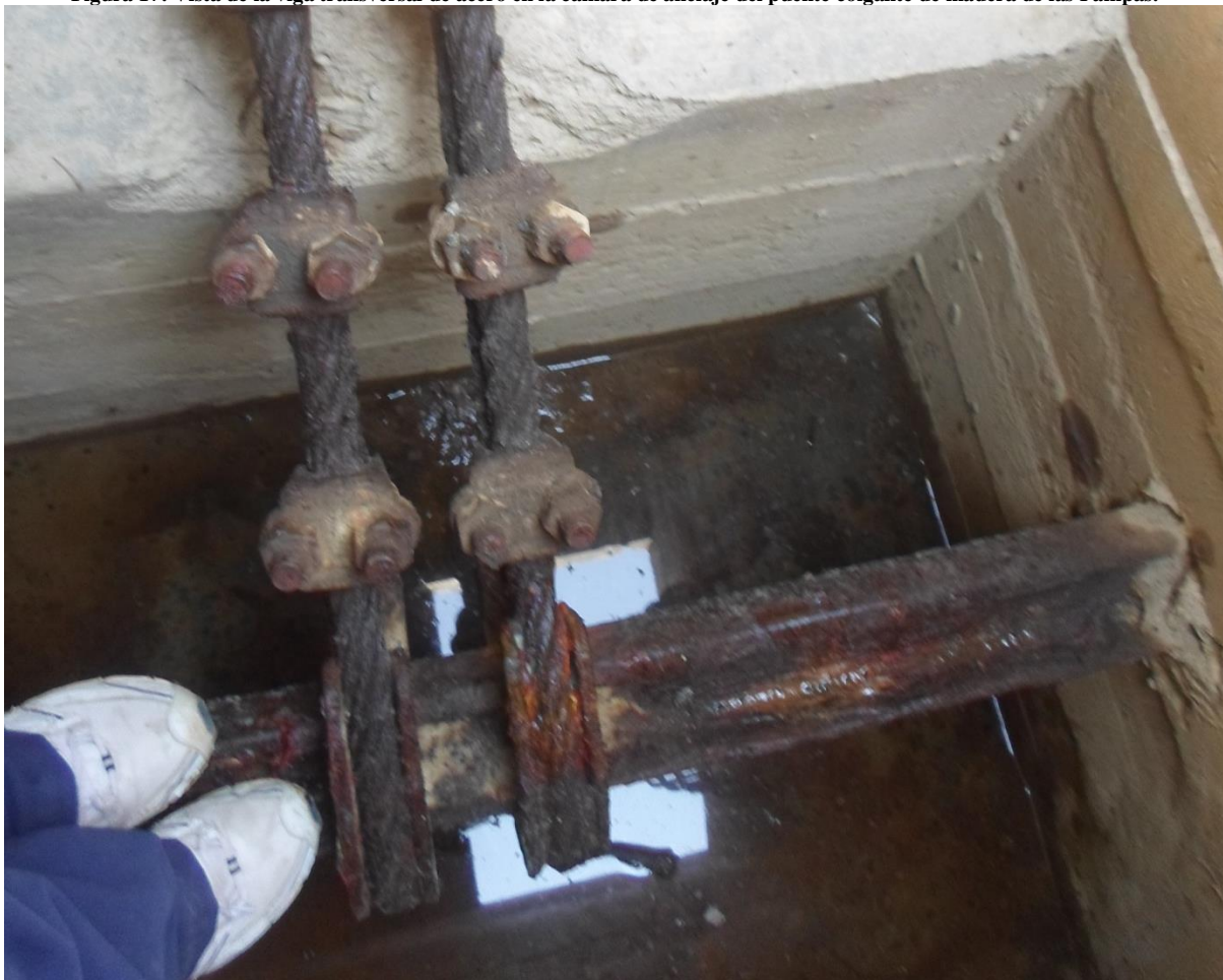
Figura 17: Vista de la viga transversal de acero en la cámara de anclaje del puente colgante de madera de las Pampas.
