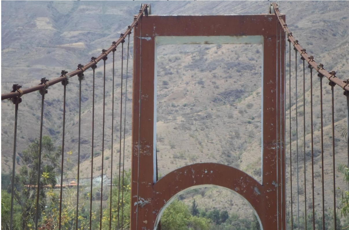
Figura 11: Vista de las péndolas del puente colgante de madera de las Pampas.
