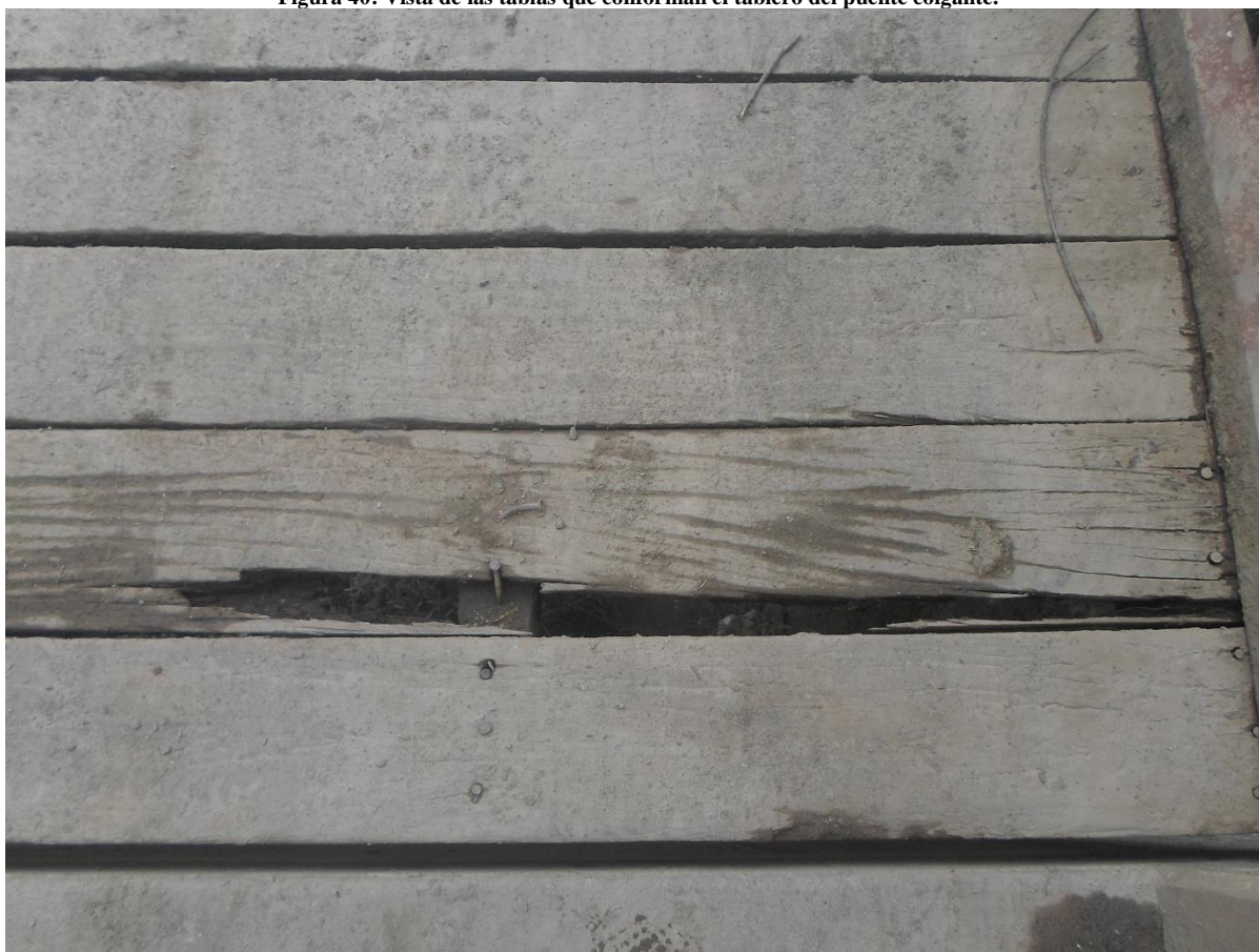
Figura 40: Vista de las tablas que conforman el tablero del puente colgante.
