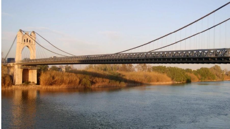
Figura 3: Vista panorámica del puente colgante de Amposta rehabilitado.
