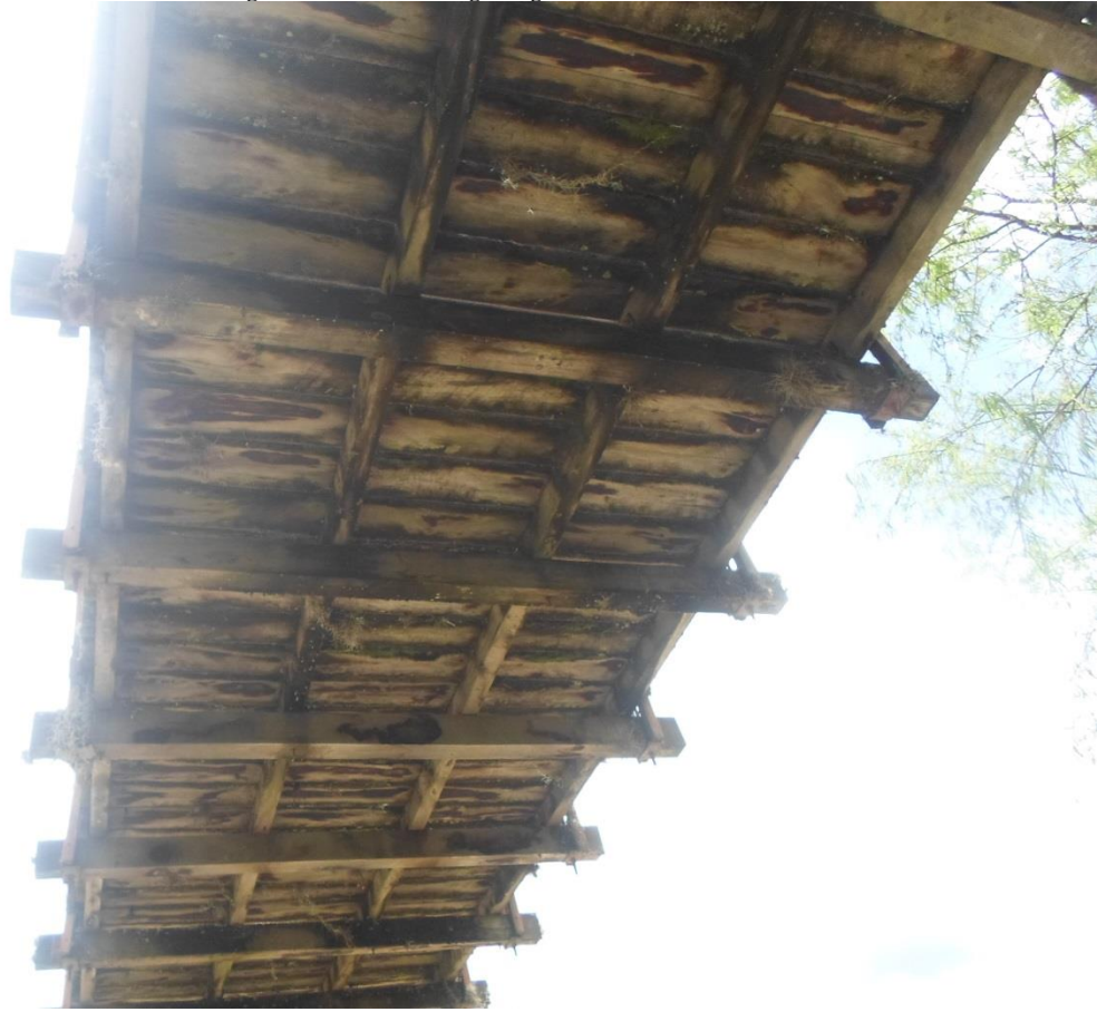
Figura 43: Vista de la viga longitudinal.
