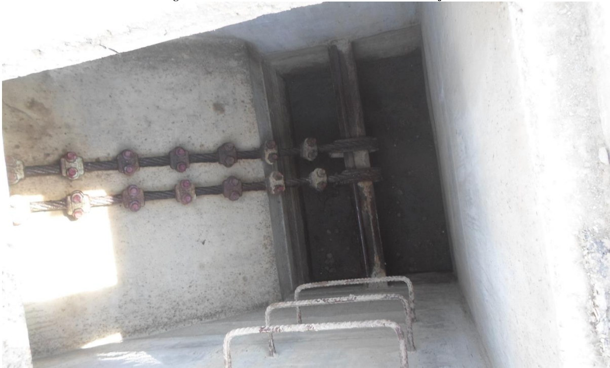
Figura 35: Vista del cable estructural en la cámara de anclaje.
