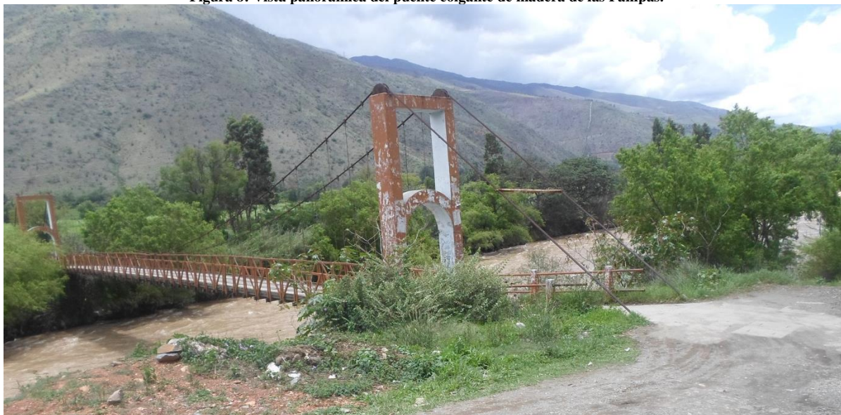
Figura 8: Vista panorámica del puente colgante de madera de las Pampas.
