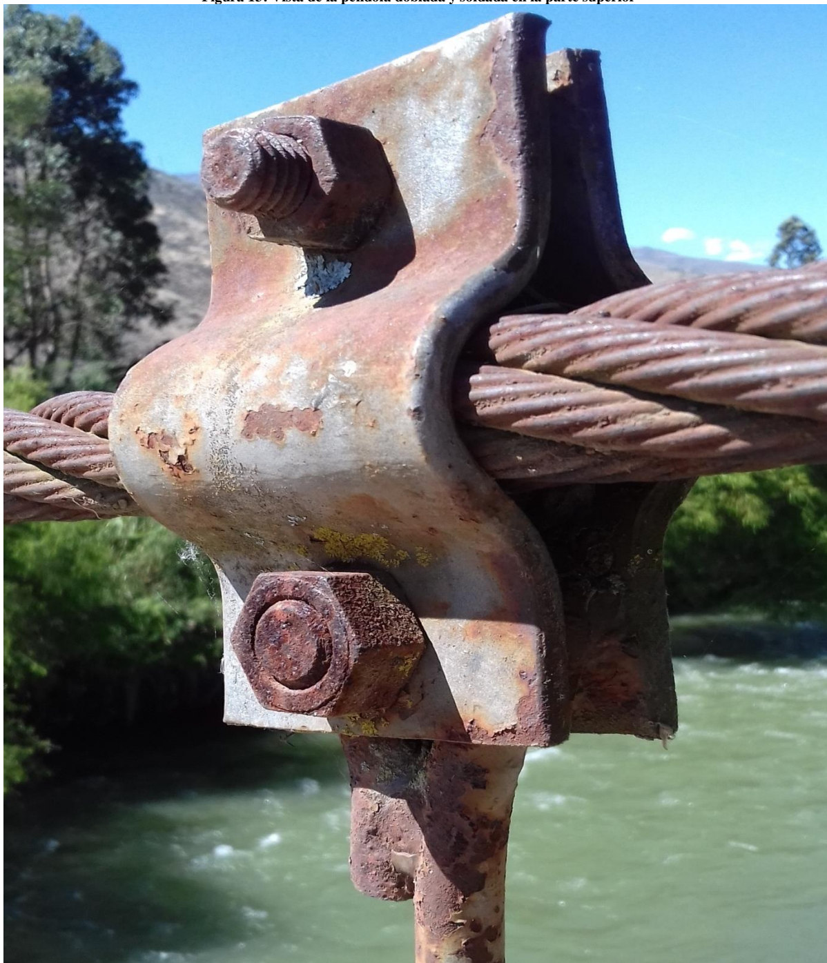
Figura 13: Vista de la péndola doblada y soldada en la parte superior
