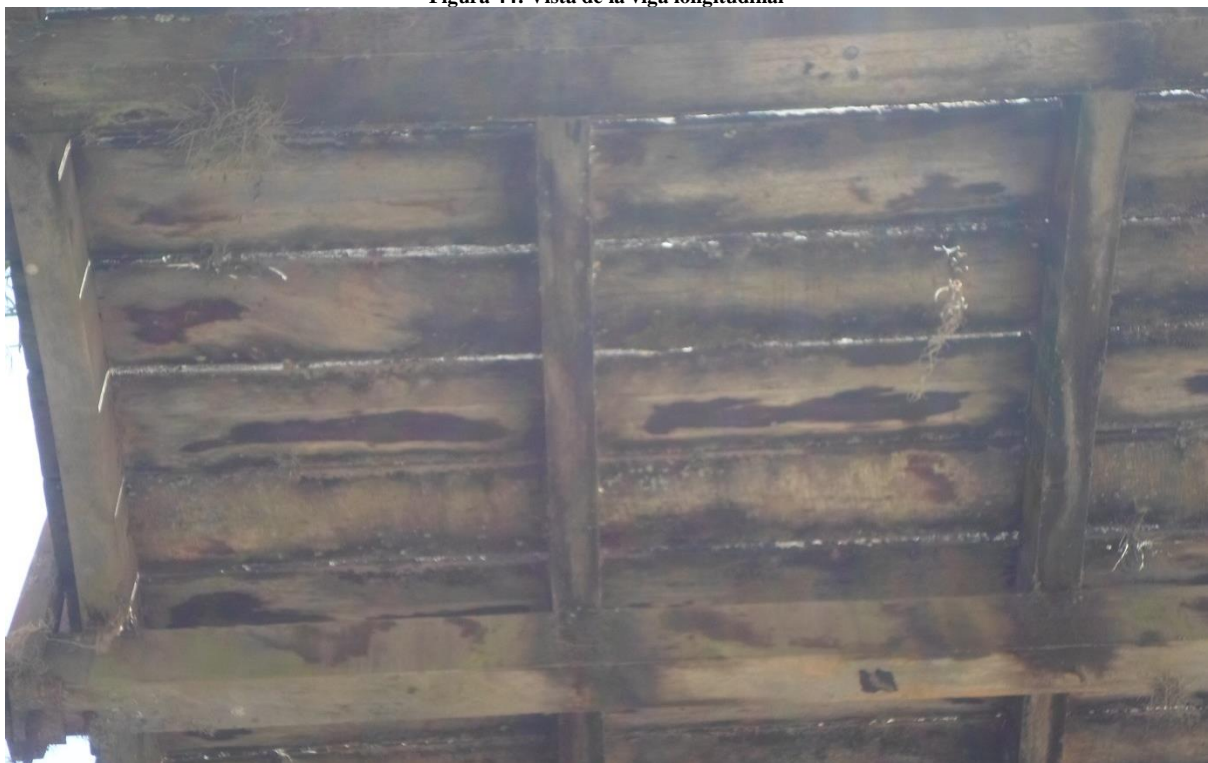
Figura 44: Vista de la viga longitudinal
