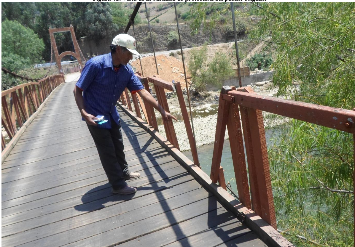
Figura 41: Vista de la baranda de protección del puente colgante
