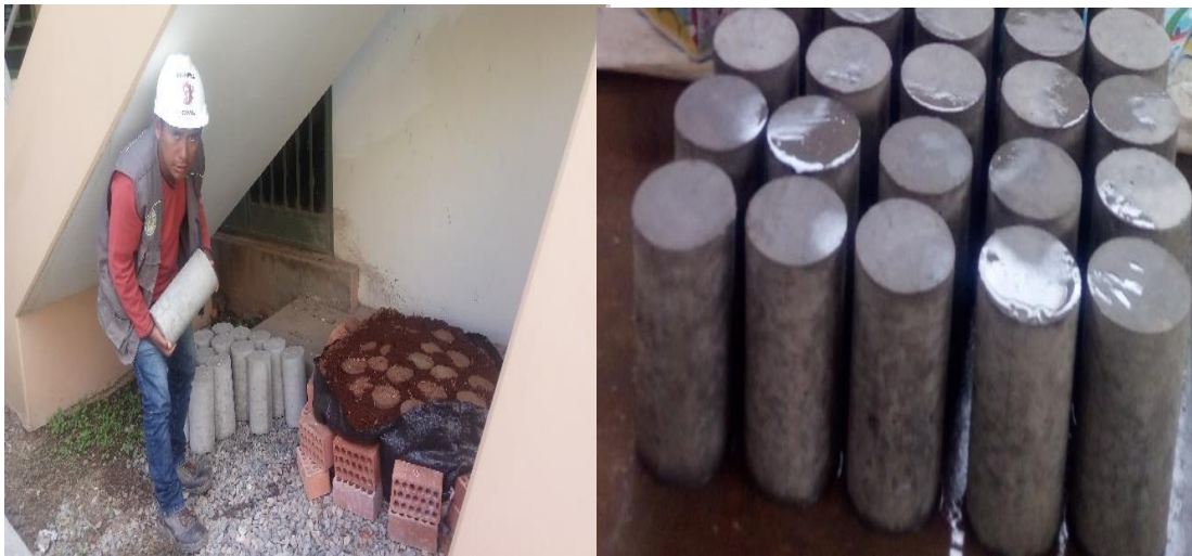
Fotografía N° 13. Curado por aspersión de probetas de concreto hidráulico.
