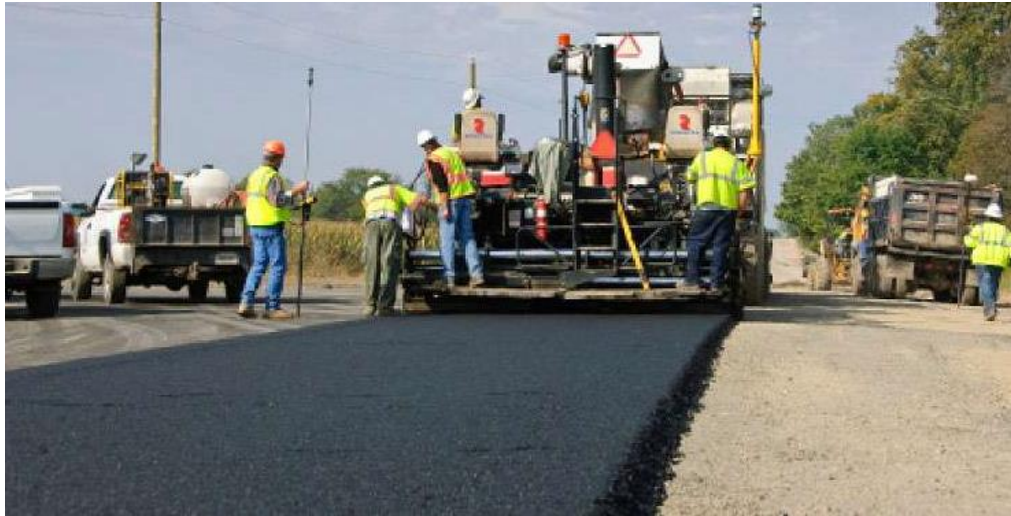
Figura 26. Extensión de la mezcla asfáltica.
