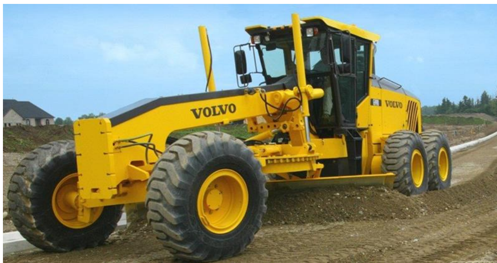
Figura 34. Distribución del material de sub base.
