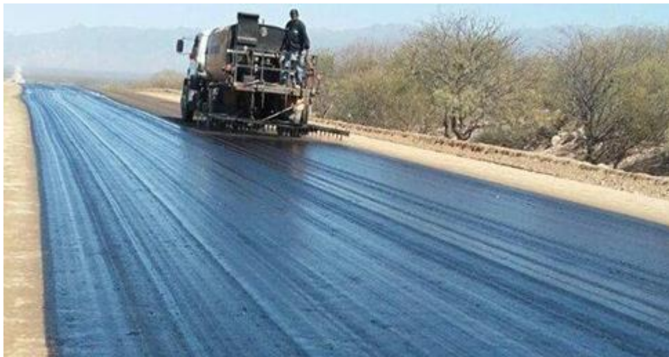
Figura 24. Imprimación asfáltica.
