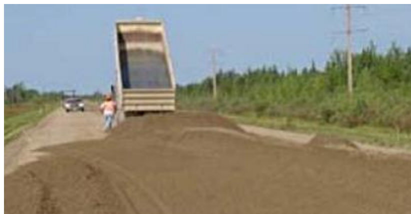
Figura 22. Transporte y colocación del material de base.
