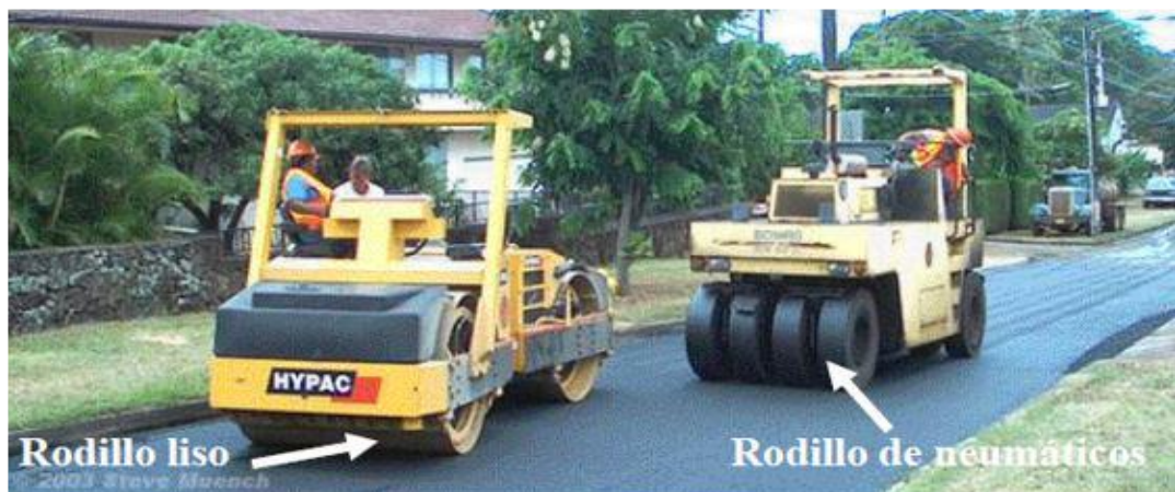
Figura 27. Compactación de la mezcla.
