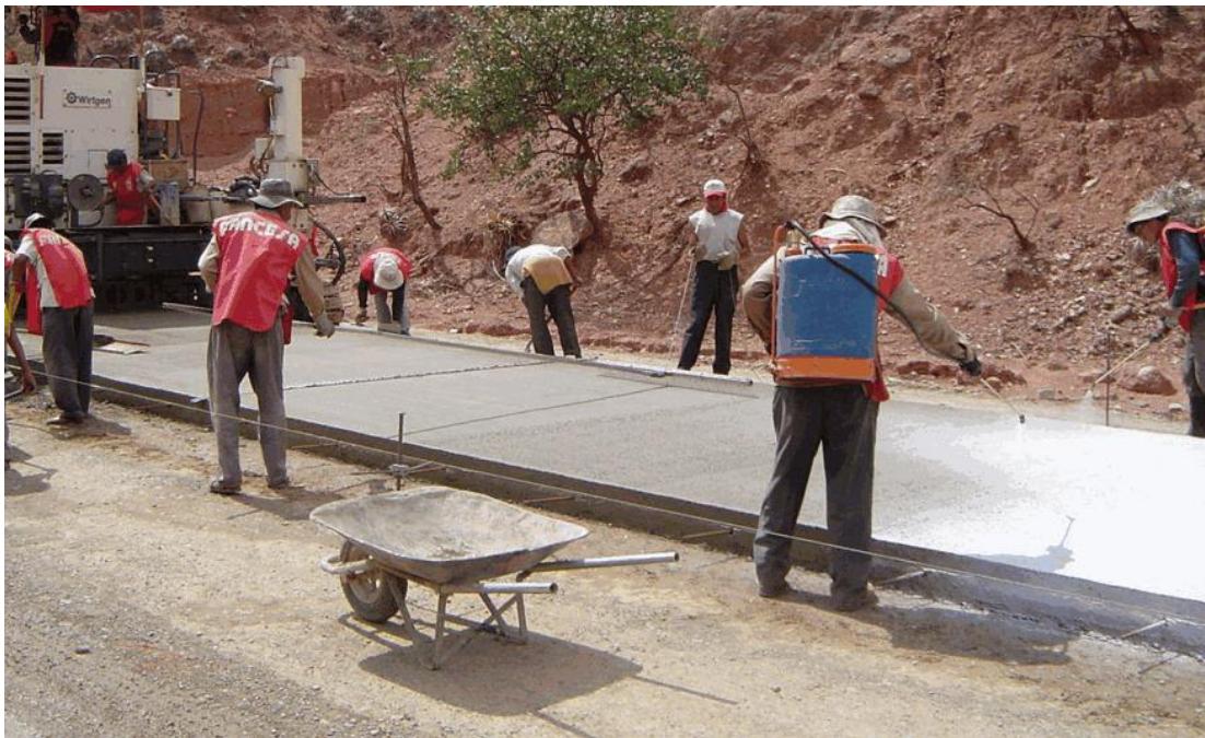
Figura 38. Texturizado y curado del concreto.
