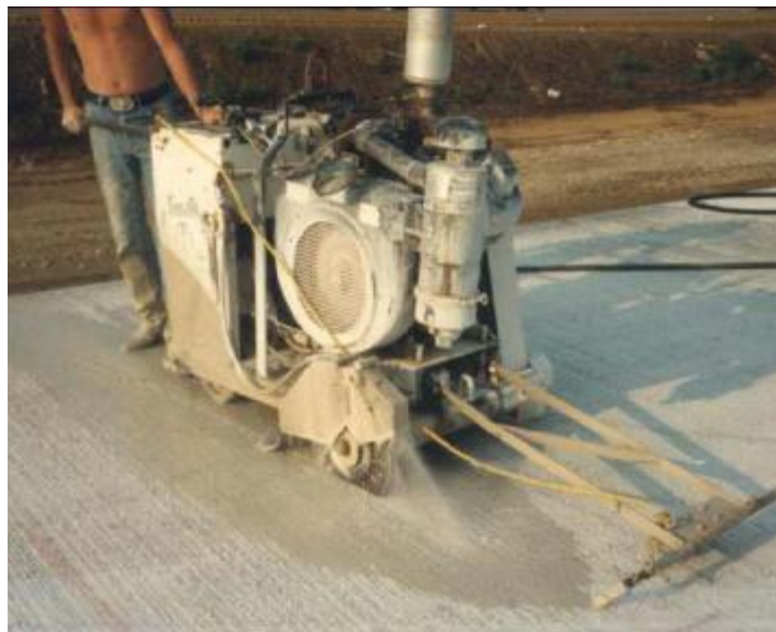
Figura 39. Aserrado de juntas de contracción.
