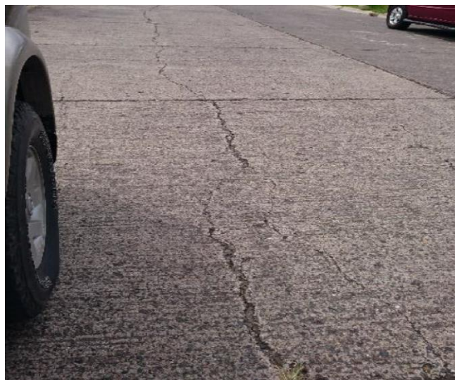
Figura 10. Agrietamiento longitudinal.
