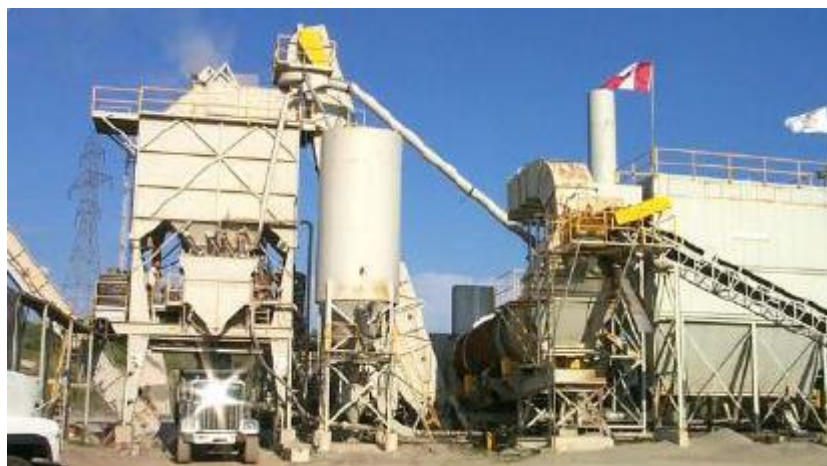
Figura 25. Elaboración de la mezcla asfáltica.
