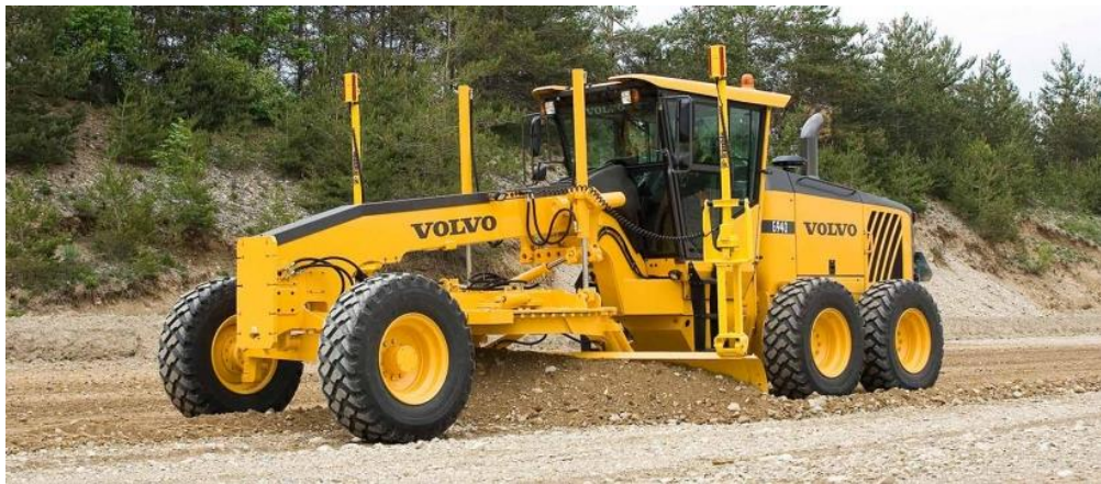
Figura 23. Distribución y mezclado del material de base.
