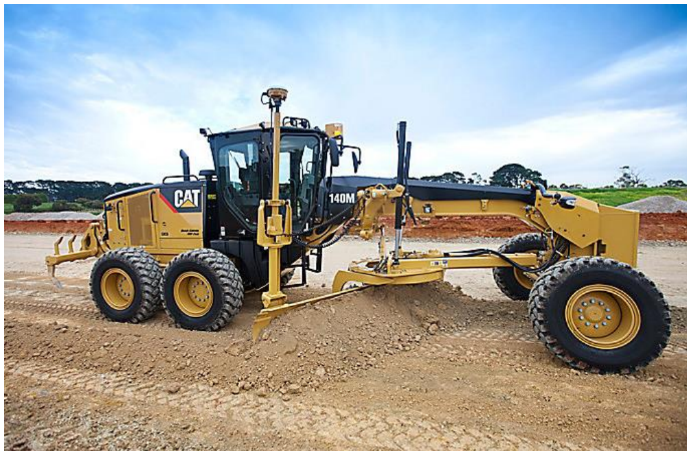
Figura 20. Distribución del material de sub base.
