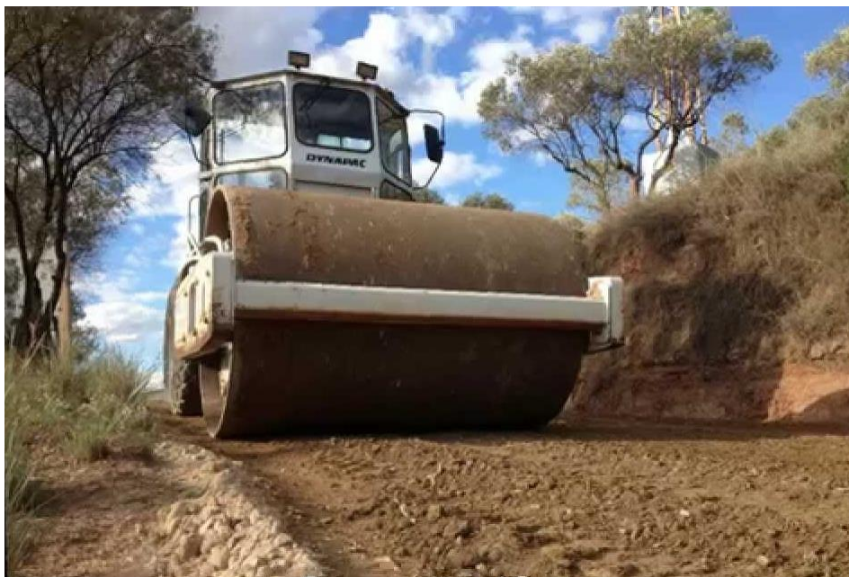
Figura 21. Compactación de la sub base.
