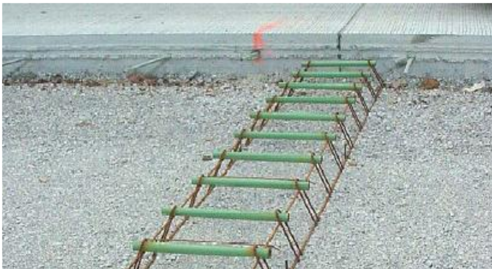
Figura 35. Barras pasa juntas con canastillas.
