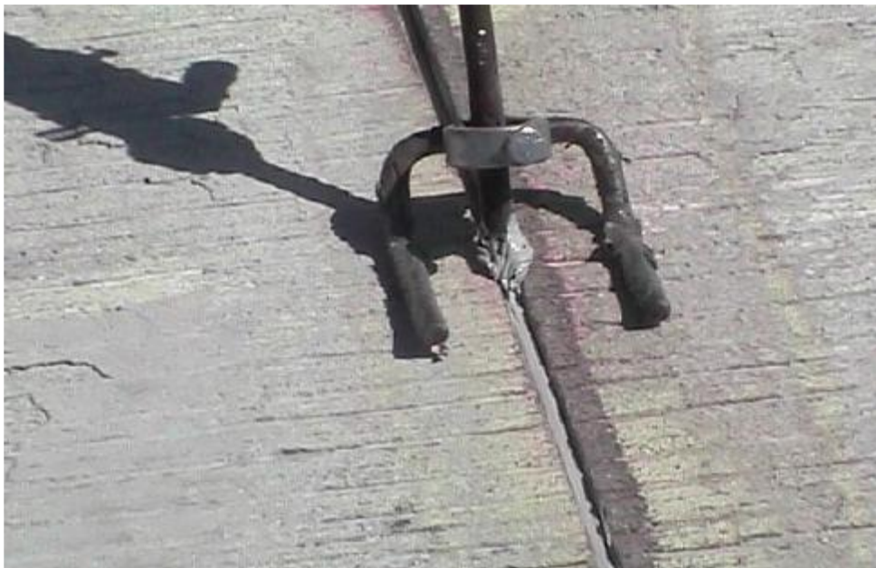
Figura 40. Sellado de juntas longitudinales.
