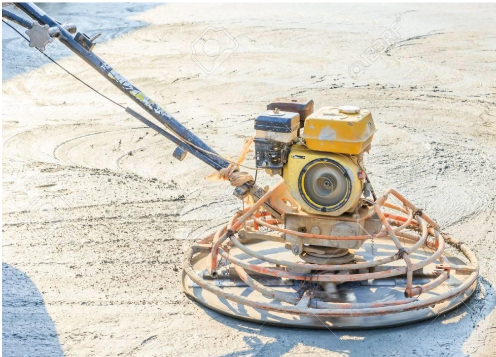
Figura 37. Alisado y acabado de superficie.
