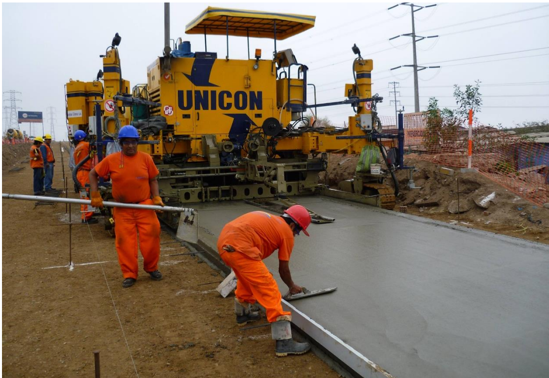
Figura 36. Colocación del concreto hidráulico con pavimentadora.
