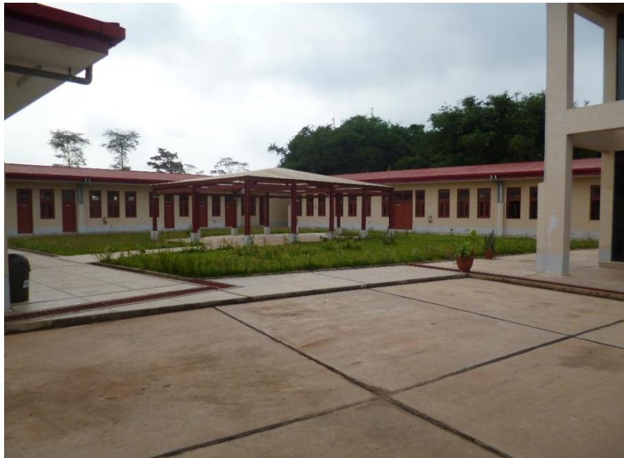
Imagen 20 Infraestructura S.O.A Pucallpa
