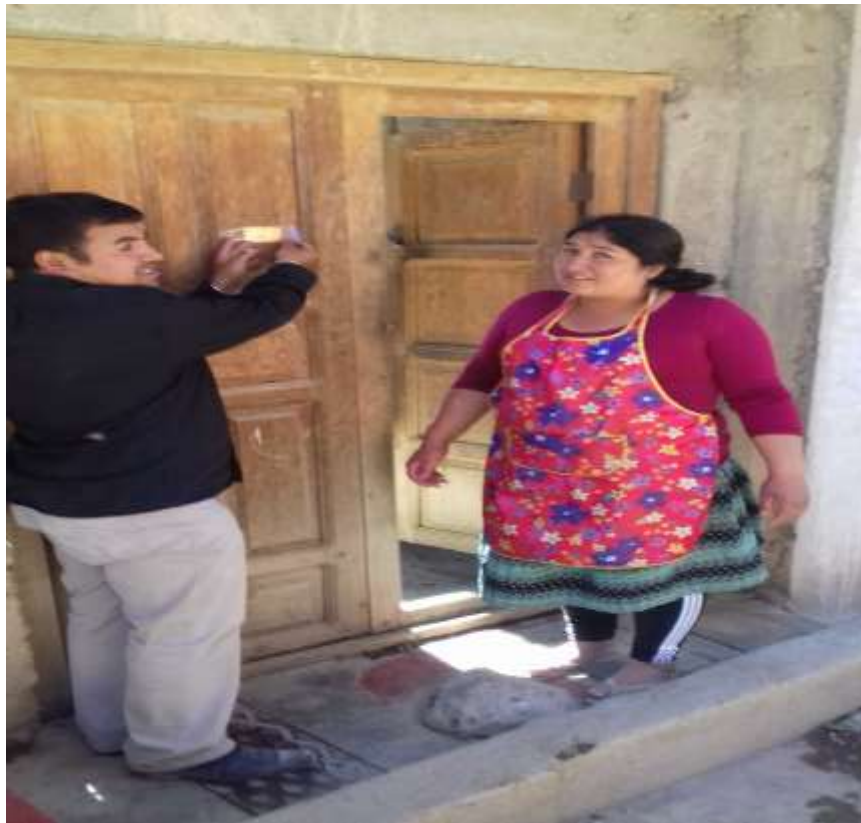
Figura 02. Colocado de estiquer en las viviendas
