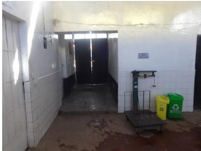
Figura 13: Área de ingreso al camal
