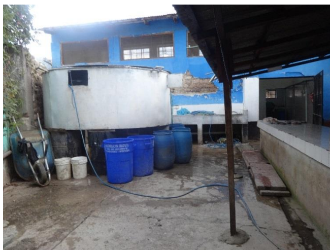
Figura 11: tanque de agua
