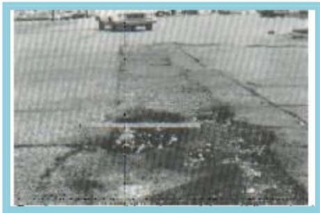
Figura 13: Parcheo y acometidas de servicios públicos.
