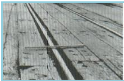
Figura 16: Cruce de vía férrea.
