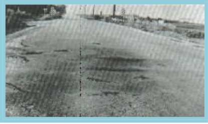
Figura 18: Desplazamiento.
