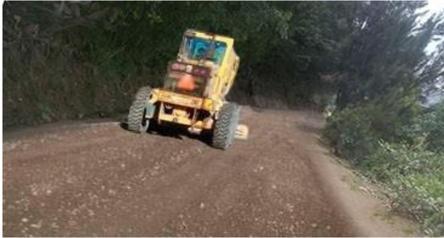
Gráfico 25: Aplicación del Estabilizante de suelo Poly-Ses
