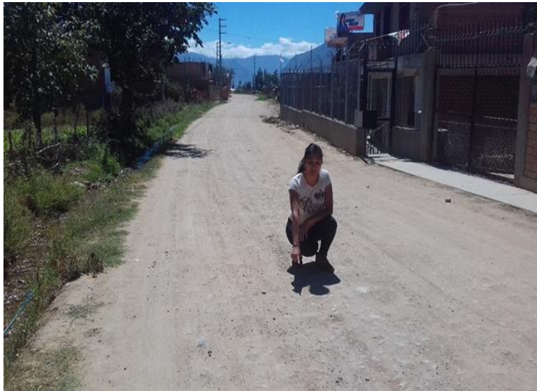
Figura 3.5.- Sector C de la carretera Huánuco – Marabamba.
