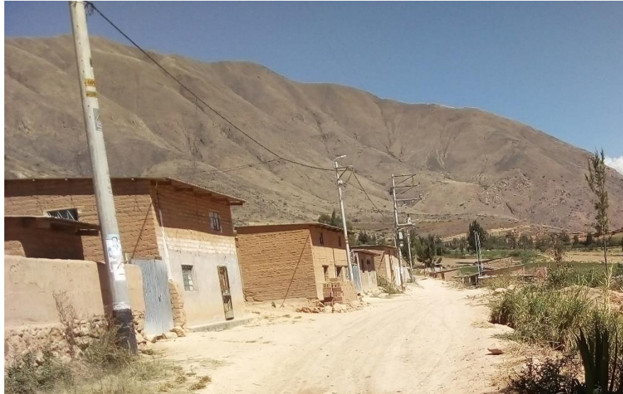
Gráfico 37: Acabado final después de la aplicación del estabilizante de suelo
