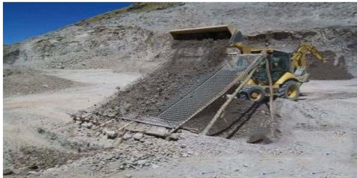
Figura 4.5.- Colocación de zaranda en cantera.
