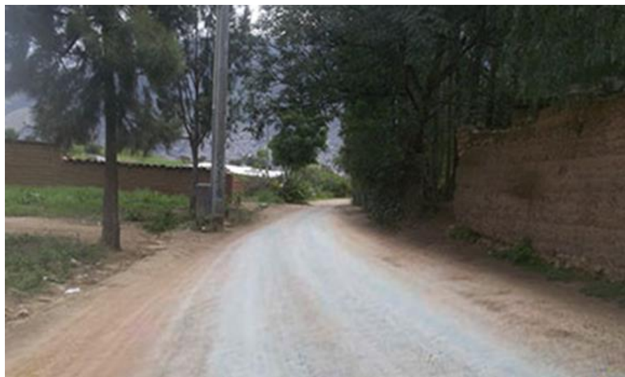
Gráfico 27: Acabado final después de la aplicación del estabilizante de suelo
