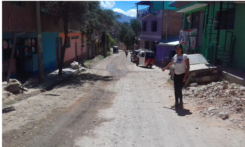
Gráfico 7: Deterioro en el Sector A
