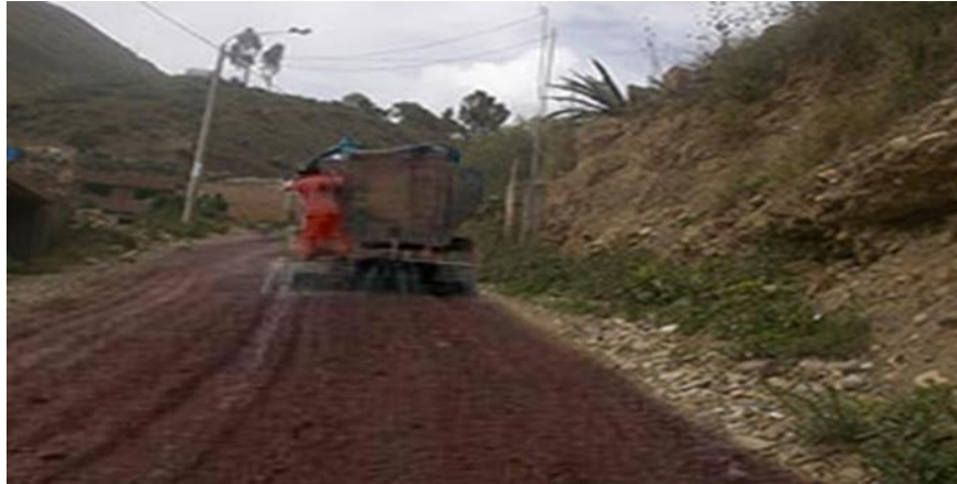
Gráfico 34: Aplicación de estabilizante de suelo Poly – Ses
