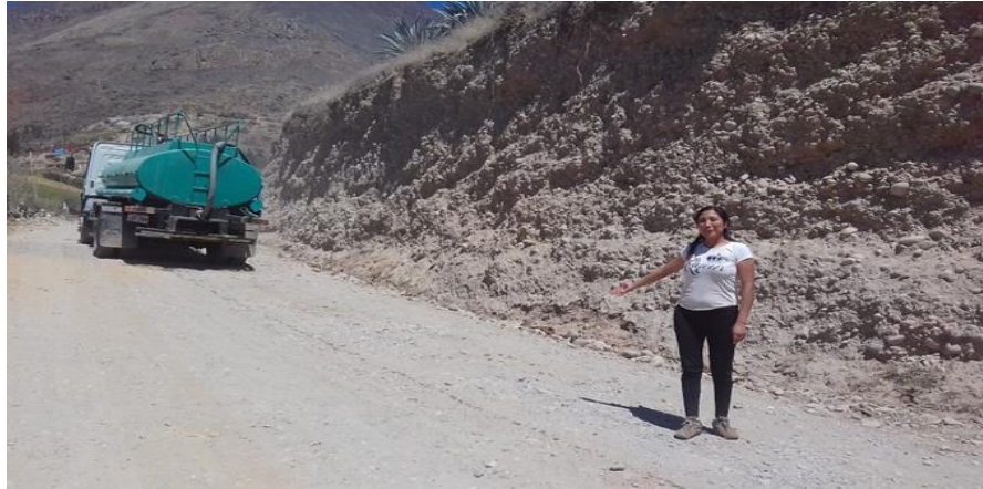
Gráfico 31: Colocación de la cisterna para humedecer el sector
