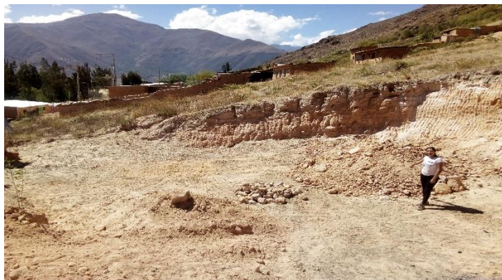
Figura 4.6.- Acondicionamiento de zonas para material procesado
