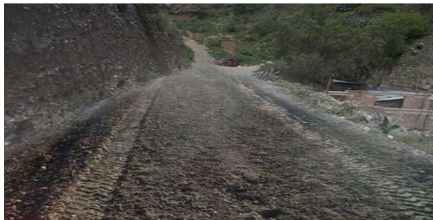
Gráfico 33: Tendido del materia antes de aplicar el estabilizante de suelo (Poly-Ses)
