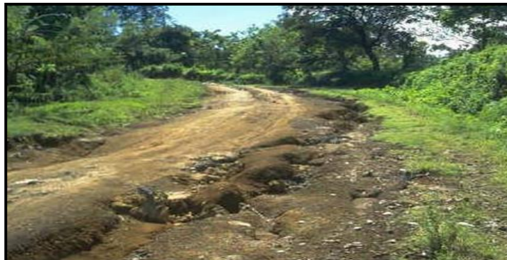
Figura 2.2.- Drenaje inadecuado
