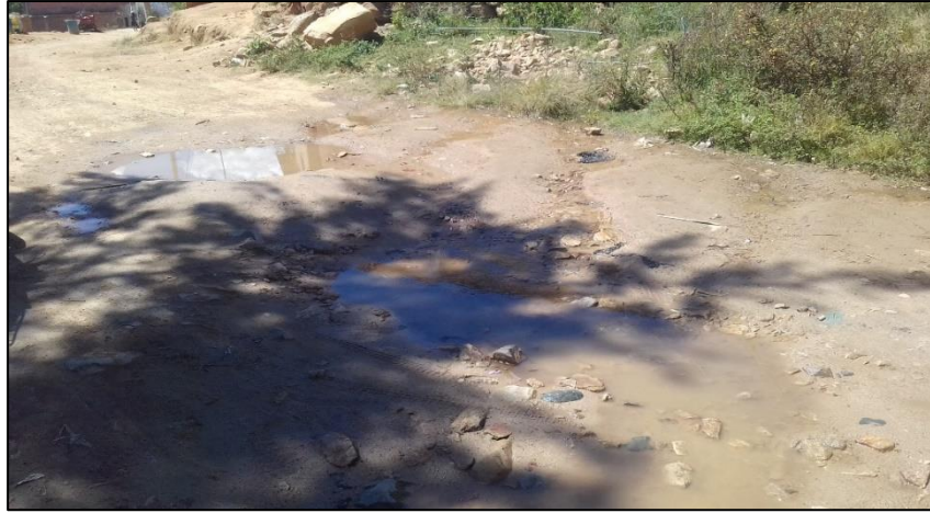
Gráfico 10: Deterioro Superficial de la carpeta de rodadura
