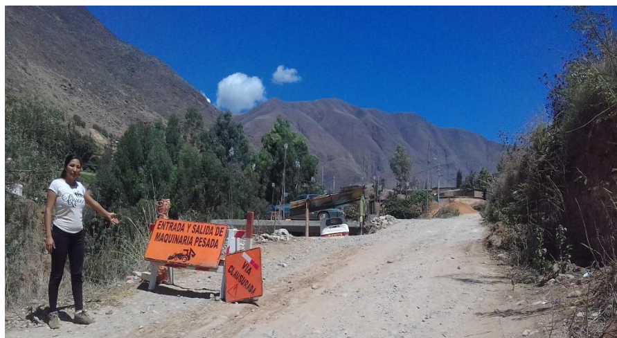
Gráfico 18: Clausura de la vía para la aplicación de los estabilizantes
