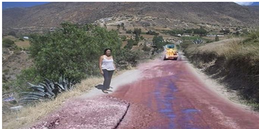
Gráfico 32: Primero se humedeció el sector y se continuó con el tendido del material acopiado de la cantera
