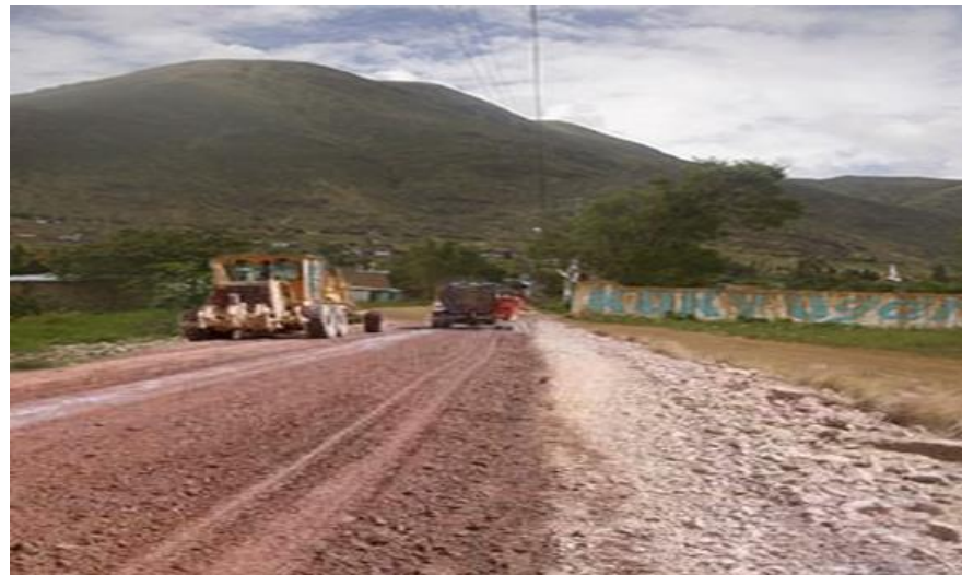
Gráfico 35: Mezclado y Homogenizado del materia con el estabilizante de suelo (Poly-Ses)
