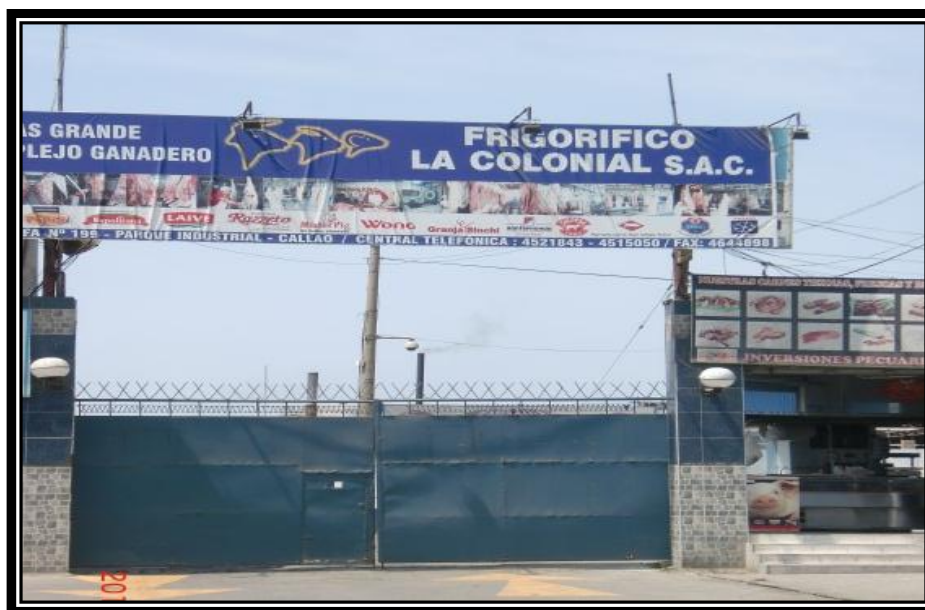
Foto 01. Camal frigorífico "La colonial" donde se segregan los sub productos del beneficio de los animales domésticos, para la preparación de la Harina de Sub Producto de Camal.
