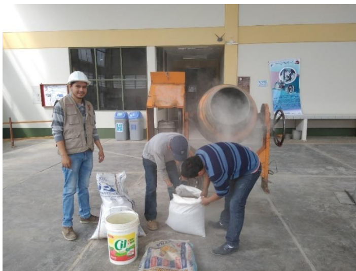
Figura 26: Vaciado de Materiales a la Mezcladora de Concreto
