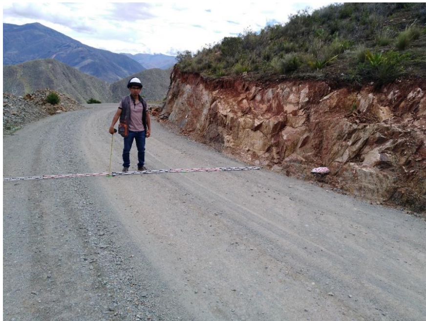
Fotografía 11. Medición del ahuellamiento - Sector II
