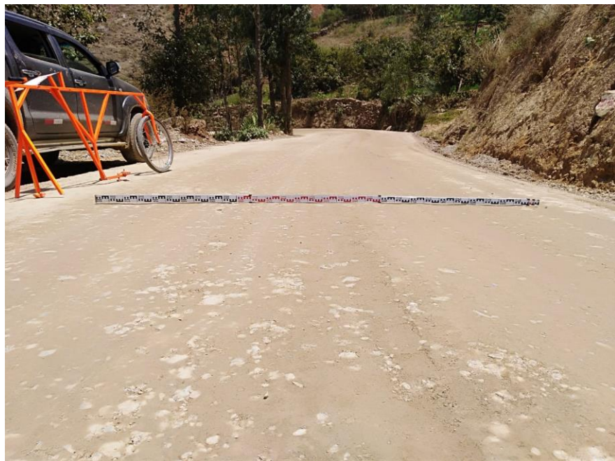
Fotografía 14. Verificación de sección transversal - Sector II
