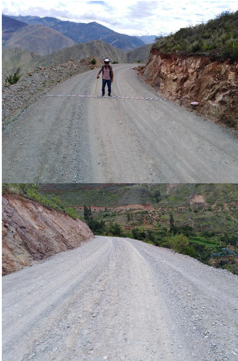
Fotografía 4.10. Pérdida de agregado
