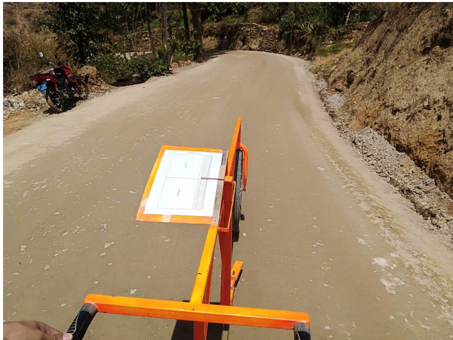
Fotografía 3. Trabajo de medición km 5+460 - sector II.
