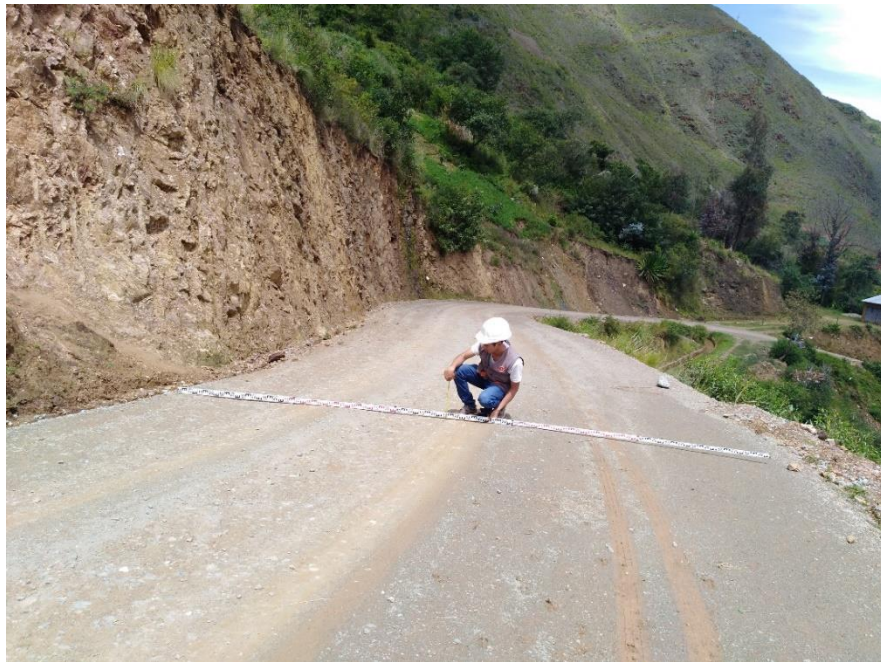
Fotografía 15. Verificación de sección transversal - Sector III
