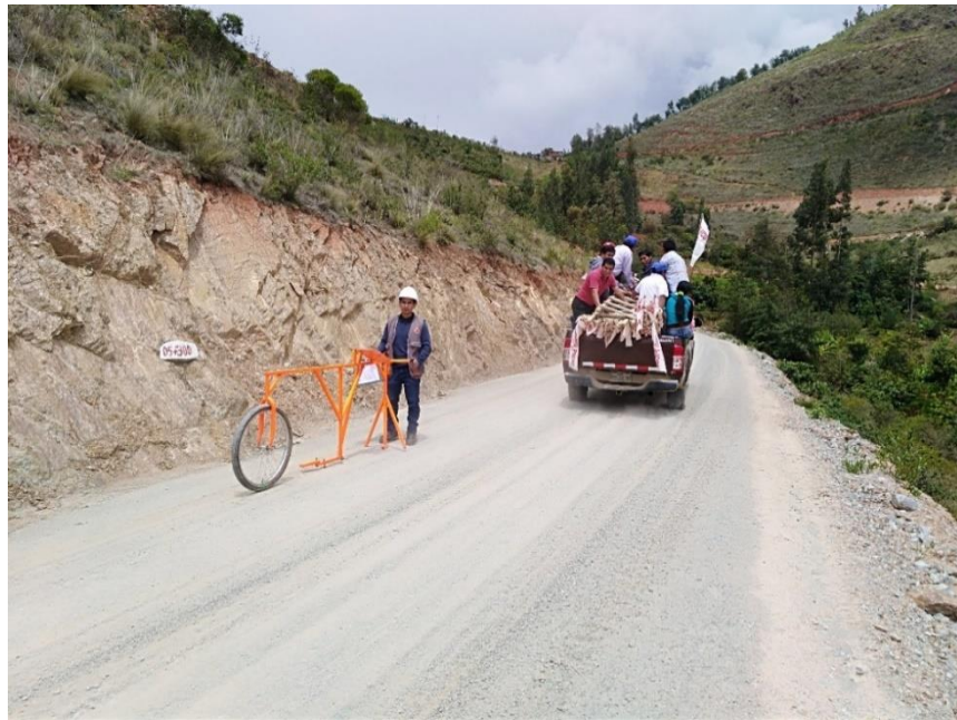
Fotografía 7. Trabajo de medición km 5+300 – sector II
