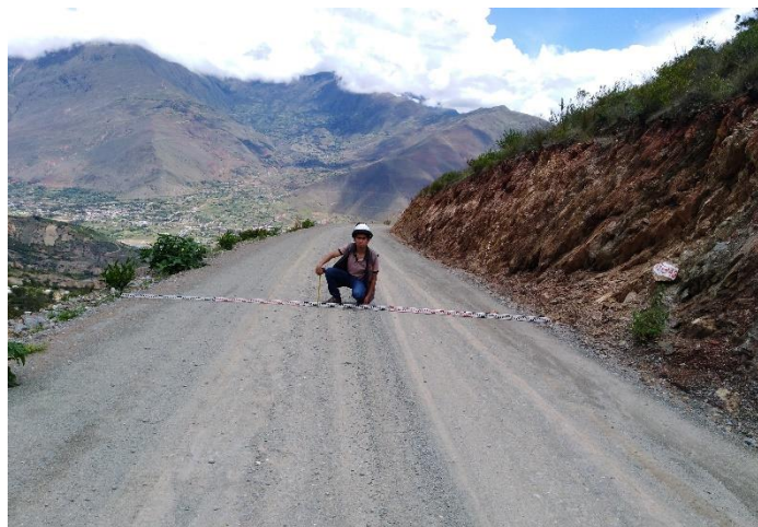
Fotografía 4.9. Libre de ahuellamiento
