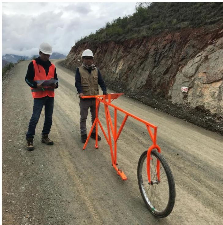
Fotografía 4. Trabajo de medición km 5+080 – sector II
