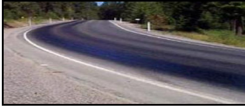
Figura N° 24. Mancha de pavimento nivel H
