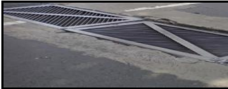
Figura N° 56. Cruce de sumidero de rejilla nivel H
