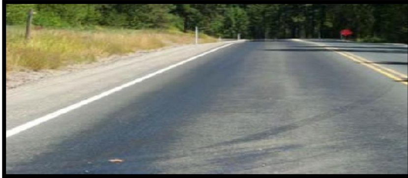
Figura N° 22. Mancha de pavimento nivel L.
