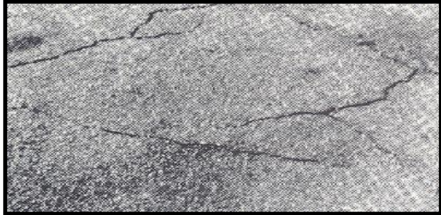
Figura N° 25. Grieta de contracción nivel L
