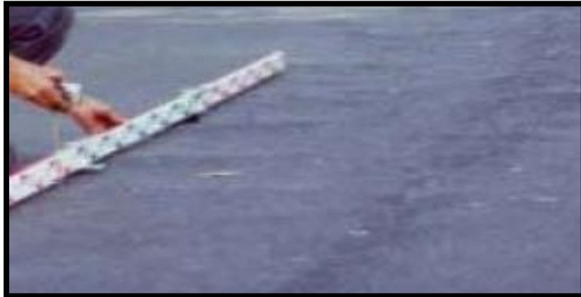
Figura N° 32. Corrugación nivel M
