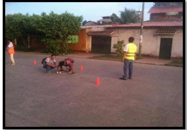
Foto N°20: Ensayo mancha de Arena.
