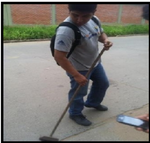
Foto N° 23: Limpieza de la vía
