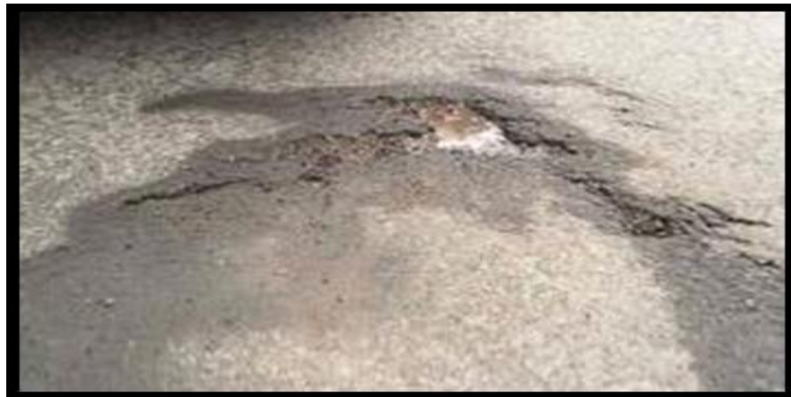
Figura N° 65. Grietas por desplazamiento nivel H
