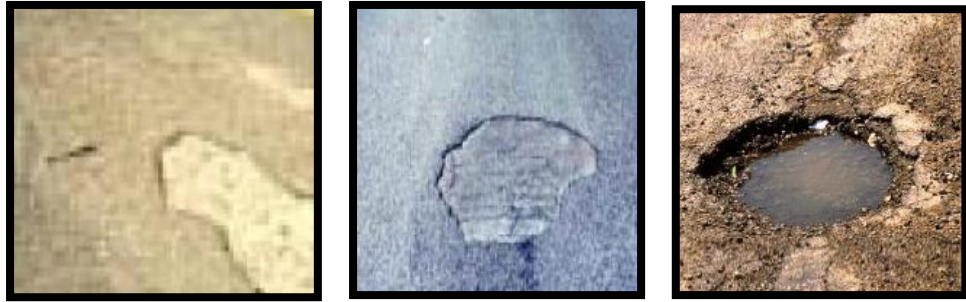
Figura N°53. Niveles de severidad para huecos
