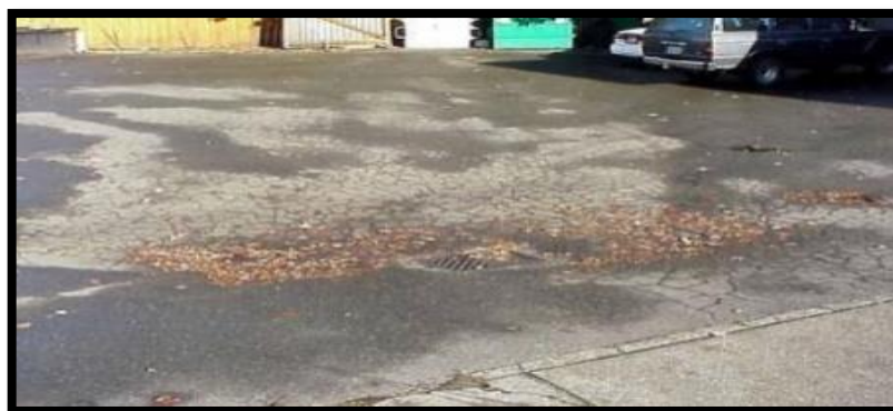
Figura N° 20. Piel de cocodrilo nivel M
