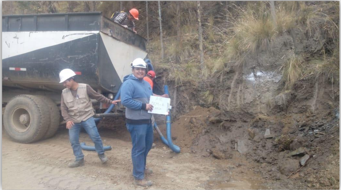
FOTOGRAFIA N°01: INSTALACIÓN DE CISTERNA PARA LA APLICACIÓN DEL CLORURO DE CALCIO
