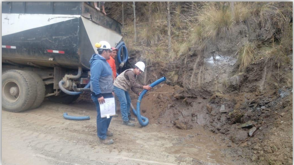
FOTOGRAFIA N°01: INSTALACIÓN DE CISTERNA PARA LA APLICACIÓN DEL CLORURO DE CALCIO
