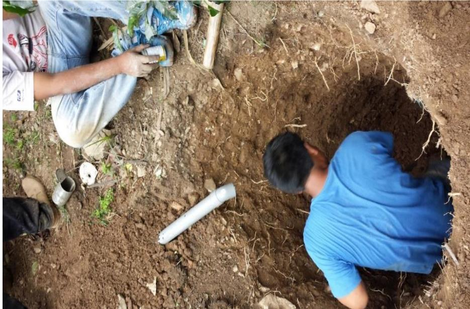
**Figura 59.** Se procedió a la excavación del pozo percolador
