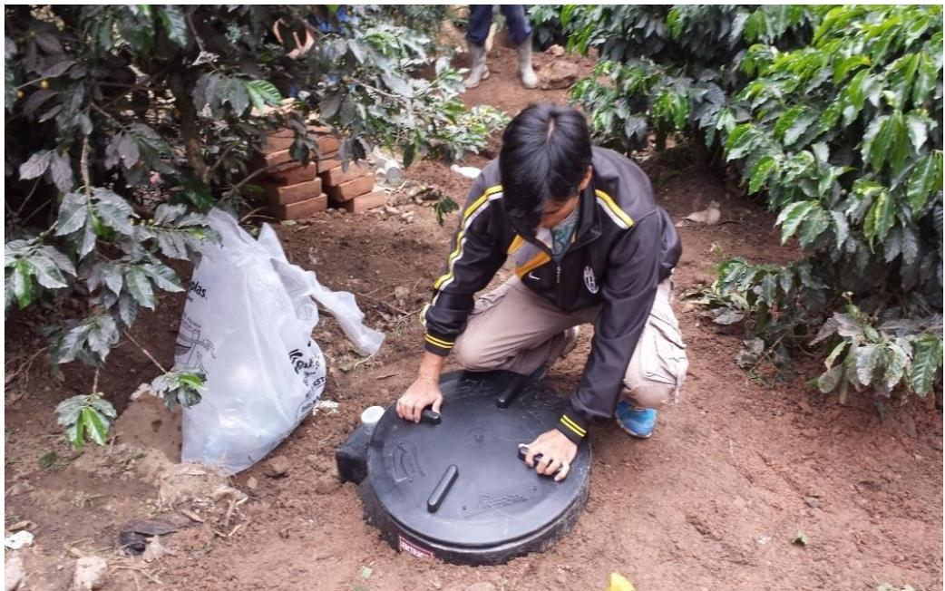
**Figura 54.** sellado hermético de la tapa del biodigestor, para evitar el ingreso de aire, para lo cual se hizo uso de una cinta teflón para un sellado más eficiente.
