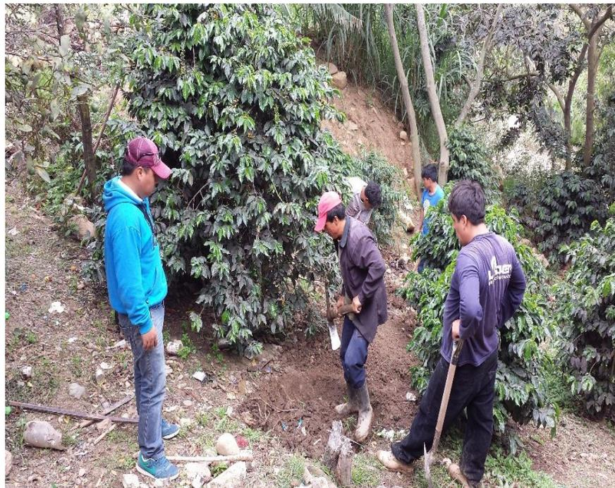
**Figura 38.** Como el terreno es estable la excavación debe ser 30 cm mayor al diámetro del Biodigestor.
