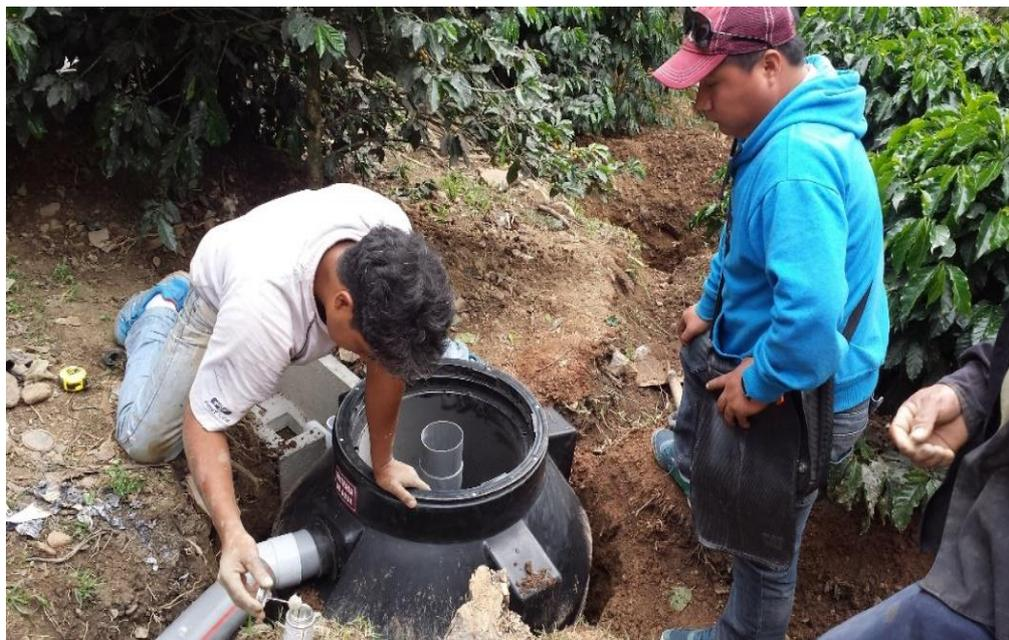
**Figura 48.** Unión tubería de llegada – Biodigestor con pegamento PVC.
