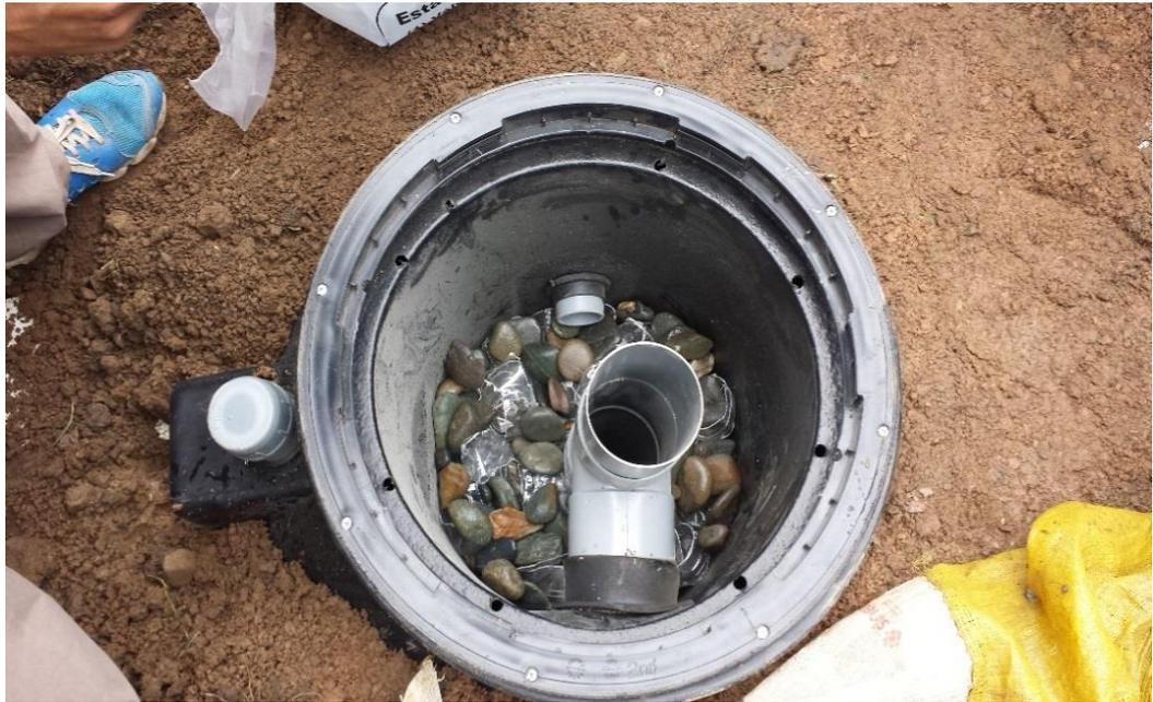
**Figura 53.** Se colocó las piedras planas dentro y así evitar que sean arrastrados por la tubería de salida de 2" y la vayan a obstruir.
