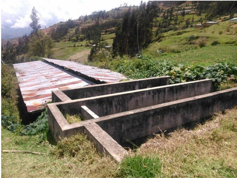
Figura 21. Estado actual de la planta de tratamiento de aguas residuales de la comunidad de Ñausa.
