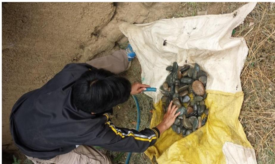
**Figura 52.** Se debe agregar una capa de piedras planas para mantener estables los aros, para lo cual se procedió a lavar las piedras.
