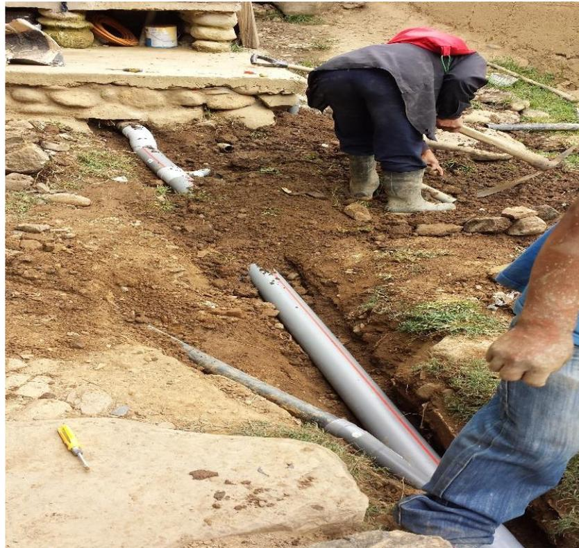
**Figura 37.** Instalación de la tubería de llegada del UBS hacia el Biodigestor.
