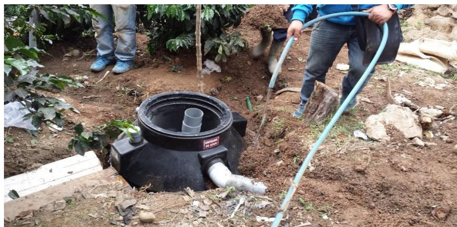
**Figura 46.** Luego se compacta vertiendo agua para tener mayor estabilidad.
