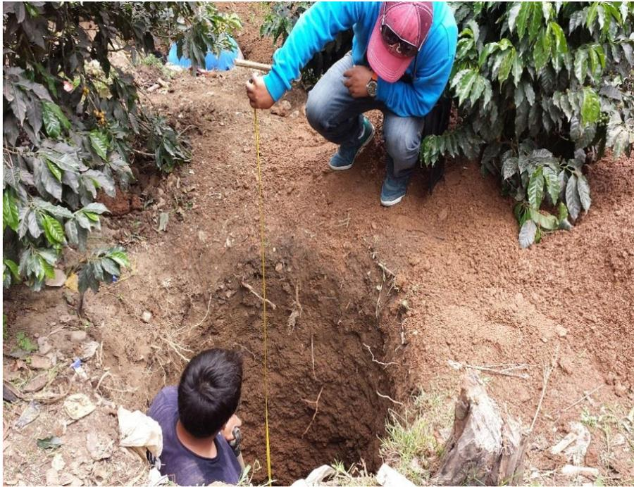
Figura 39. Se realiza la medición de la profundidad, para este caso  $H=1.85$ , según las medidas de fabricante y la compactación de la base.
