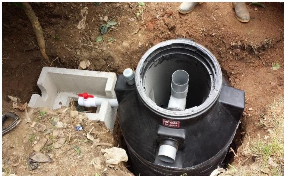
**Figura 58.** Finalmente se coloca la válvula y la caja de concreto la misma que no tiene fondo para que pueda infiltrarse en el terreno el agua contenida en los lodos.
