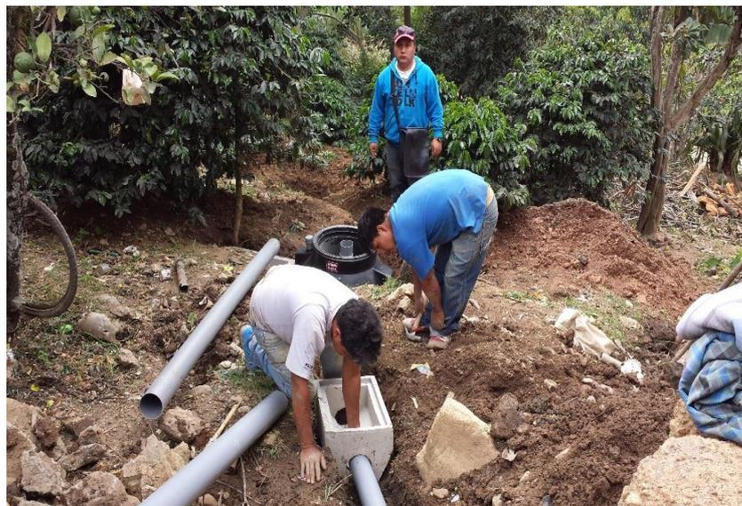
Figura 44. Posteriormente a la colocación se procede a conectar con la tubería de llegada proveniente de la UBS.
