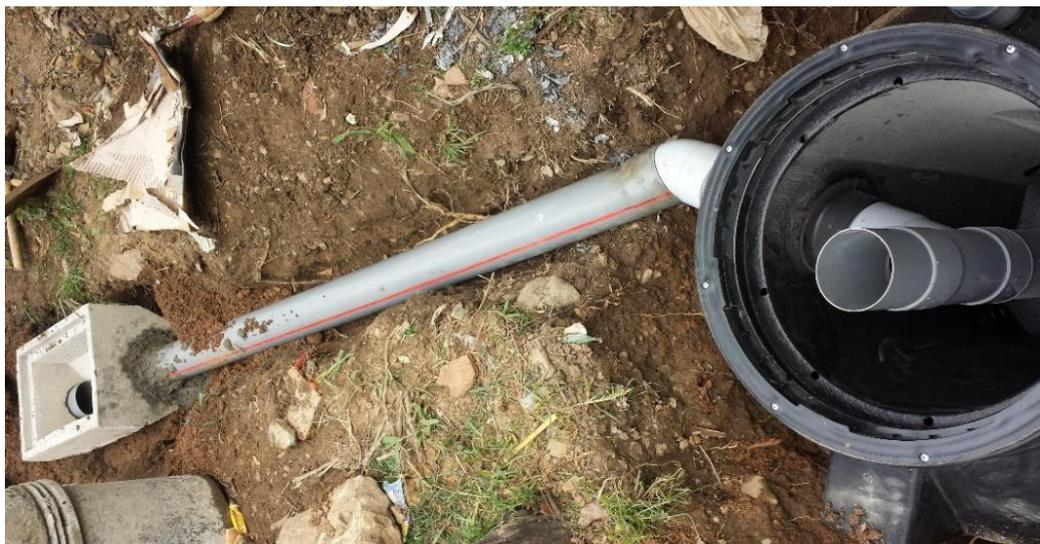
**Figura 47.** Unión tubería – caja registro - Biodigestor.
