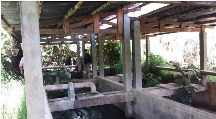
Figura 20. Situación actual del lecho de secado de la planta de tratamiento del centro poblado de Ñausa
