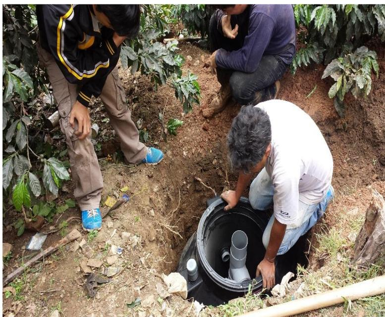
Figura 42. Se procede a nivelar horizontalmente el Biodigestor.
