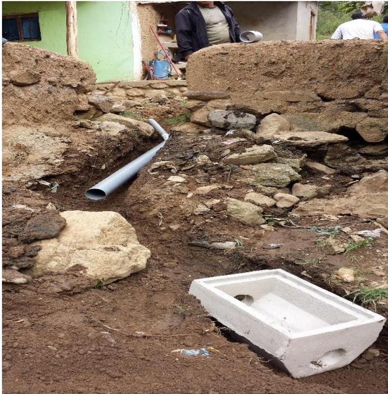
Figura 43. Se procede a instalar la caja de registro que también tiene la función de caja rompe presión, ya que existe un desnivel de 2m aprox.
