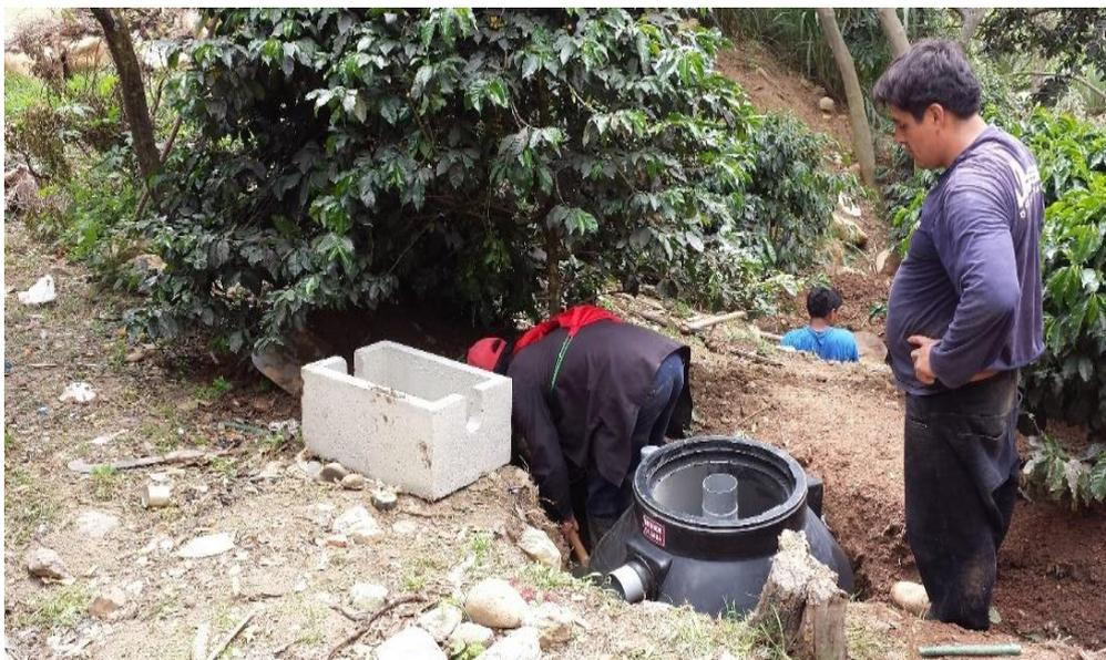
**Figura 56.** Excavación para la instalación de la caja de lodos.
