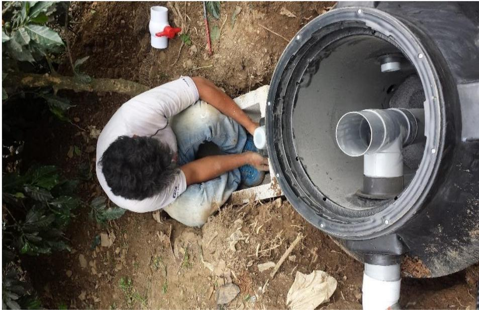
**Figura 57.** Se procede a la conexión empalmando la tubería de salida
