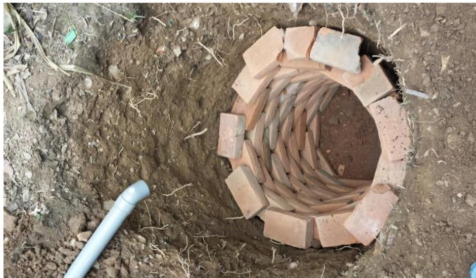
**Figura 60.** Colocación de los ladrillos de arcilla que serán las paredes laterales del pozo percolador.
