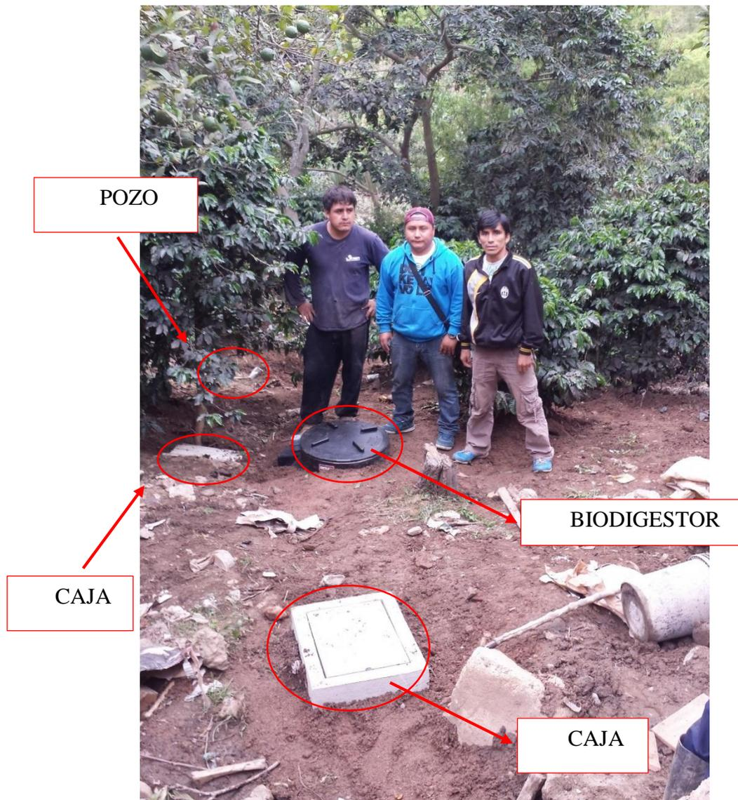
**Figura 61.** Culminación del proceso de instalación.
