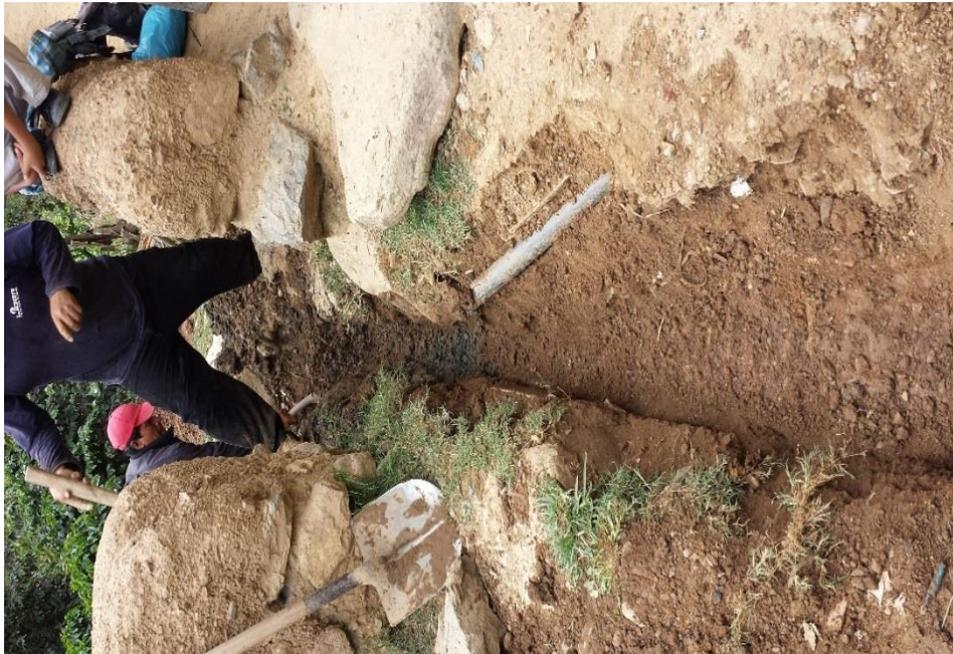
**Figura 35.** Excavación de zanja para tubería de llegada
