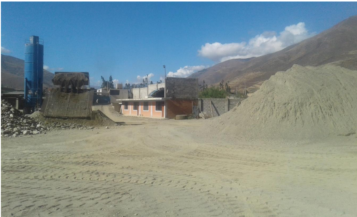
Fotografía N°8: Zarandeo y acopio de agregado fino (Arena)
