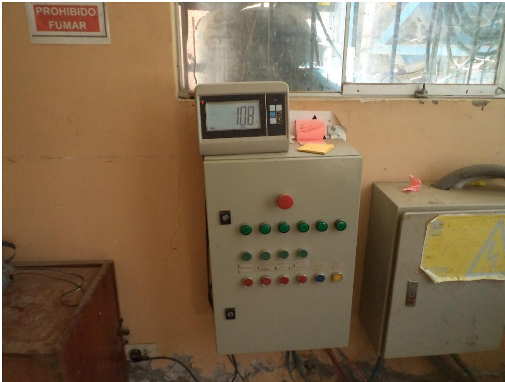
Fotografía N°3: Control del silo del cemento y tolva de agregados
