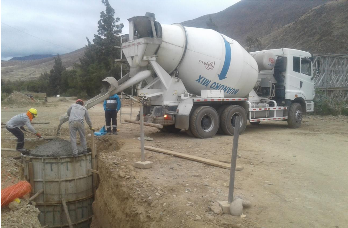
Fotografía N°9: Se observa el vaciado de un buzón con el mixer.
