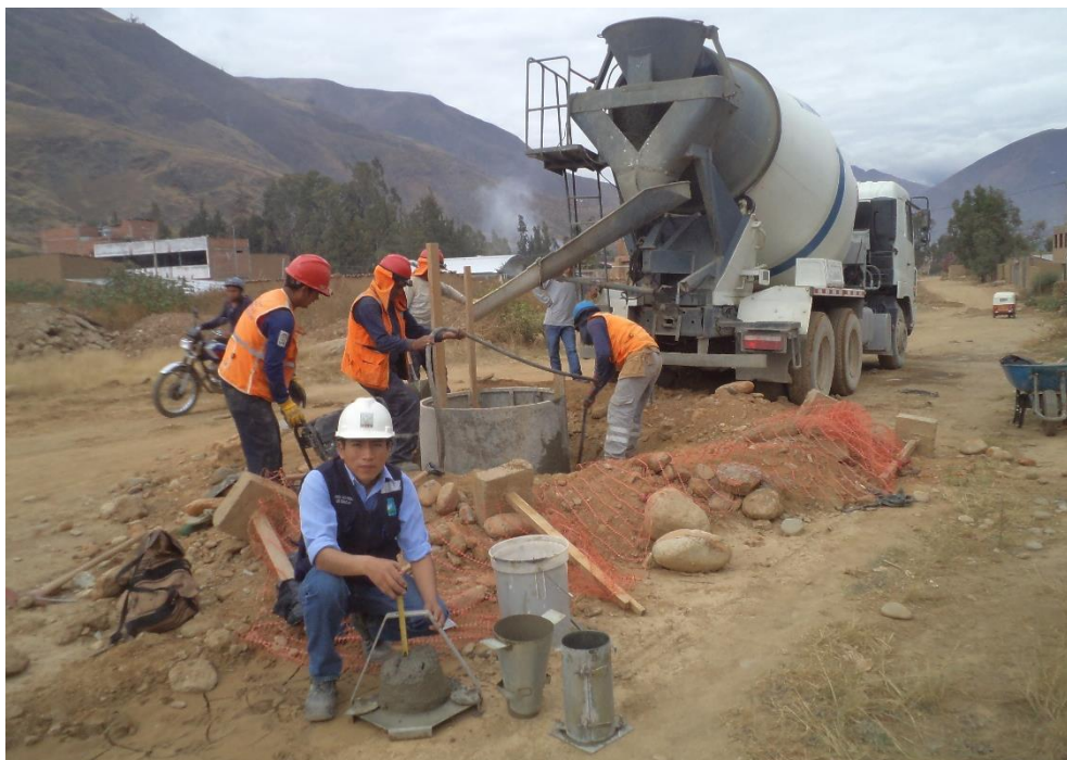
Fotografía N°12: Control de revenimiento del concreto premezclado ensayado con el cono de abrams, realizado por el vía colectora (Jancao).
