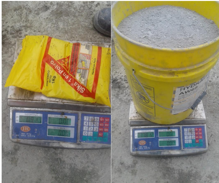
Fotografía N°6: Dosificando el impermeabilizante Sika1
