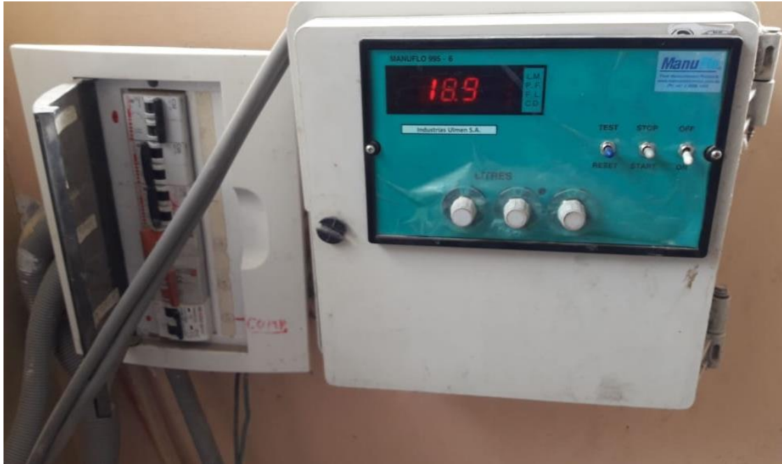
Fotografía N°5: Control del Aditivo AT-56
