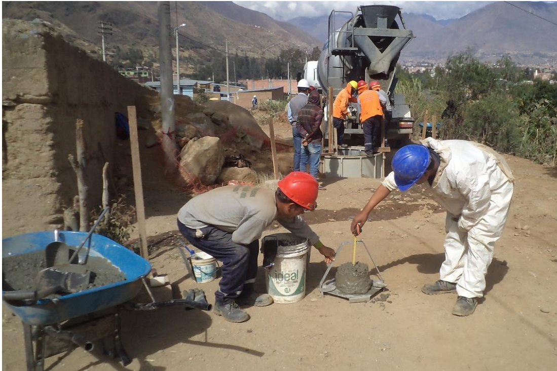
Fotografía N°13: Control de revenimiento realizado con el cono de abrams.
