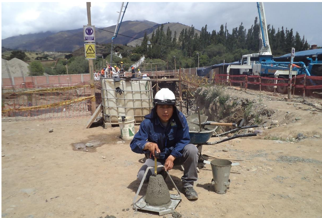
Fotografía N°18: Midiendo el slump del concreto recepcionado en la PTAR
