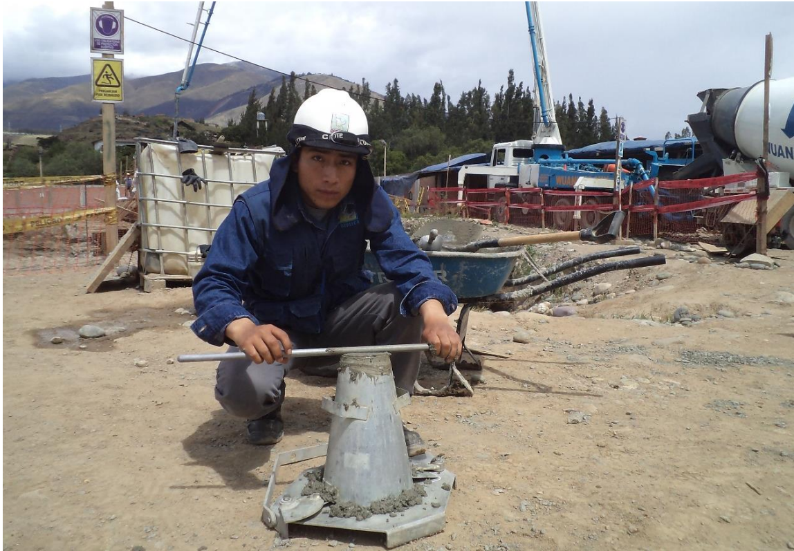
Fotografía N°17: Realizando el ensayo de revenimiento del concreto con el cono de abrams
