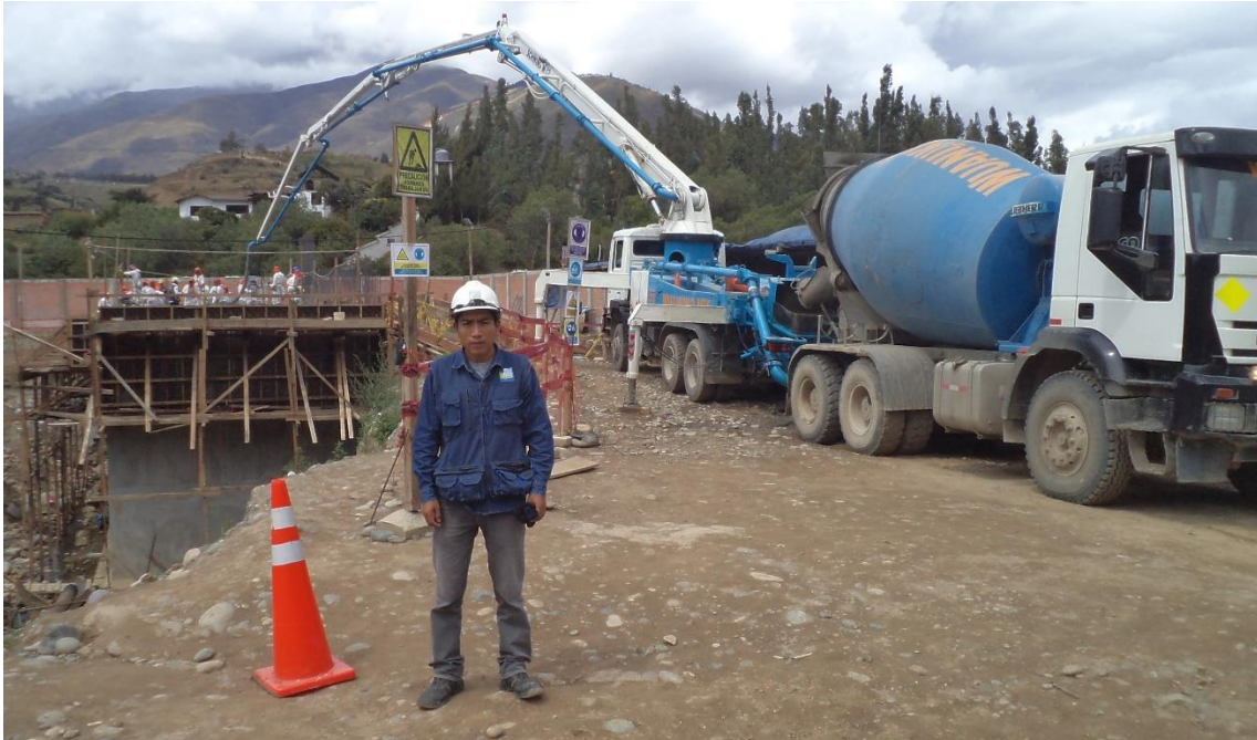
Fotografía N°15: Recepción del concreto premezclado en el Vaciado del Reactor Biológico de la PTAR.
