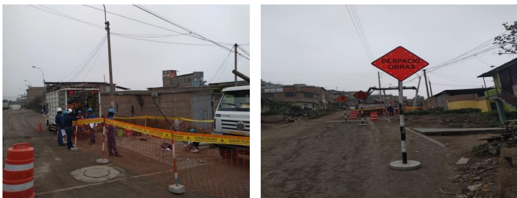
Imagen N° 21. Inspecciones planeadas a la Señalización
