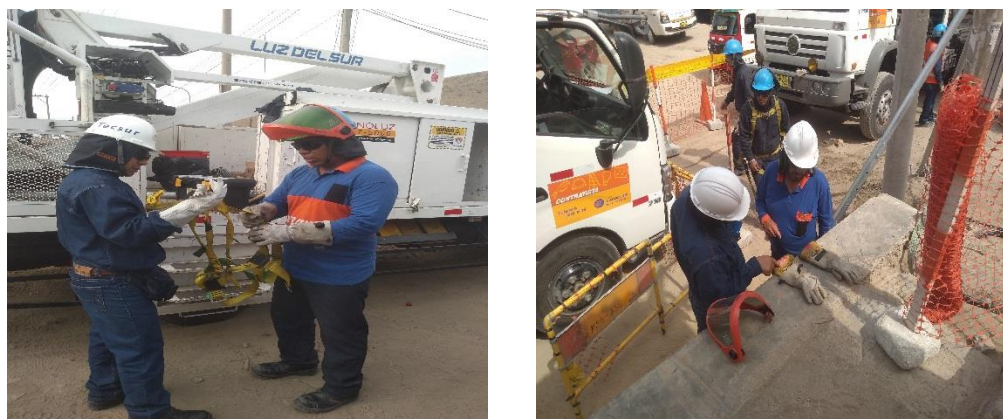
Imagen N° 5. Inspecciones Planeadas de EPPs
