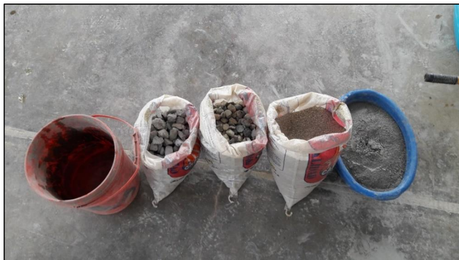
Figura N° 30 Almacenamiento y preparación de materiales.
