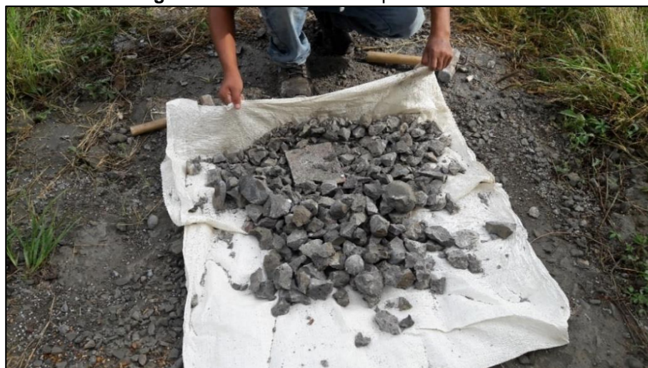
Figura N° 09 Trituración manual de bloques de concreto.
