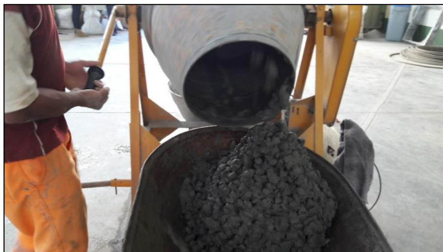
Figura N° 32 Tanda de concreto mezclado.
