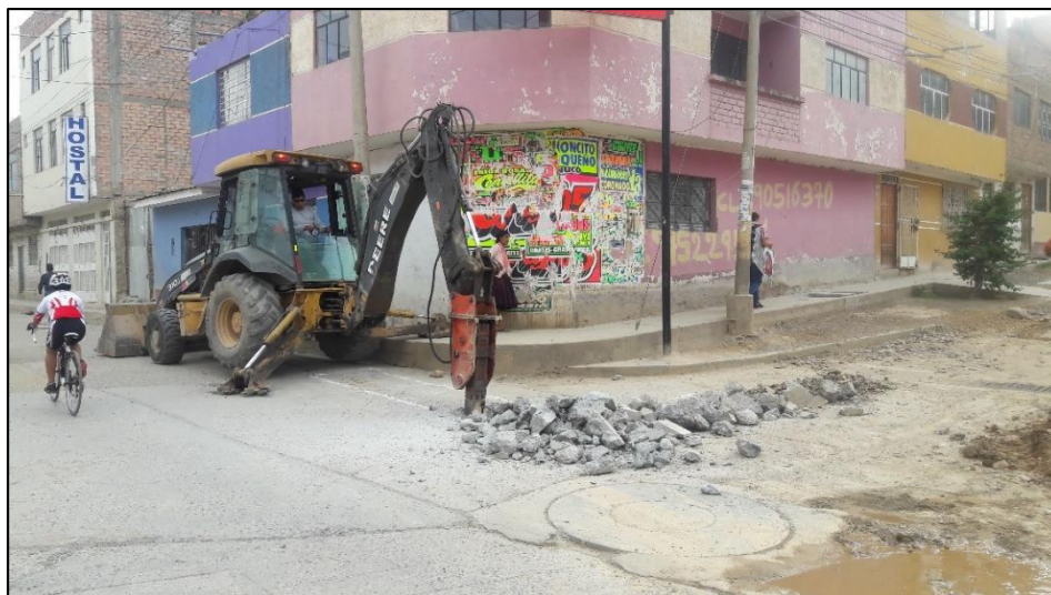
Figura N° 05 Trabajos de demolición del pavimento rígido
