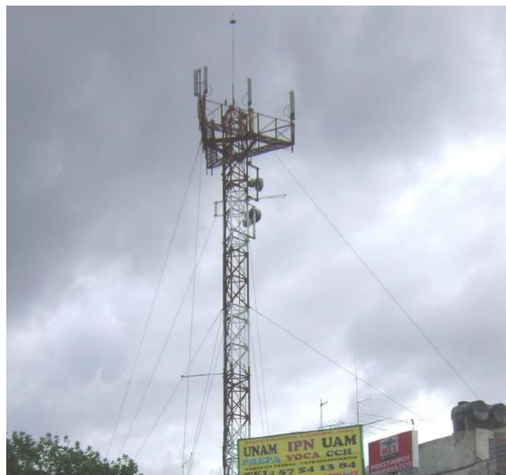
Figura 17. Vista de la torre arriostrada
