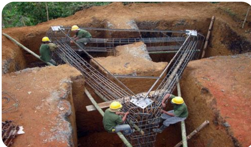
Figura 29. Cimentación para torre autosoportadas triangular
