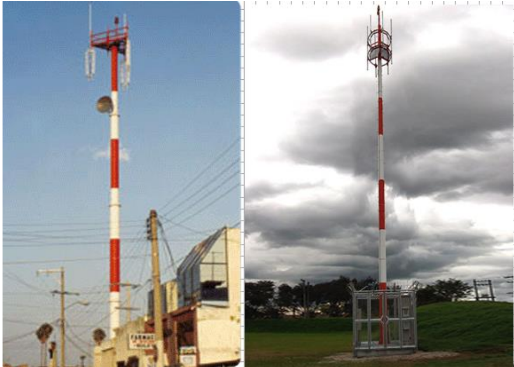
Figura 13. Vista de monopolo de plataforma triangular y circular
