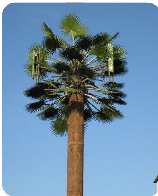
Figura 27. Mimetizado de torre monopolo tipo árbol de palmera
