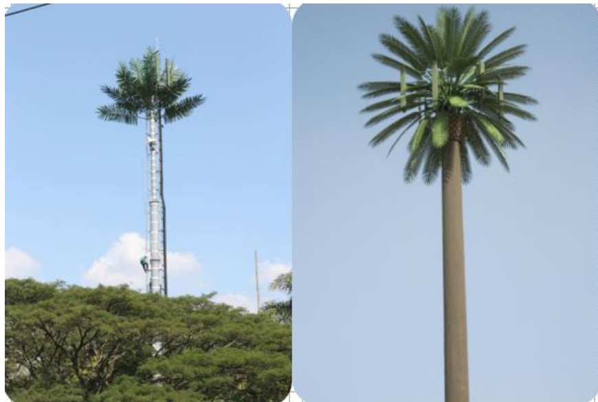
Figura 14. Vista de monopolo Tipo Palmera
