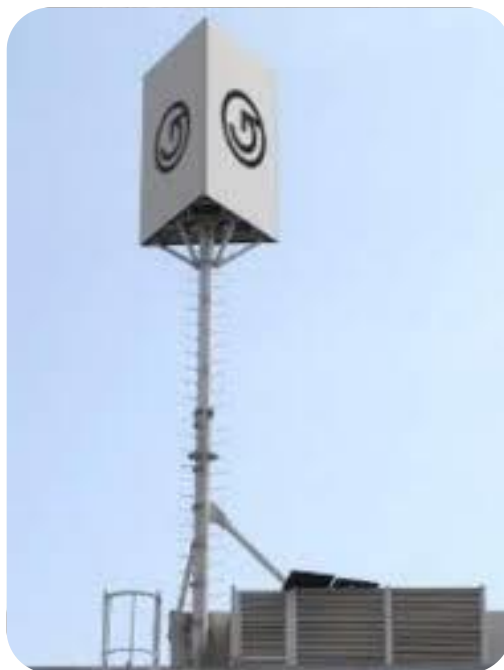
Figura 25. Mimetizado de torre arriostrada tipo panel triangular
