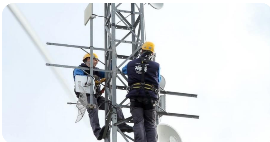
Figura 19. Línea de vida para operario
