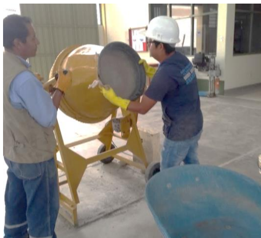
Figura 24. Foto del habilitado de la Mezcladora de Concreto. Elaboración propia.
