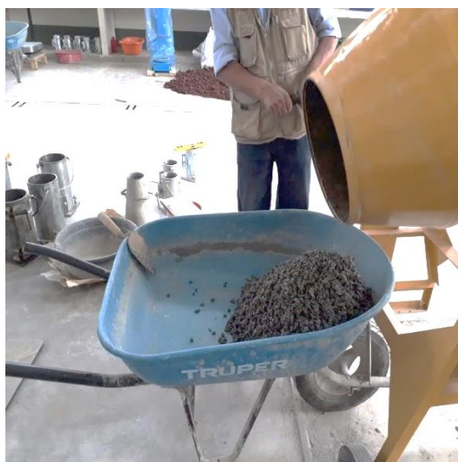
Figura 26. Foto de la colocación de Concreto en Buggy. Elaboración propia.
