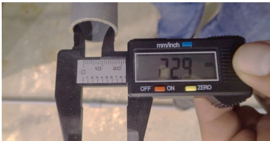
Fotografía 13. Verificación del Diámetro Interno de la Tubería. PVC-U Ø 3/4".
