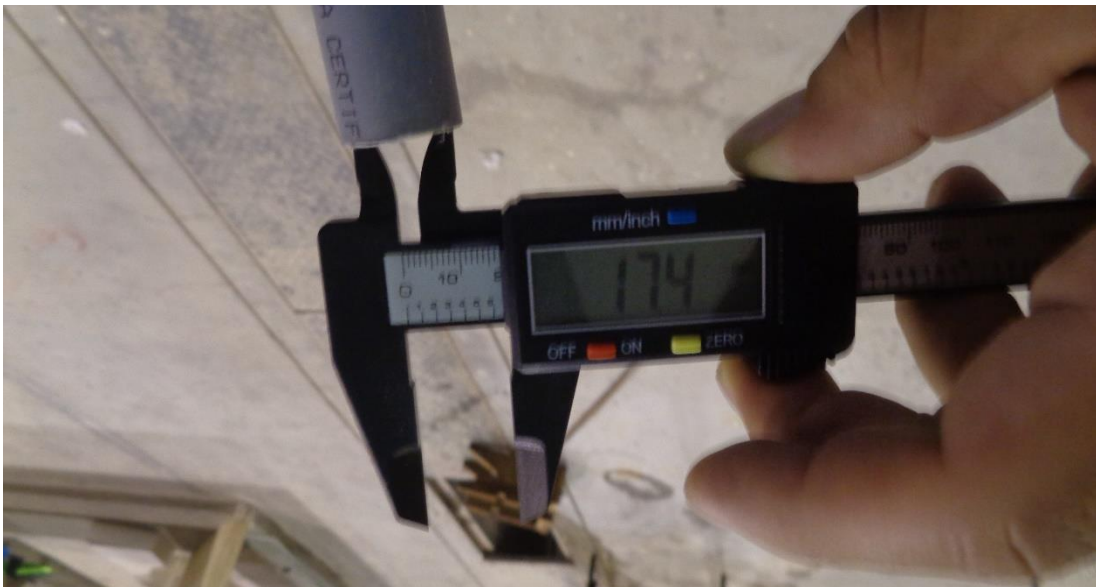
Fotografía 9. Verificación del Diámetro Interno de la Tubería. PVC-U Ø 1/2".
