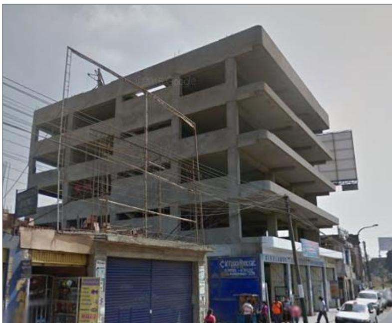
Figura 1-2-A: Edificación de cinco niveles de pórticos de concreto armado, ubicada en la Av. Metropolitana, del distrito de Comas.
