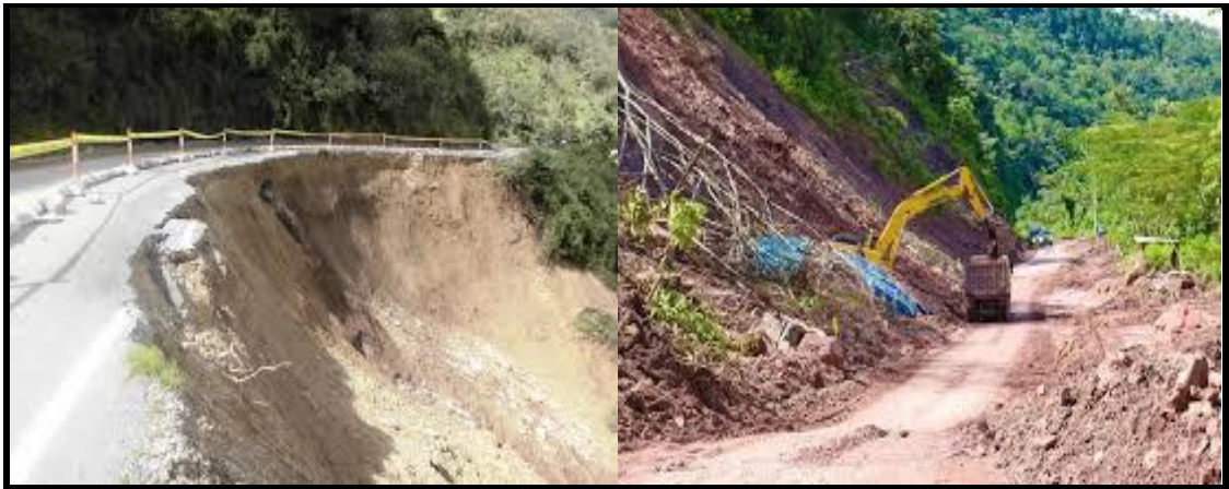
Figura 5: Vistas de carreteras: pavimento flexible, carretera colapso de su plataforma y carretera en construcción.
