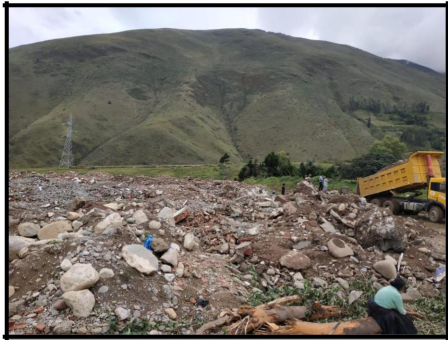
Imagen 21: Traslado de desmorte a la Escombrera designada para la construcción del colegio INDUSTRIAL HERMILIO VALDIZAN
