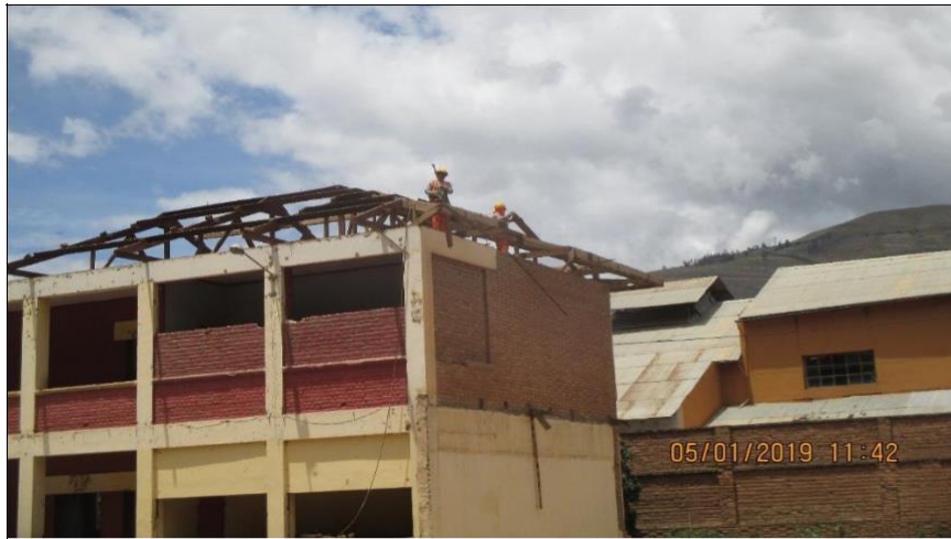
Imagen 18: Desmontaje del colegio INDUSTRIAL HERMILIO VALDIZAN
