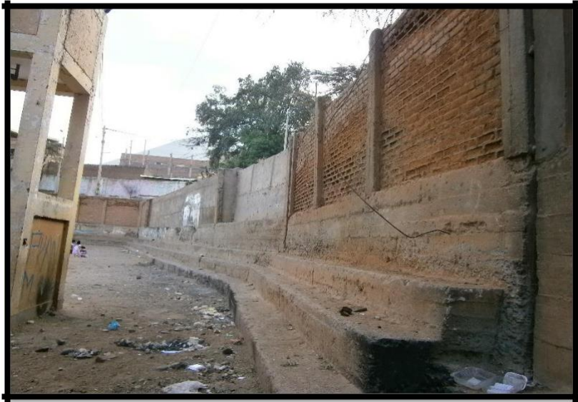
Imagen 3: Cerco Perímetro del Colegio SAN PEDRO
