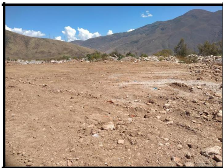
Imagen 27: Trabajos de Remediación en la Escombrera
