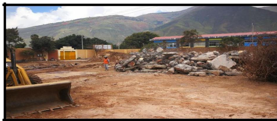
Imagen 8: Demolición completa del colegio SAN PEDRO
