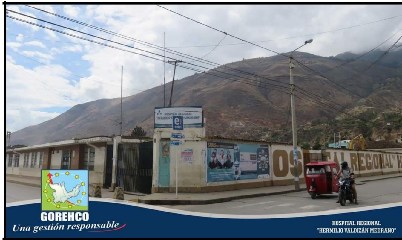
Imagen 9: Vista frontal del HOSPITAL HERMILIO VALDIZAN, antes de ser demolido
