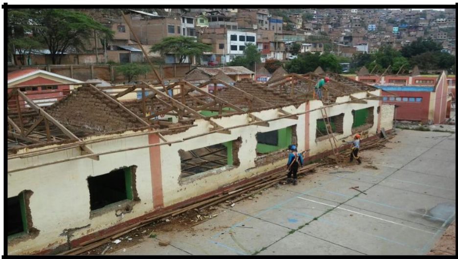
Imagen 6: Desmontaje del colegio SAN PEDRO
