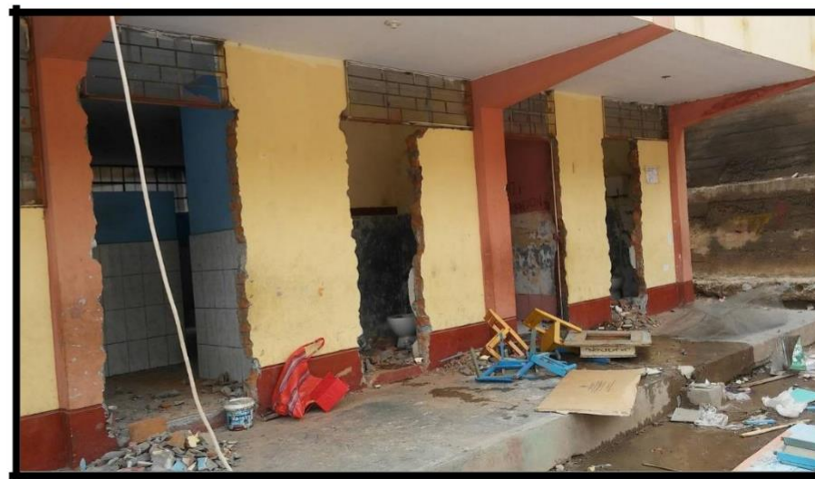
Imagen 7: Demolición de los servicios higiénicos
