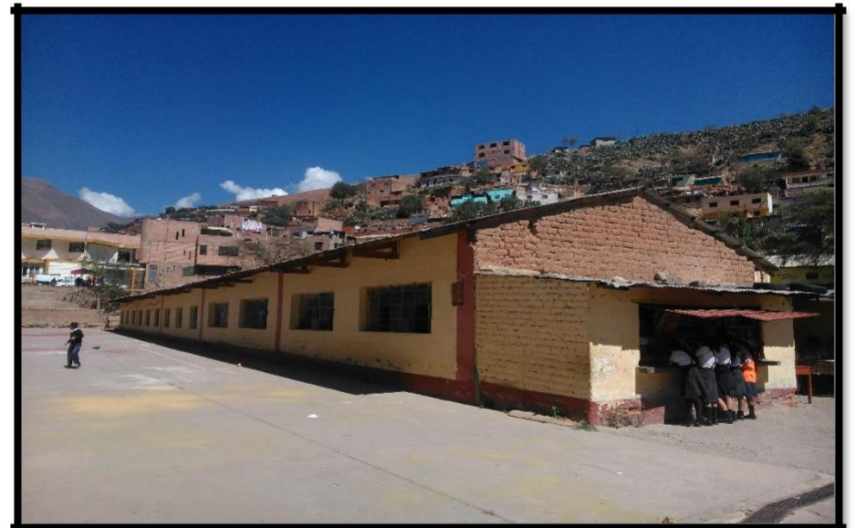
Imagen 2: Infraestructura interior del SAN PEDRO
