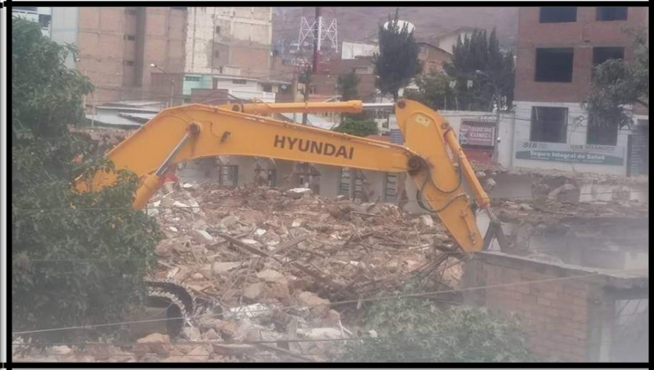
Imagen 11: Demolición inicial por módulos del Hospital
