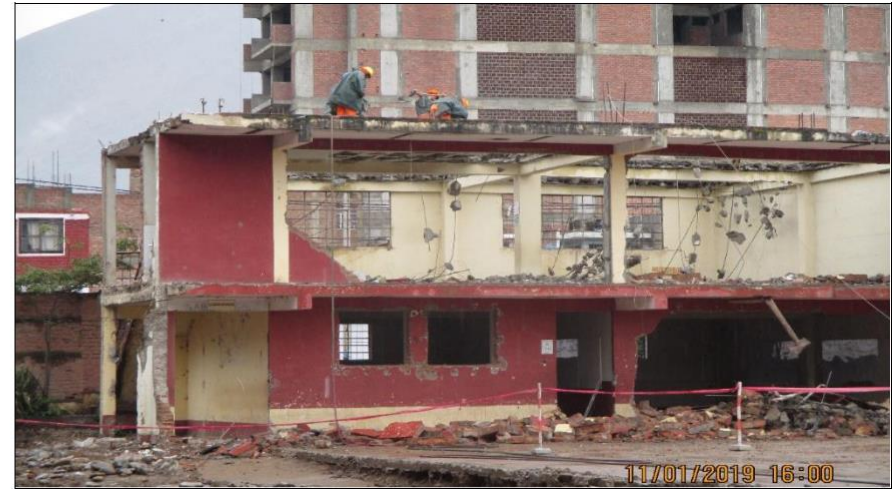
Imagen 19: Demolición parcial de los pabellones antiguos
