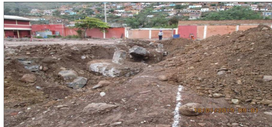
Imagen 20: Demolición total del colegio INDUSTRIAL HERMILIO VALDIZAN
