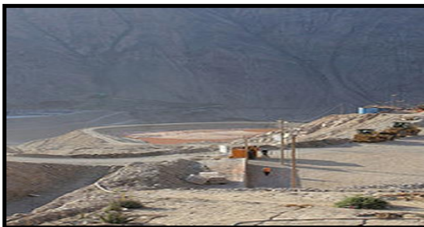
Figura 10. Muestra la “Relavera A” de la Minera SOTRAMI S. A. (otra posible relavera para recrecimiento vertical), donde se puede apreciar Área de Corona del Depósito de Relaves, a escasos 10% de su vida útil.
