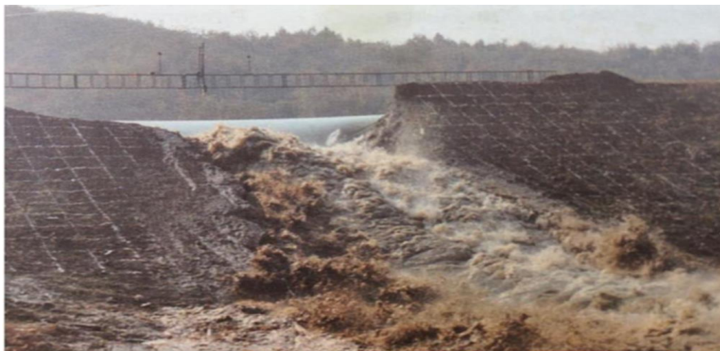
FIGURA 2. Muestra la Rotura del Talud de un Depósito de Relaves por (2) dos efectos fundamentales: 1. Haber sobre pasado el 10% de alcance a la plataforma de corona y 2. Falta del control de su impermeabilización. (Quisca, I. 2018).
