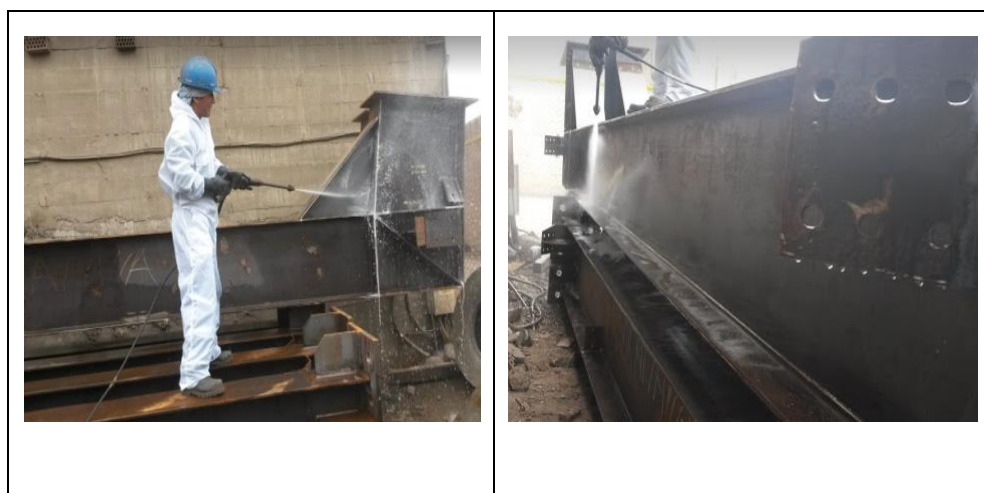
Gráfico 3: Lavado de estructuras metálicas Fuente: Elaboración propia
