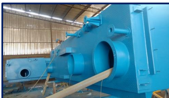
Gráfico 22: Aplicación de la 1 capa de refuerzo
