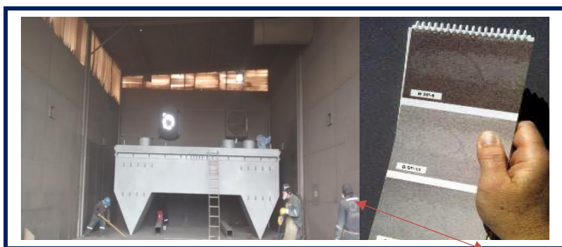
Gráfico 6: Barcaza granallada según SSPC-SP5
