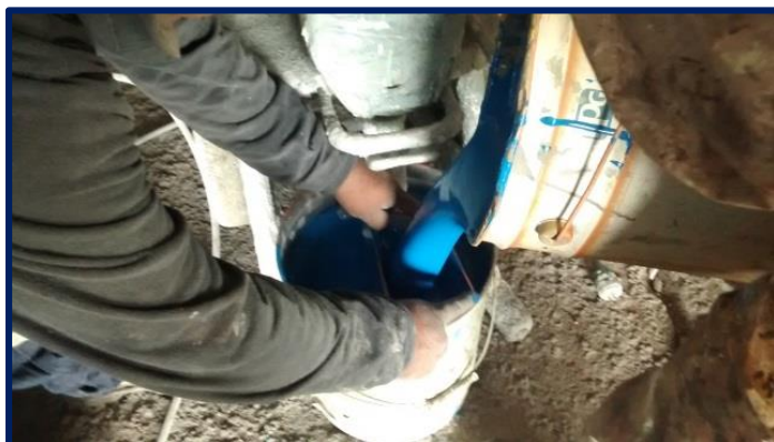
Gráfico 15: Filtrado de la pintura preparada Fuente: Elaboración propia
