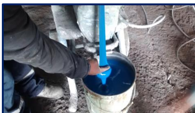
Gráfico 17: Homogenización y Filtrado de la segunda capa Fuente: Elaboración propia
