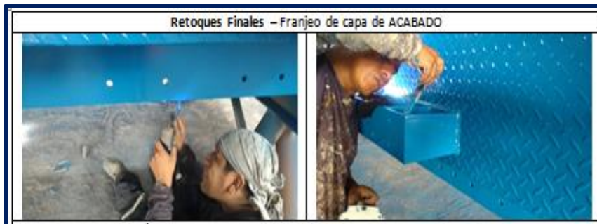
Gráfico 23: Aplicación de la capa de refuerzo (Stripe coat) Fuente: Elaboración propia
