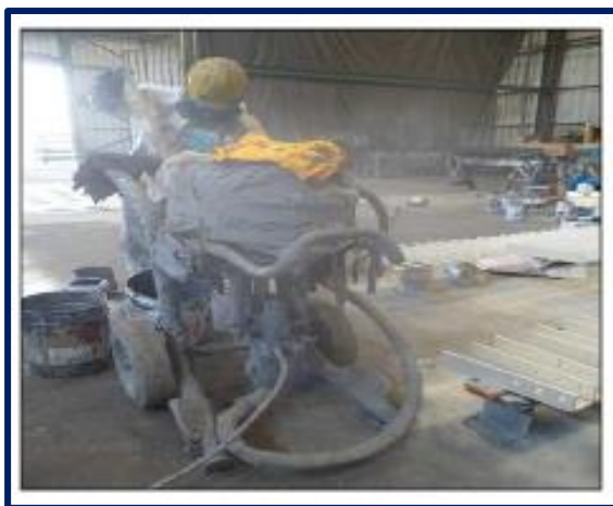
Gráfico 19: Equipo airless neumático durante la aplicación de la segunda capa Fuente: Elaboración propia
