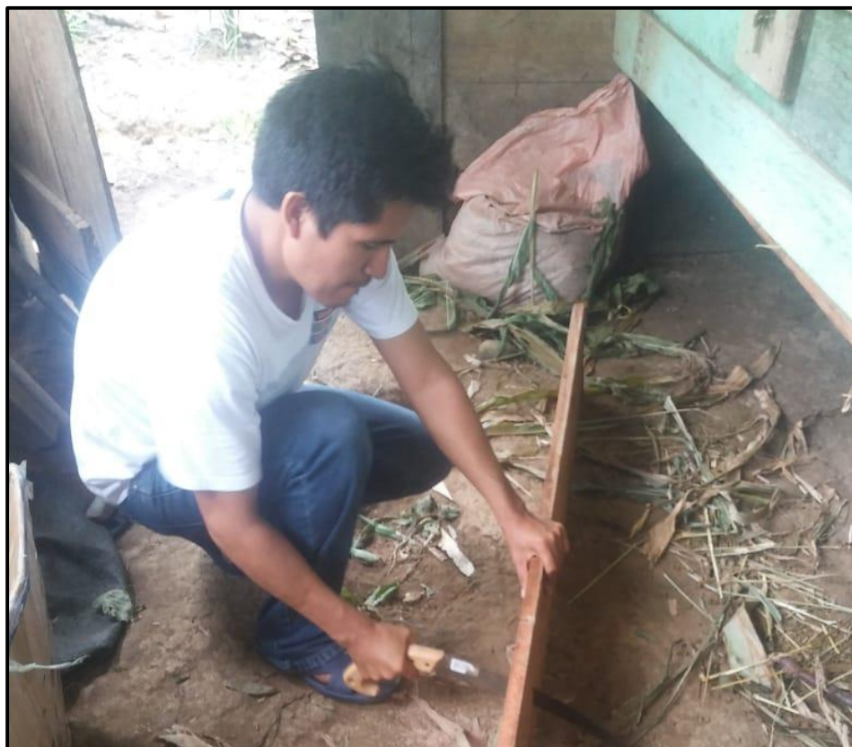
Figura 19. Construcción de galpones.
