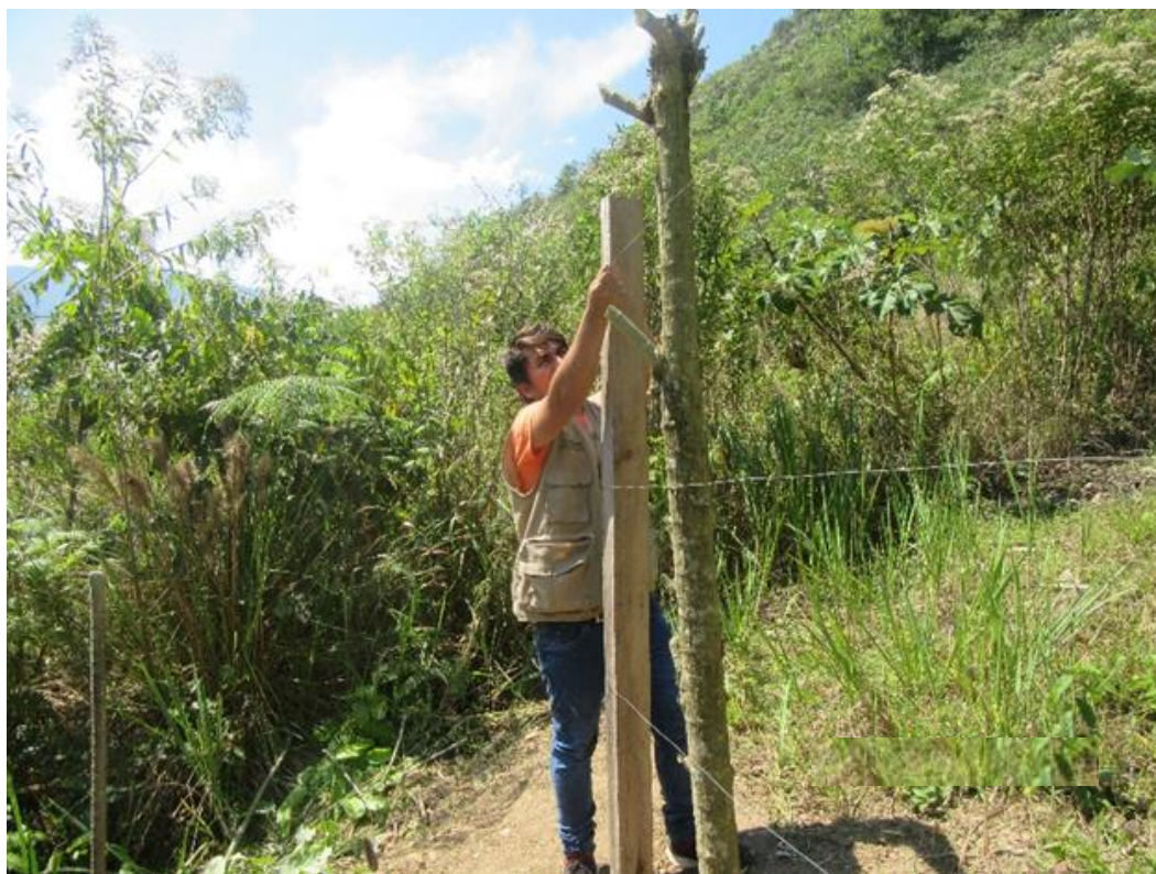
Figura 04. Templado en tres hileras de alambre Galvanizado N° 14.
