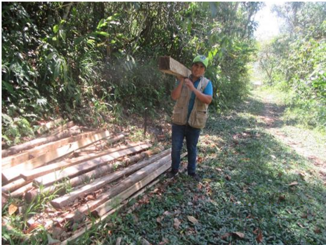
Figura 03. Traslado de postes templadores de 2.5 m.
