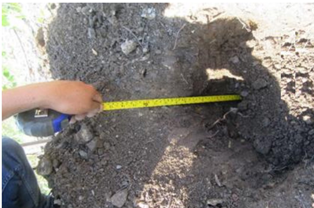
Figura 06. Hoyado de 25 x 25 x 30 cm (Largo, ancho y profundidad).
