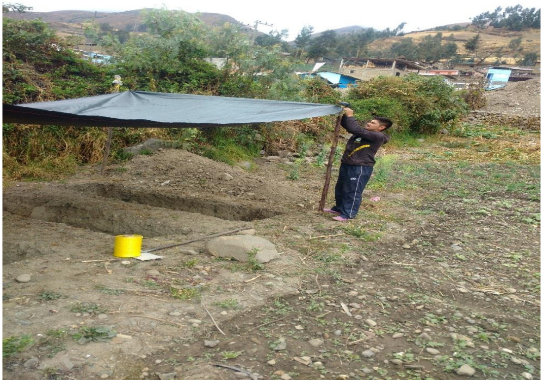
Foto 4: construcción de tinglado.
