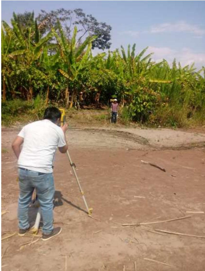
**Foto N°07:** Instalación de la Estación Total (estación 01).
